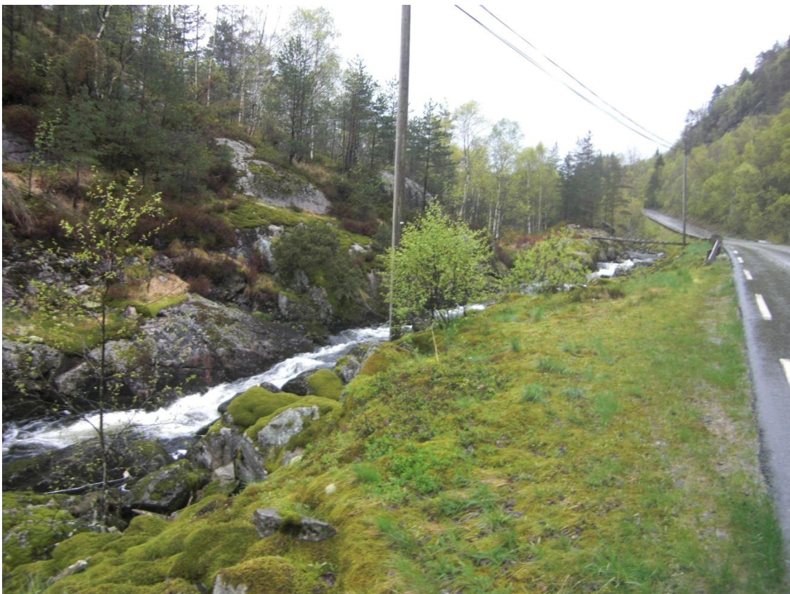
FIGUR 24: ØVRE DEL AV TILTAKSOMRÅDET AV FLIKKABEKKEN.
