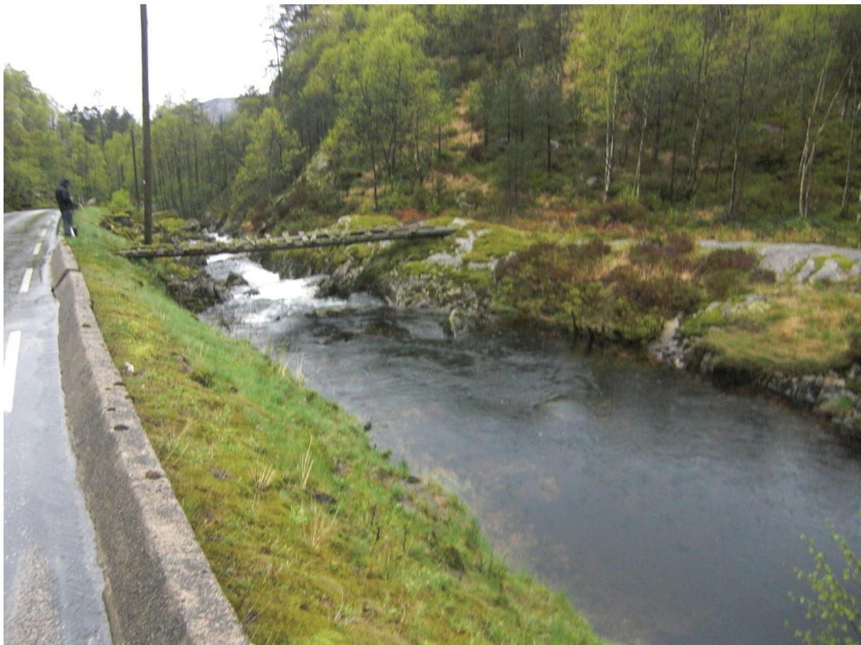
FIGUR 6: BILDET VISER INNTAKSOMRÅDET FOR KRAFTVERKET
