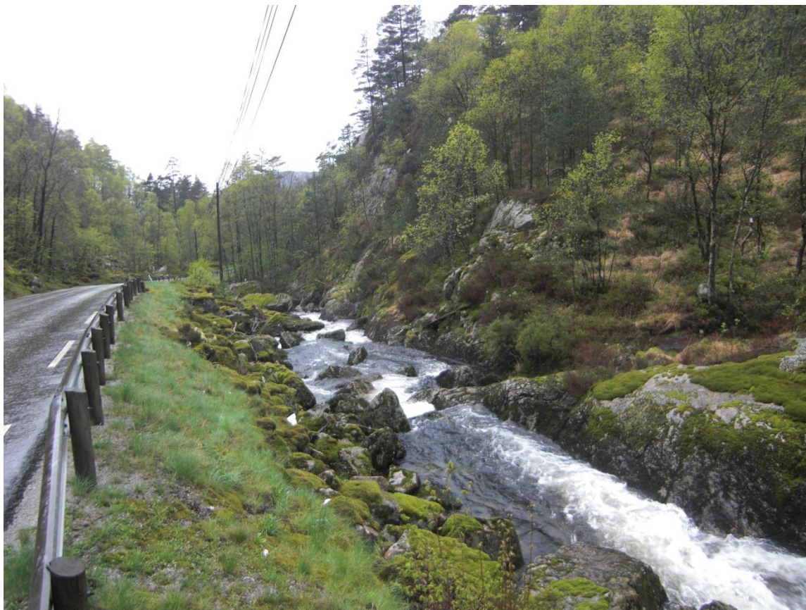
FIGUR 21: BILDET VISER INNTAKSOMRÅDET. TUNNEL VIL BLI ANLAGT PÅ HØGRE SIDE AV BEKKEN.
