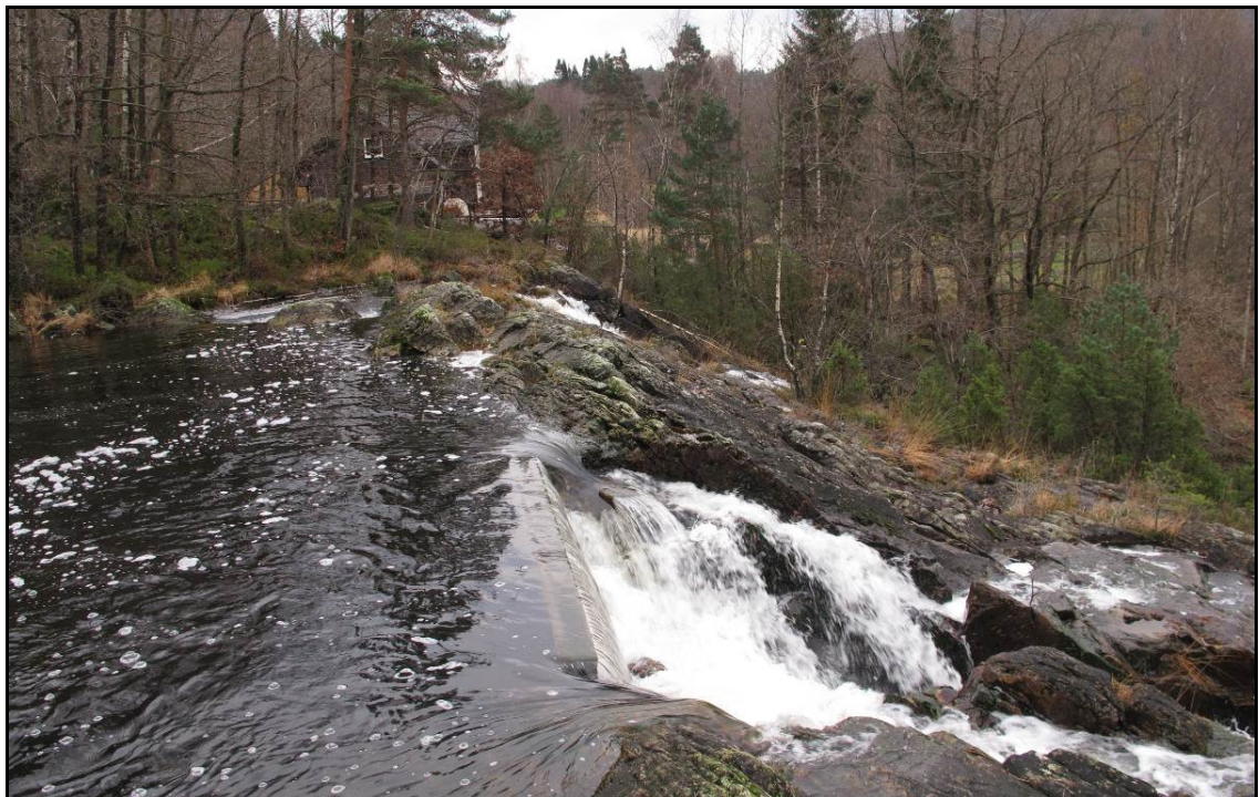
Figur 8. Terskel i forbindelse med et gammelt kraftverk. Foto: Bjarne Oddane.
