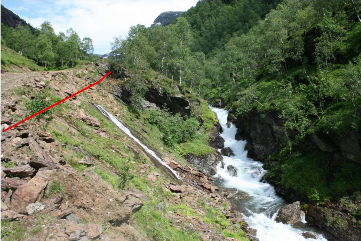
Figur 3 Rørgatetrasè i øvre del. Rørgata plasseres i veien som må sprenges et stykke ned for å klare å passere høyden på veien i øvre del av figuren
