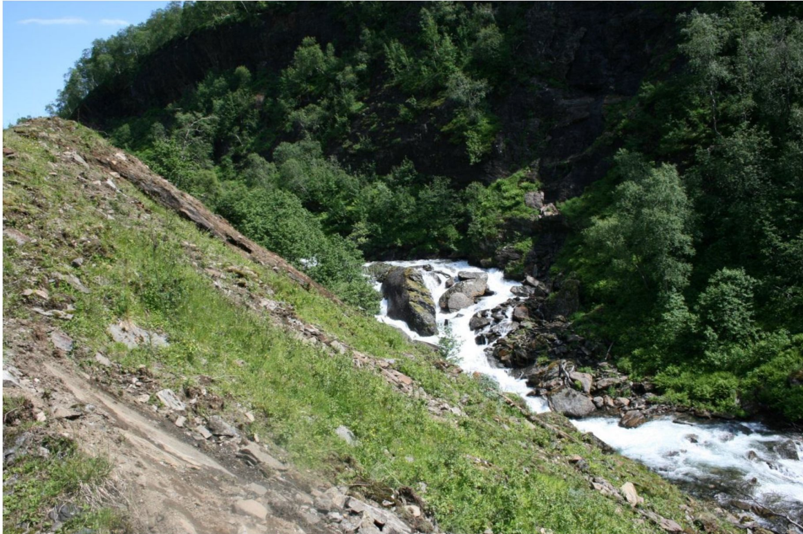
Figur 5 Bjørndalselva ca midtveis langs rørgaten
