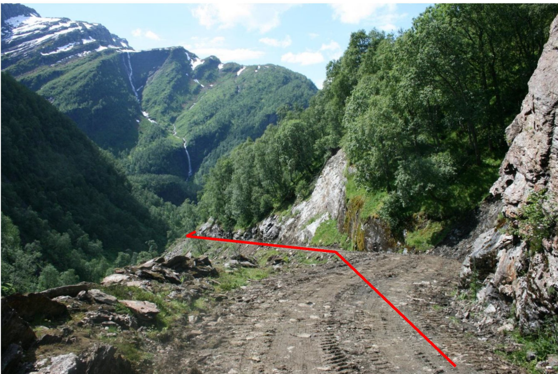
Figur 4 Rørgata legges i eksisterende vei hele veien fra inntak til kraftstasjon
