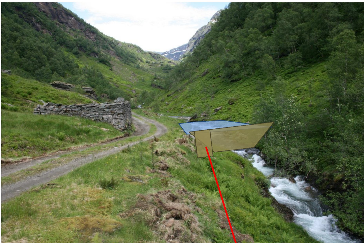
Figur 2 Dam, inntak, vannvei og oppdemt areal
