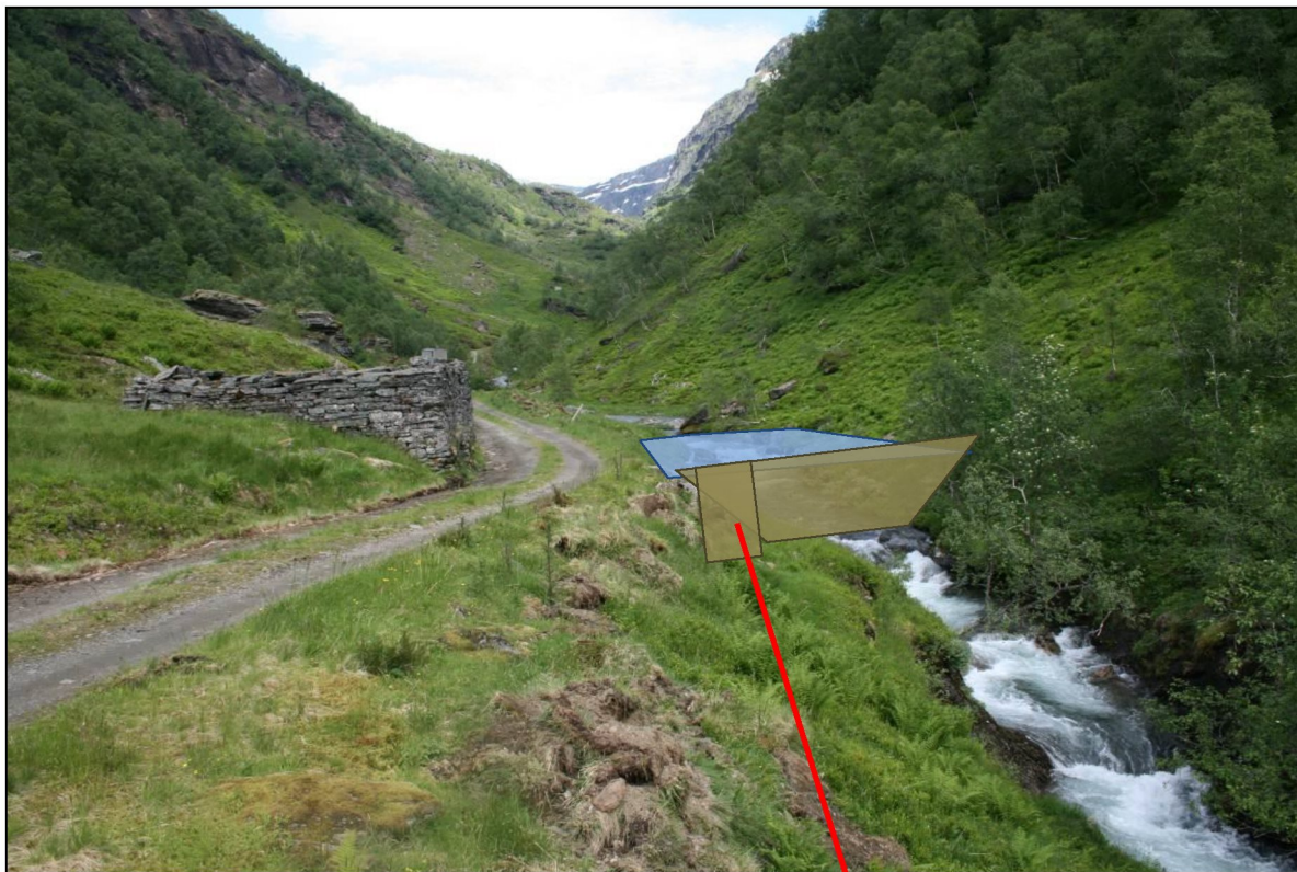
Figur 9 Dam, inntak, vannvei og oppdemt areal.
