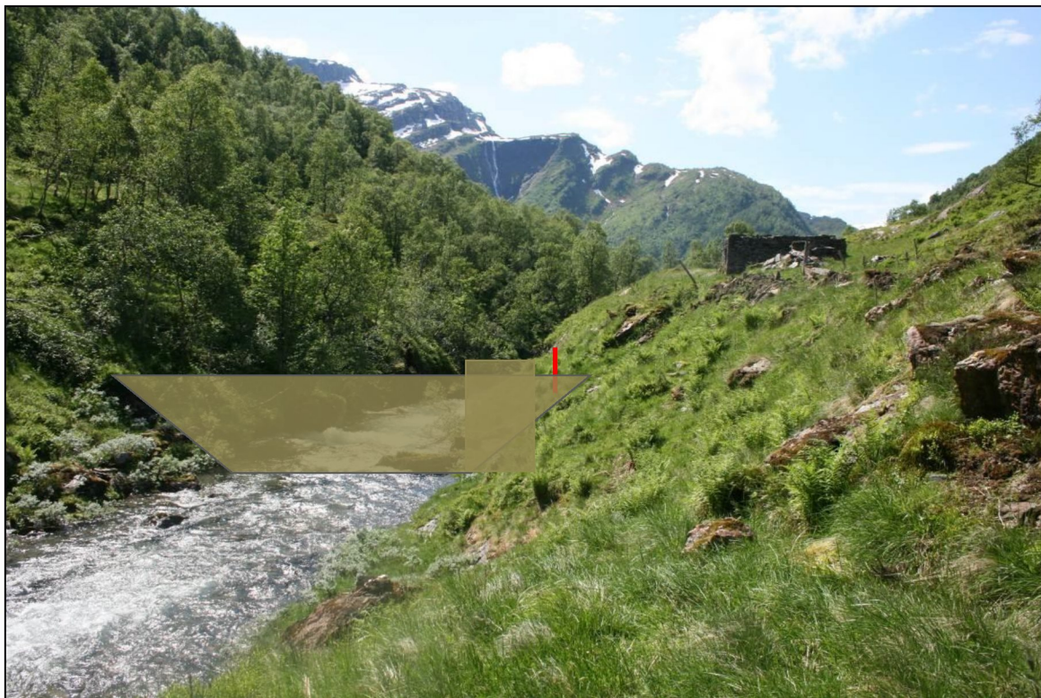
Figur 8 Dam, inntak og start på rørgate.
