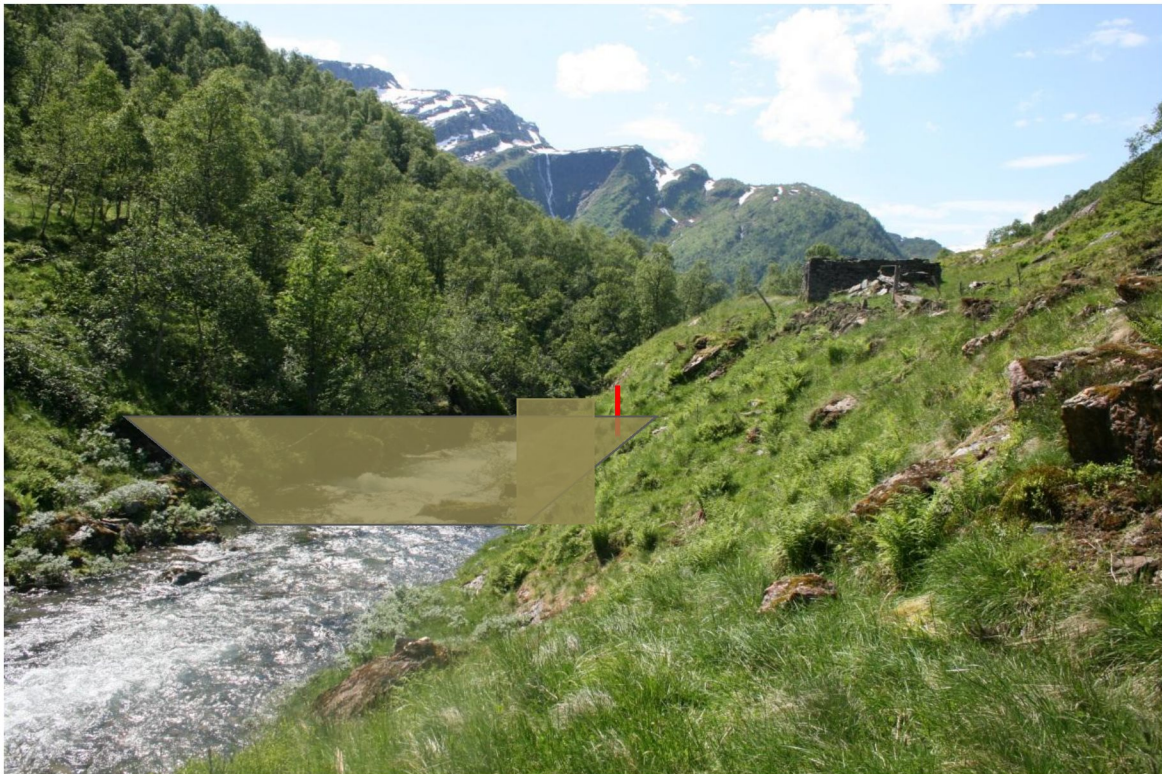
Figur 1 Dam, inntak og start på rørgate
