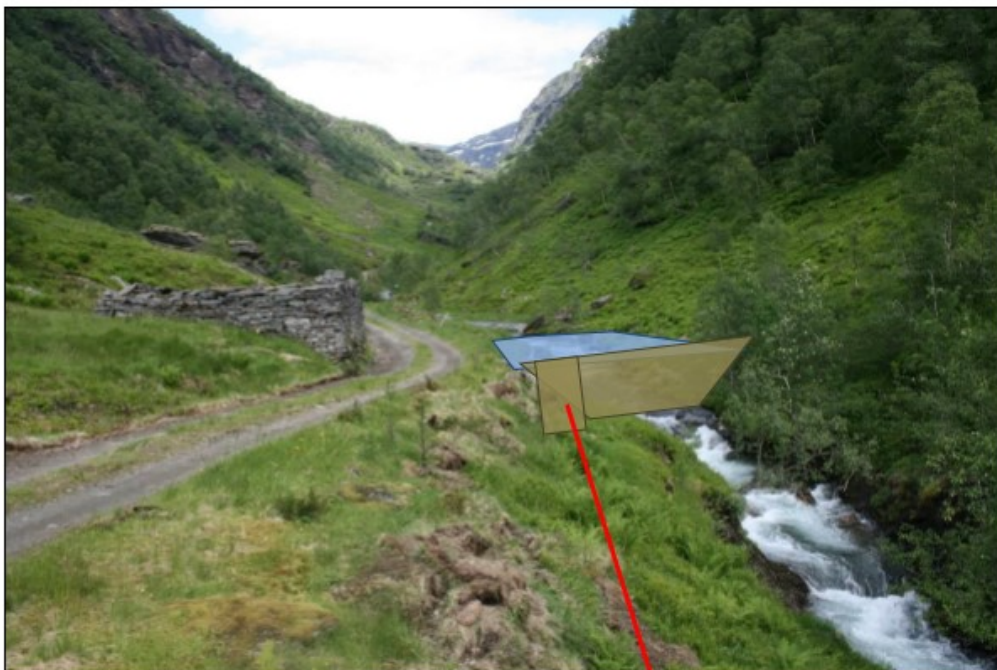
Figur 9 Dam, inntak, vannvei og oppdemt areal.
