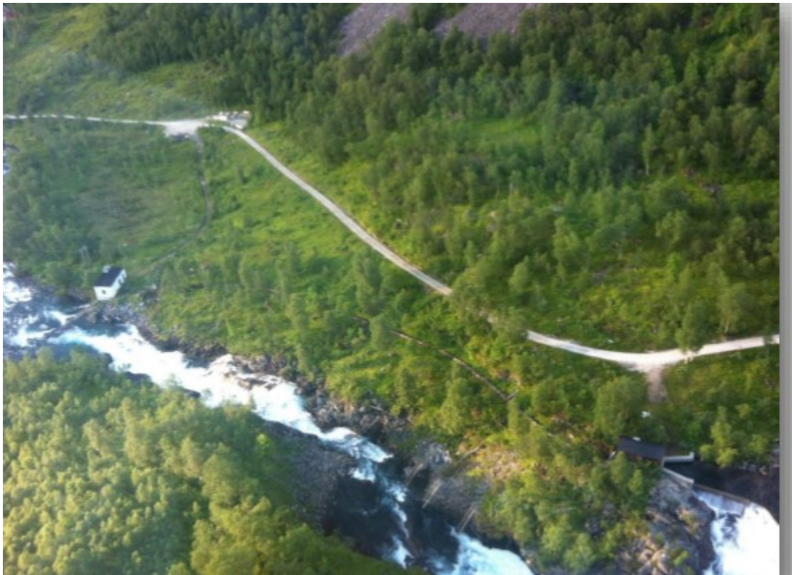
Eksisterende kraftstasjon og inntaksdam
