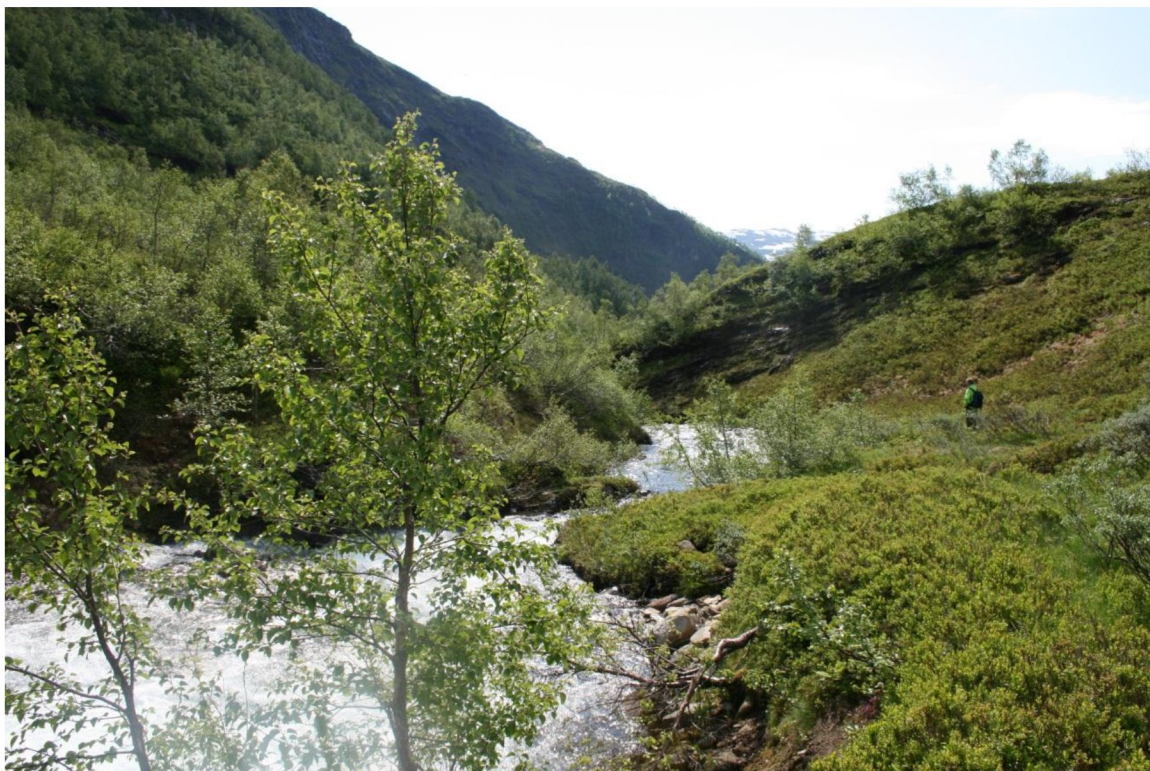
Vedlegg 5 - 2 Ved dam og inntak.
