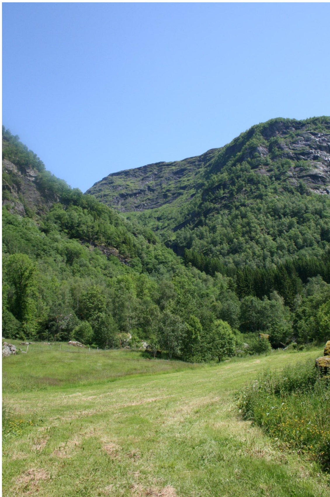
Vedlegg 5 - 9 Nedre del av rørgata går gjennom kulturlandskap og skog.
