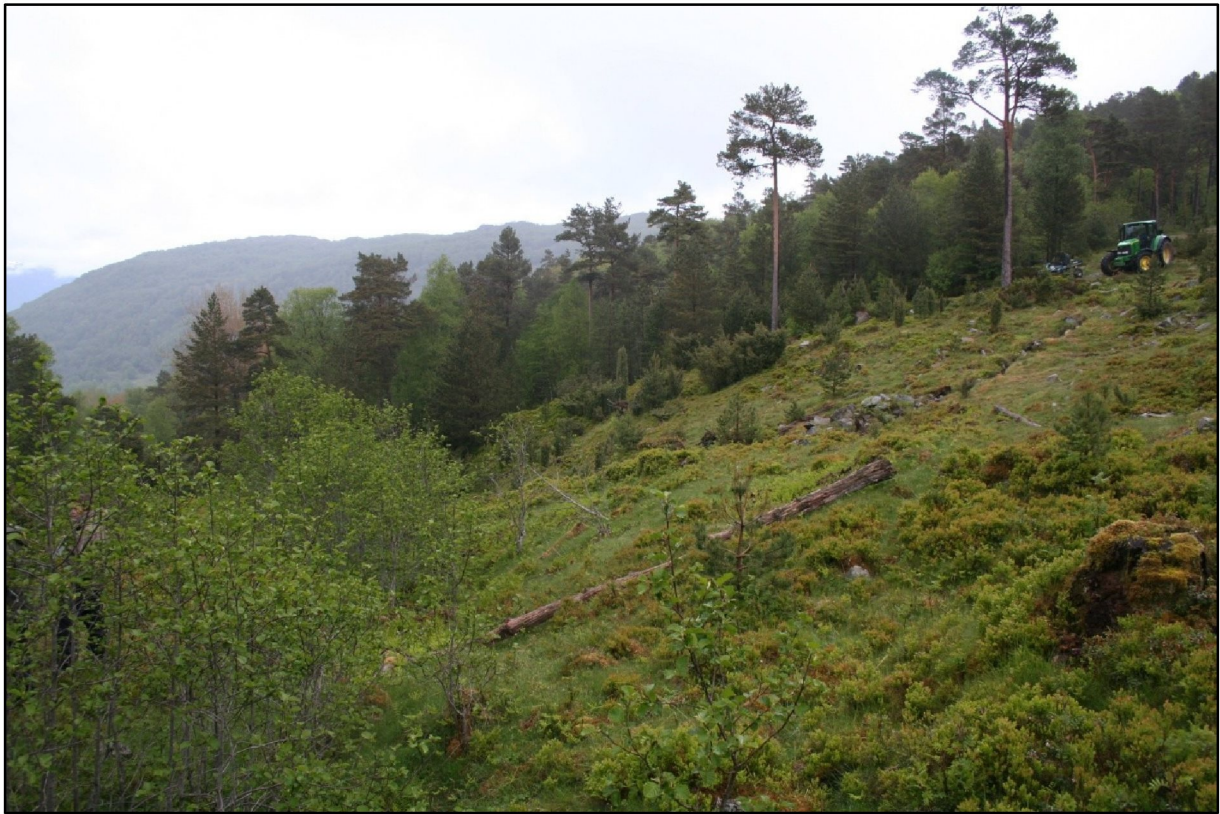
FIGUR 17: TRASE FOR OVERFØRIGN ER RETT FRAM I BILETET. TRAKTOR TIL HØGRE STÅR PÅ EKSISTERANDE VEG.
