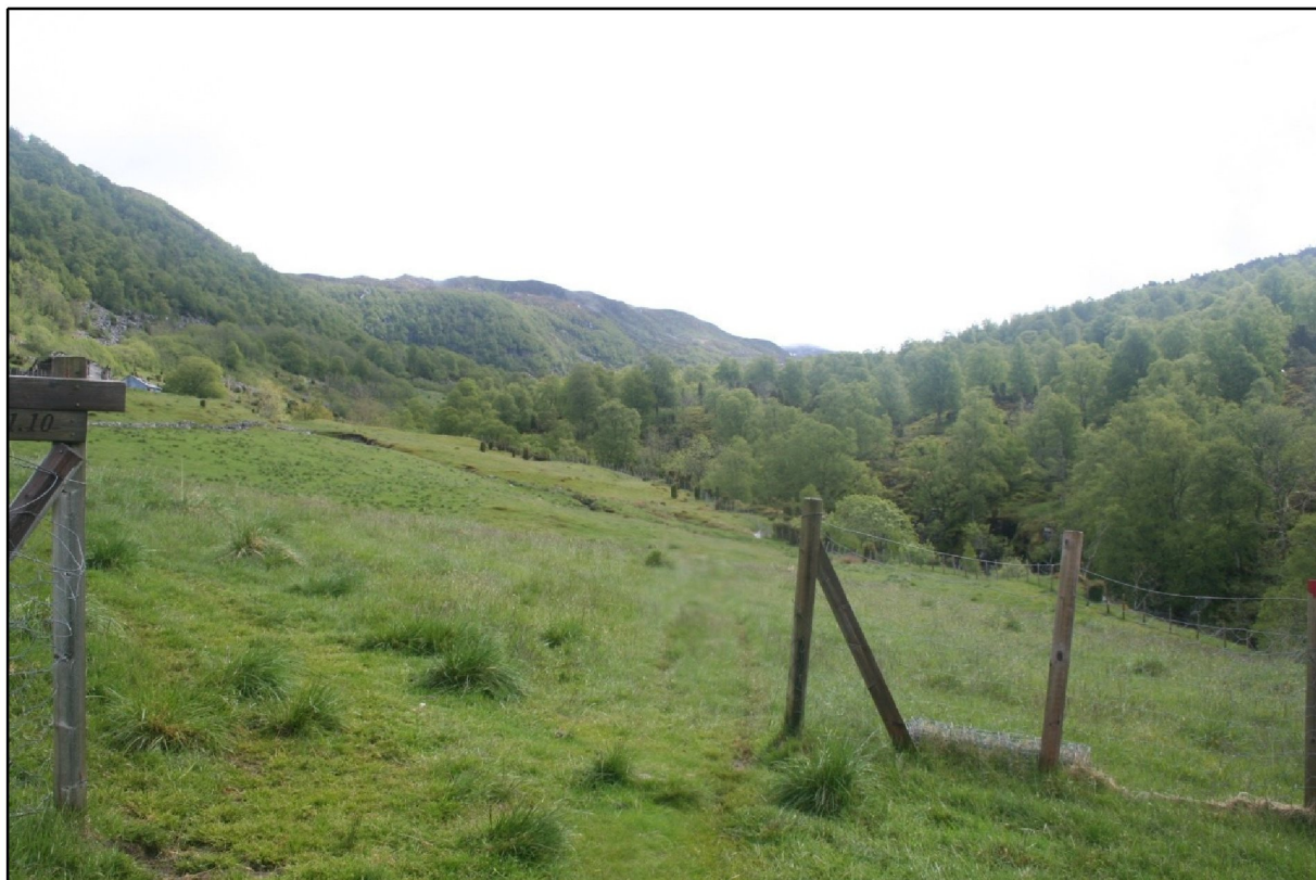
FIGUR 25: SETT OPPOVER RØRGATETRASEEN MOT INNTAKET.
