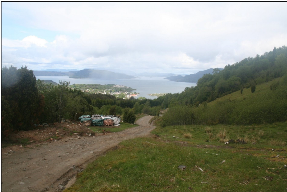
FIGUR 28: ETTER HVERT BLIR STANDAREN PÅ VEIEN BEDRE. TRASEEN FØLGER FREMDELES VEIEN.
