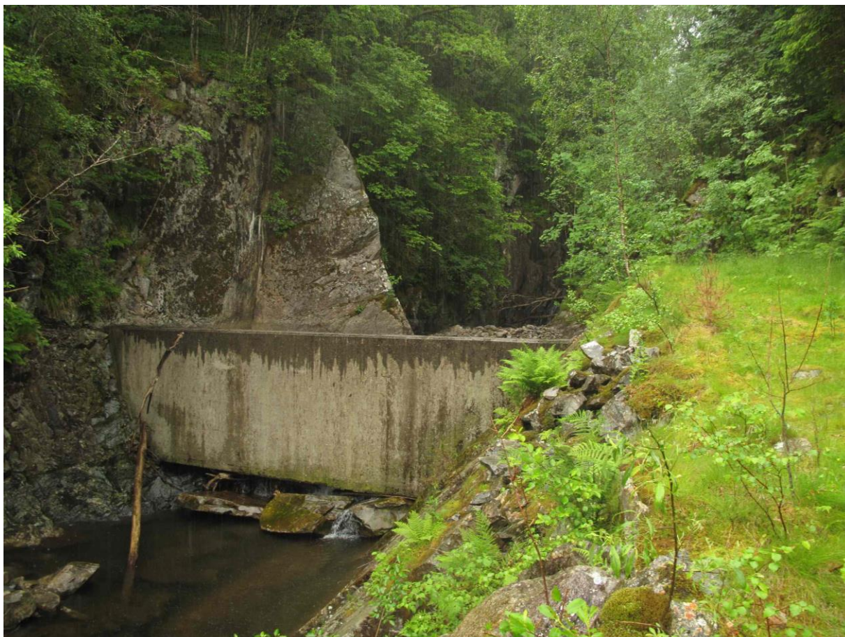
Figur 6. Foto; Torbjørn Høitomt, Biofokus © 29.06.2012. Dette bildet viser den omtalte betongdammen som skal forhindre at all steinføringen i elva blir ført nedover mot bebyggelsen ved eventuelle flommer. Gjennom tidene har det vært ganske mange skadeflommer i Valdraelva.
