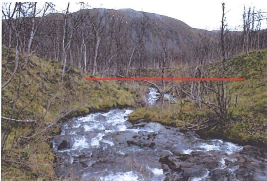
Bilde 1: Fra inntaksområdet. Demning midt i bildet. Foto: Pål Pettersen
