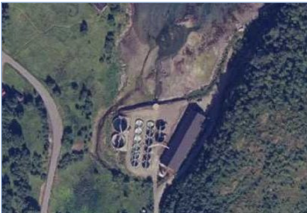
Figur 2: Settefiskanlegg Brennvikbogen (ortofoto fra Steigen kommunes hjemmeside)
