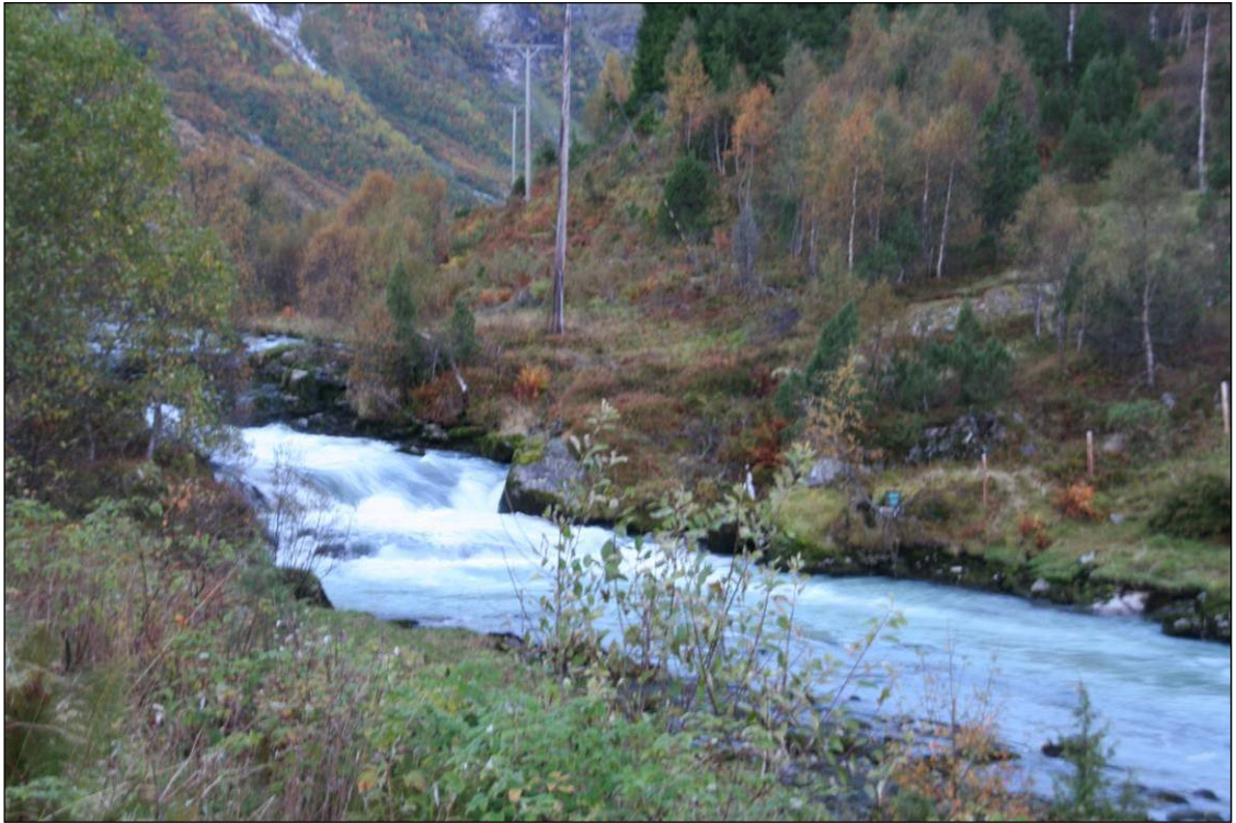
Figur 4. Inntaksområdet i Bøyaelva ligger like oppstrøms Skeisstølen, ca. kote 120. I bergterskelen i venstre billedkant vil en inntil 4 m høy og 30 m lang betongdam bli forankret, mens rørgata vil gå ut til høyre for elveløpet. Foto 28. september 2007: Ole Kristian Spikkeland.
