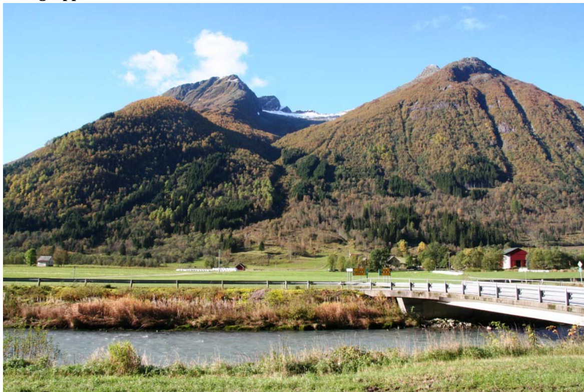
Bilde 1.1 Bro med avkjøring fra hovedveien Rv. 5
