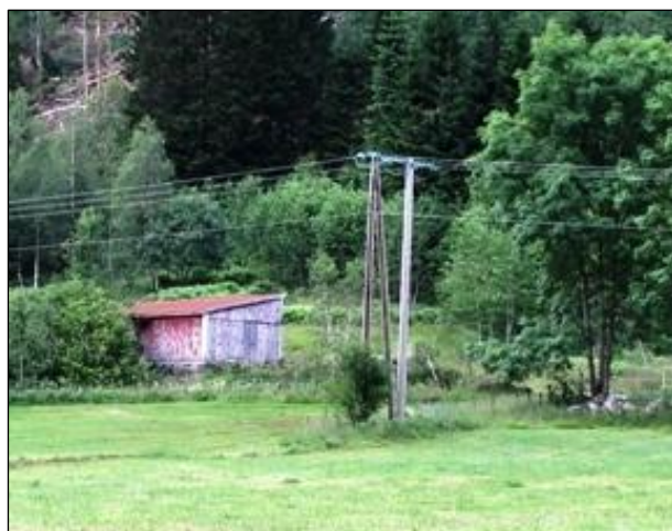
Figur 11 – 22 kV tilkoblingspunkt på Skeidsflåten
