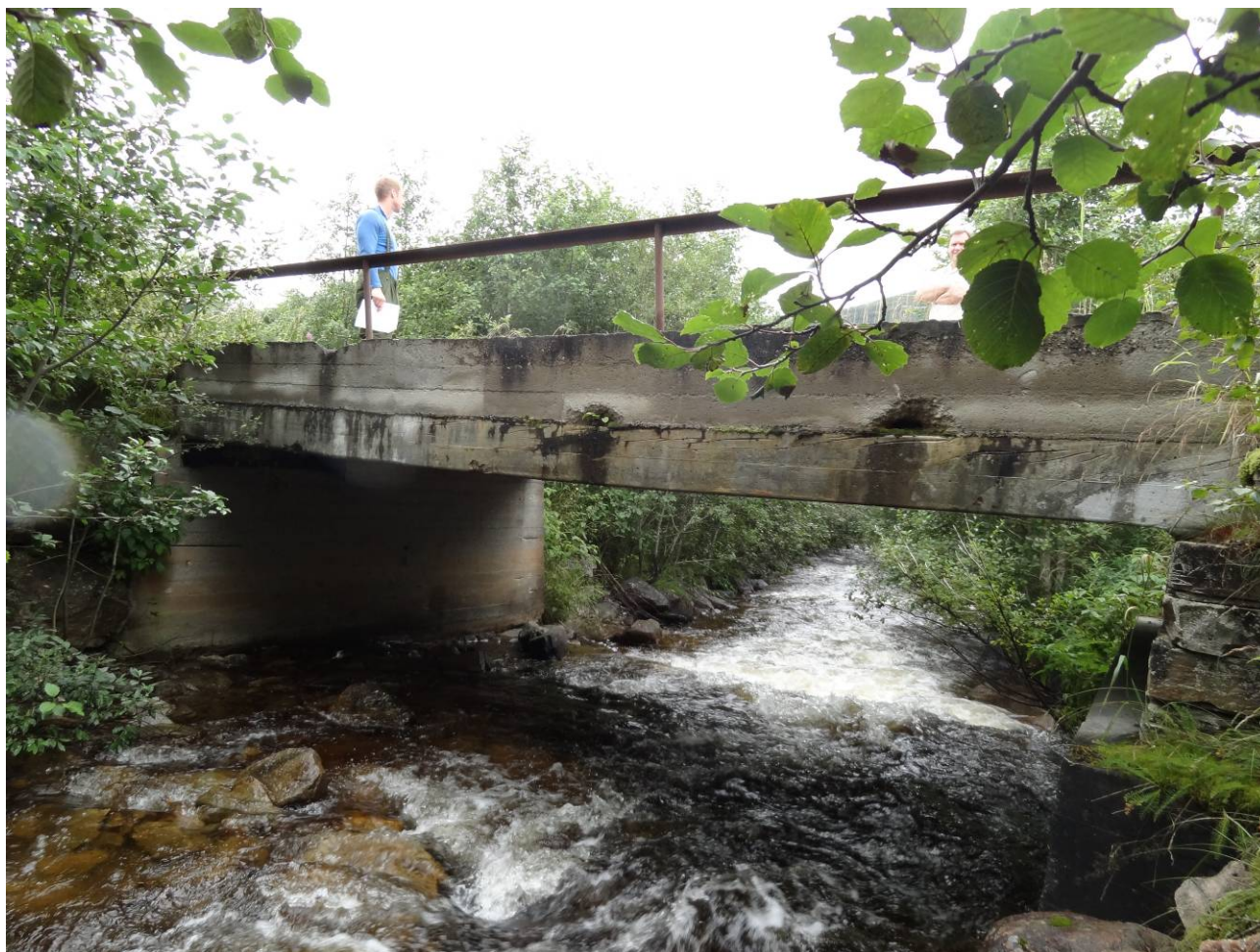
Bilde 11 Brua som ligger like nedstrøms planlagt utløp fra kraftverket
