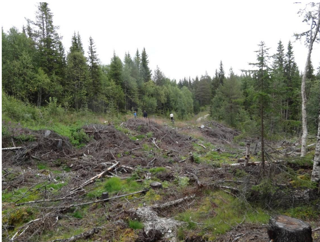
Bilde 5 Rørtrase mellom Riva og inntaket i Storbekken
