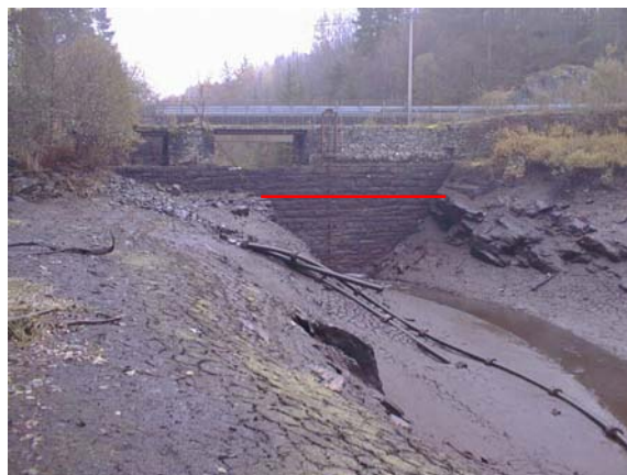
FOTO 7 – nedtappa magasin – sett mot dam. Strek markerer ca. omsøkt seinking/riving
