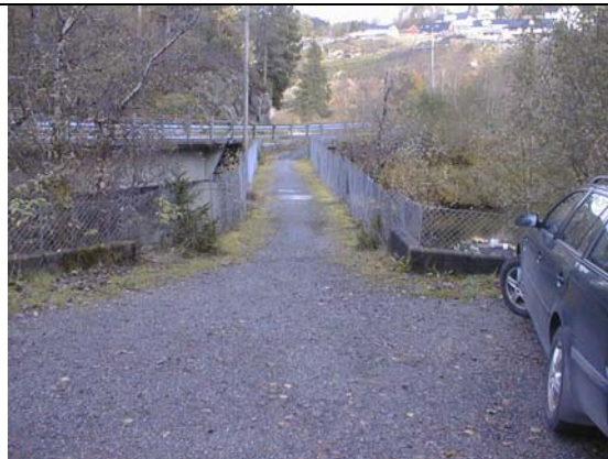
FOTO 5 – Gangbru over dam
