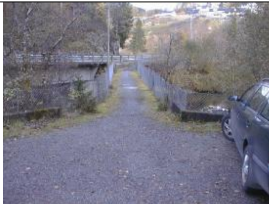
FOTO 5 – Gangbru over dam
