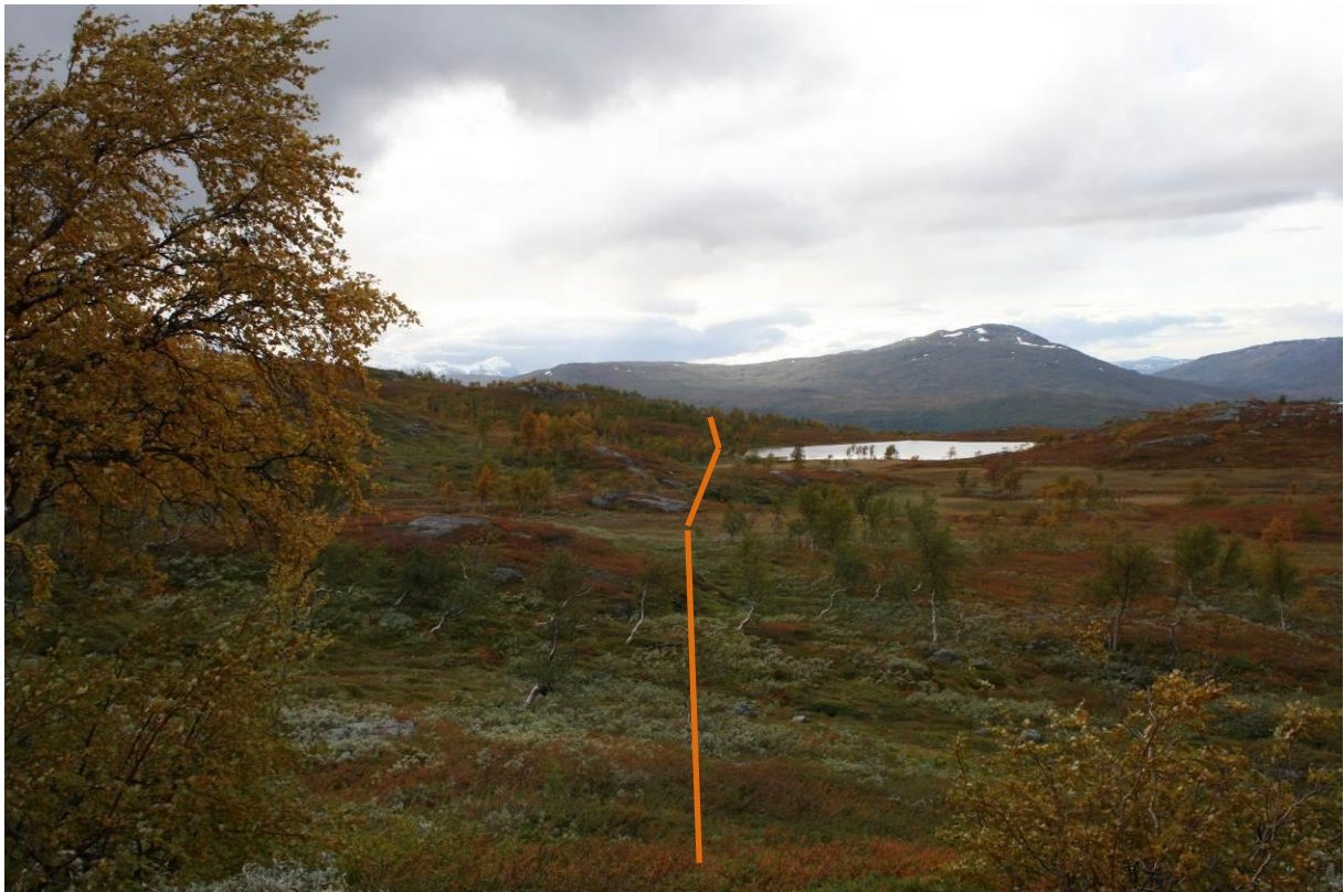
Figur 7: Øvre del av rørgata.
