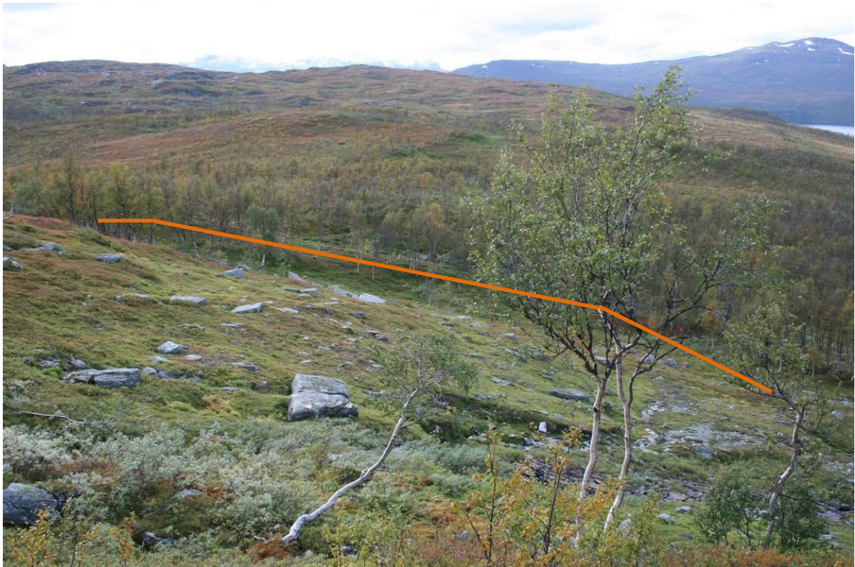
Figur 9: Rørgatas siste del vil passere over passet midt i bildet før vannet vil renne fritt ned mot Skittreskvatnet.
