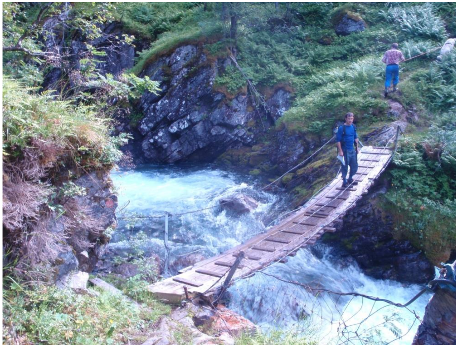
Loftdalselva ved gangbru
