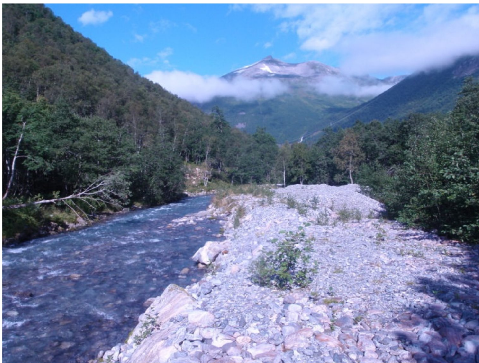
Bilde 12 Eksisterende elveforbygning rett nedstrøms utløp kraftverk
