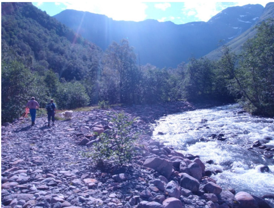
Bilde 11 Eksisterende flomforbygning på østsiden av elva rett nedstrøms utløp planlagt kraftverk. Vei til kraftstasjon vil legges på denne.
