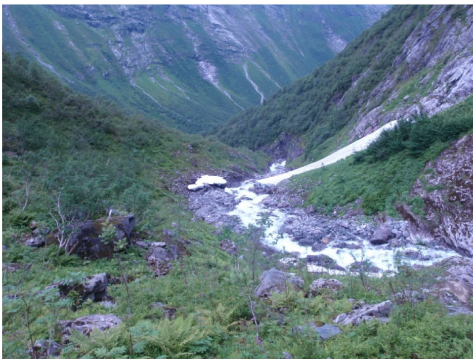
Bilde 4 Nedstrøms inntak. Rørtrase til venstre for elva
