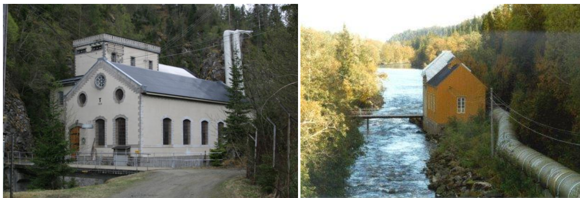
Figur 12 Skjenaldfoss kraftstasjon (venstre) og Sølbergfallet kraftstasjon (foto: Salvesen & Thams).
