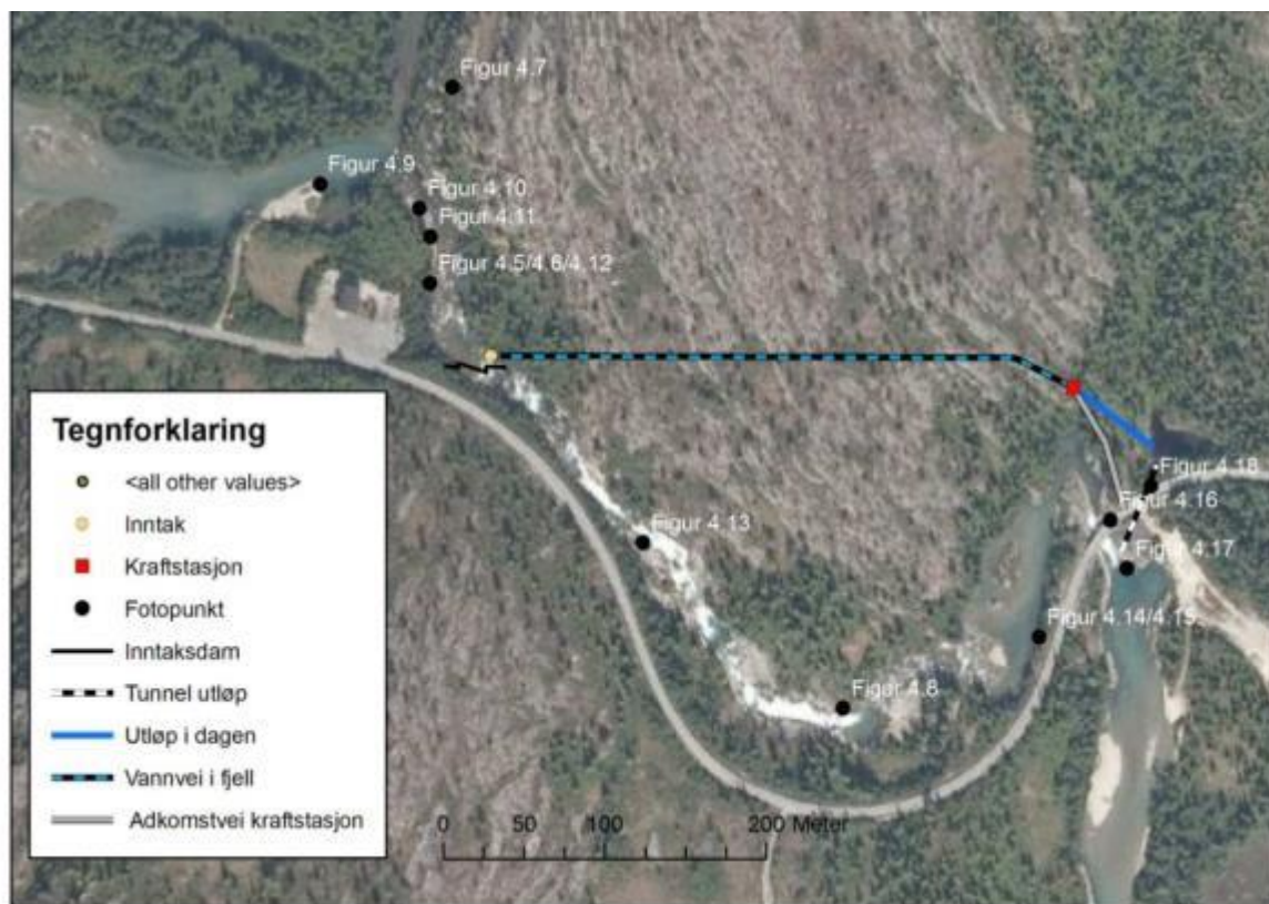
Figur 3-19 Satellittbilde over nærområdet til kraftverket. Som det fremgår av bildet er området dominert av bart fjell, blandingskog og myr. Området med flommarkskog/bjørkesumpskog sees tydelig sør for Vardfjelltjøna. Av bildet framgår det også at elvestrekningen nedstrøms inntak ned til der figur 4.8 er avmerket i hovedsak består av stryk og fossestryk.
