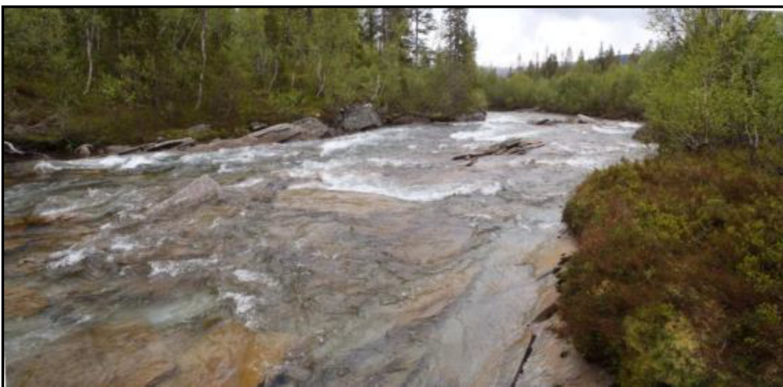
Figur 3-21 Bildet tatt litt ovenfor inntaksområdet retning nedstrøms (foto: Mats Finne, Sweco).
