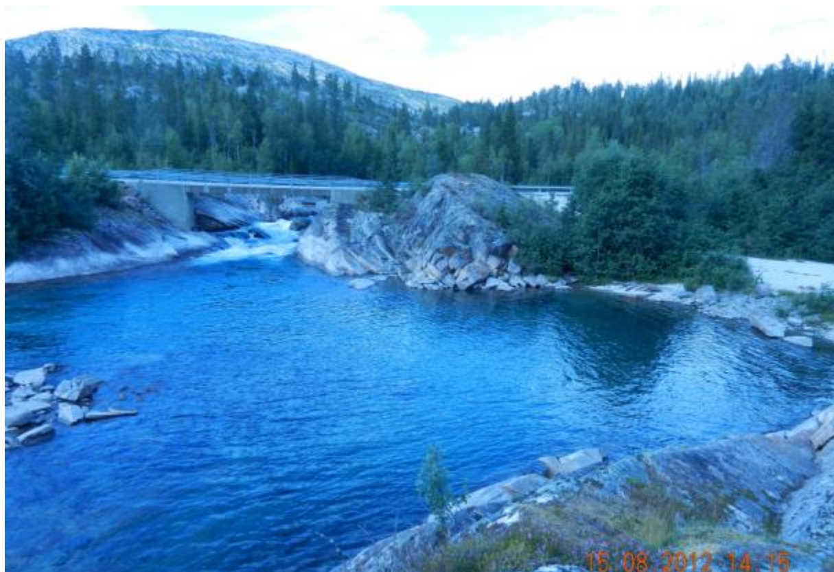
Figur 1-3. Nederste bru over Leiråga. (typisk) Melfjordveien slynger seg videre oppover med flere brukryssinger. Leiråga kraftverk vil ligge i skogen bakenfor.
