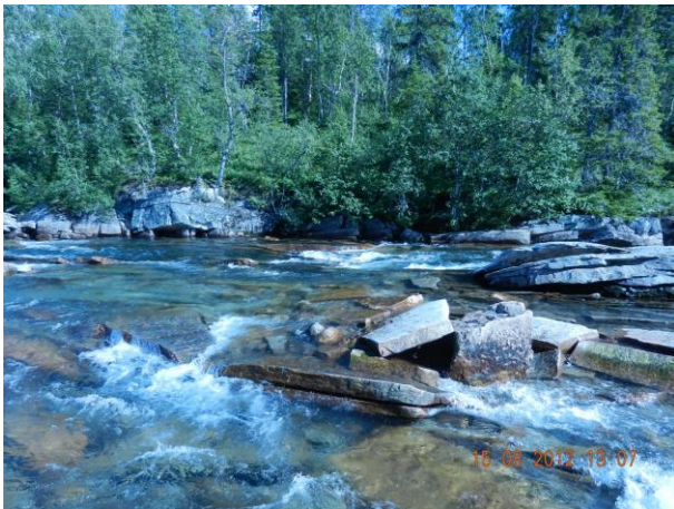
Figur 2-1 Damsted ca 100m nedstrøms samløpet. Sett mot inntaksområdet (sjakt og tunnel fra inntaket, foto: Sten Hernes Sweco Norge AS)
