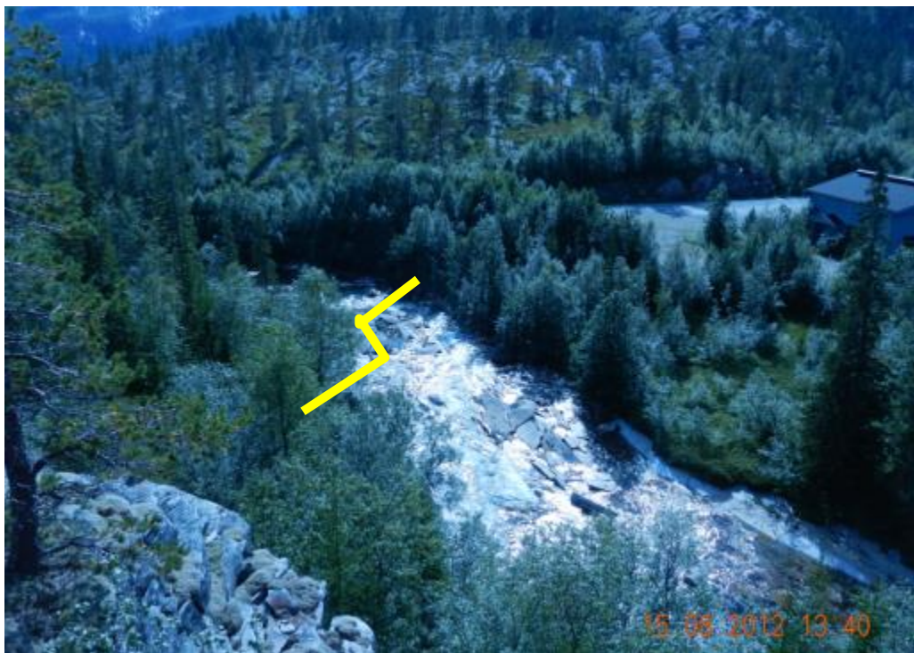
Figur 2-7. Damsted i Leiråga sett fra Kalvhaugan. Dammen blir ca. 35 m lang og ca.2 m høy varierende over lengden. Melfjordveien og brøytestasjon på motsatt side.
