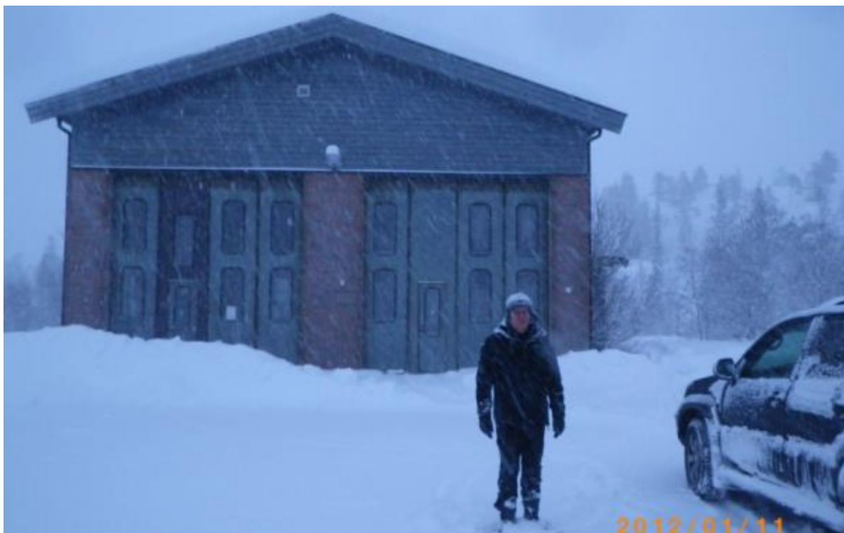
Figur 1-4. Brøytestasjon ved FV 355 Melfjordveien. Leiråga inntaksdam vil ligge i elva ned til høyre.
