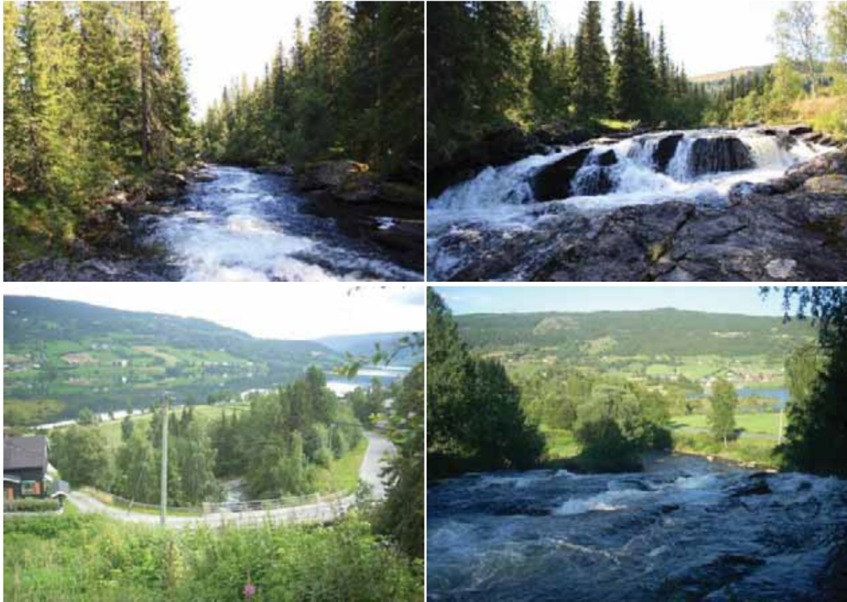
Figur 2: Øvre bilder viser sted rundt planlagte inntak alt.1 (venstre), oppstrøms dam (høyre). Bildene under viser planlagt stasjonstomt nedstrøms bro til høyre for elva (venstre), med sted for utløp (høyre). Fotos: Anne Nyland & Ole Roer.
