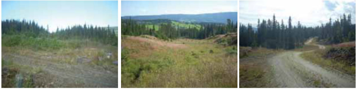
Bildene over viser del av rørgata over hogstfelt og inn på eksisterende skogsbilvei.
