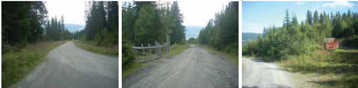
Bildene over viser del av rørtasé langs skogsbilvei.
