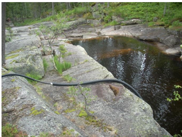
Figur 3.13. Ledning for vanninntak. Foto Ole Roer
