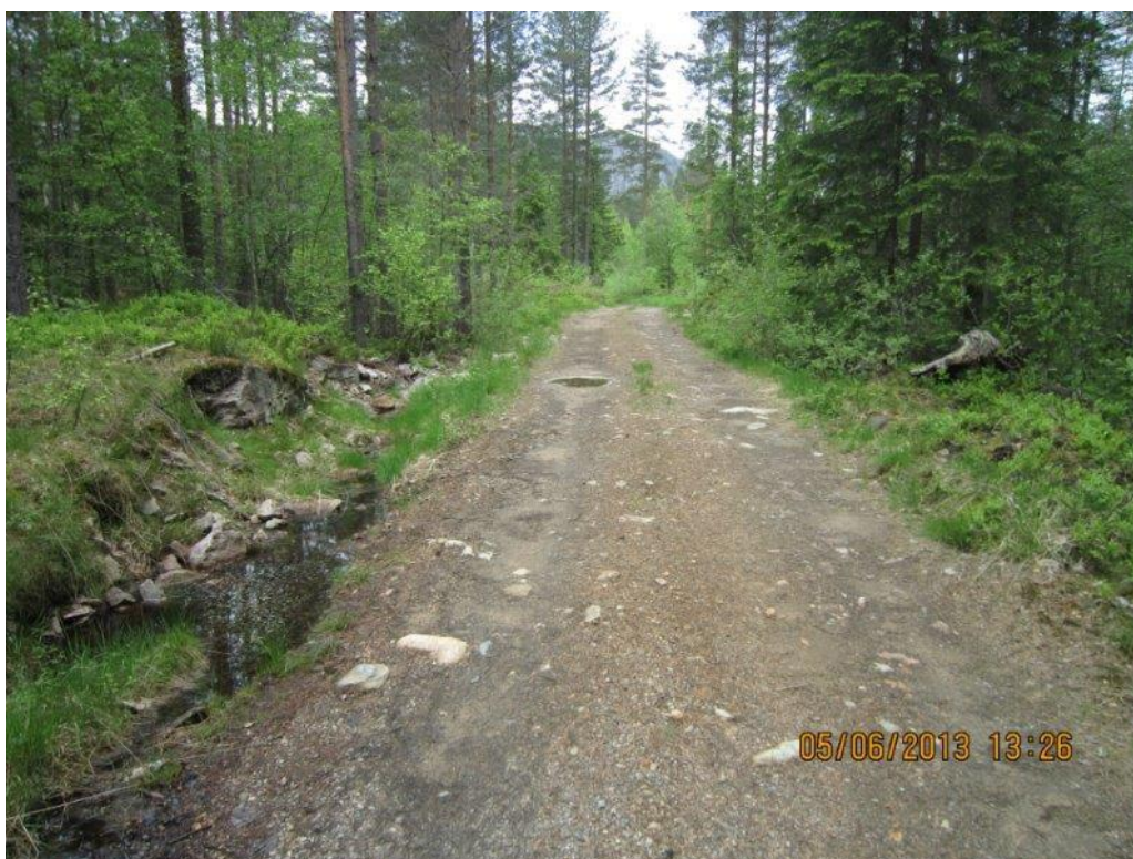
Bilde 2.2.8.2: Eksisterende vei oppgraderes. Foto: Clemens Kraft.
