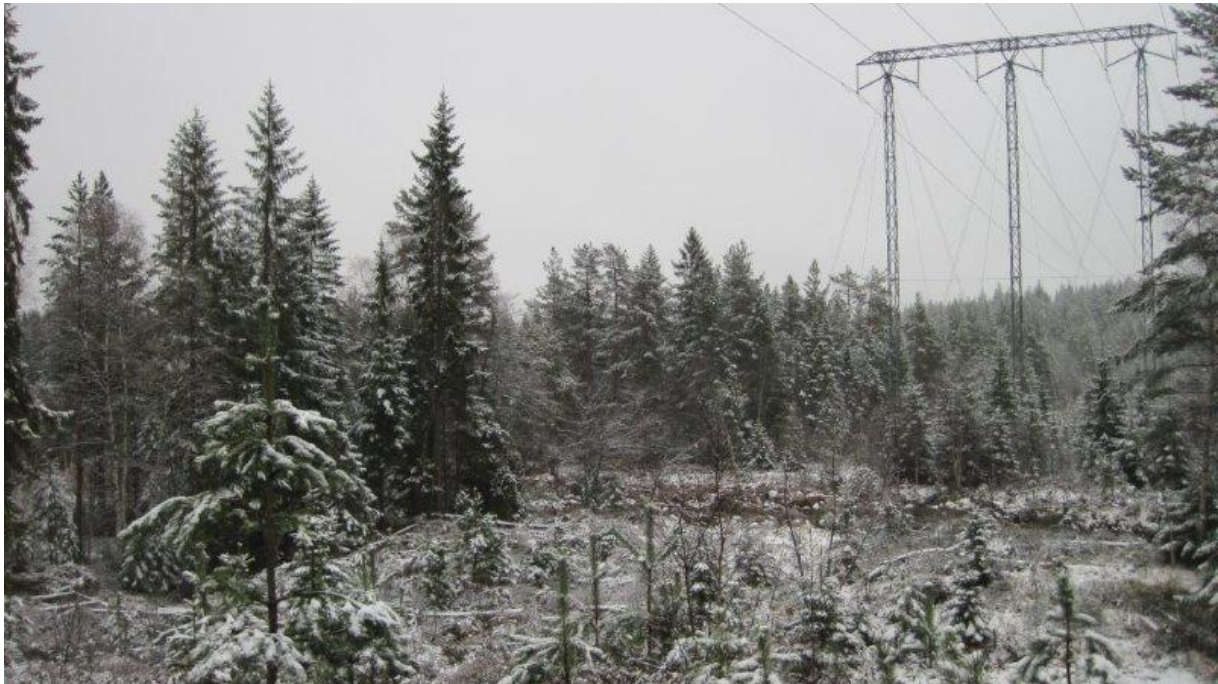
Bilde 6.5.5: Rørtrase nedre del. Foto: Clemens Kraft
