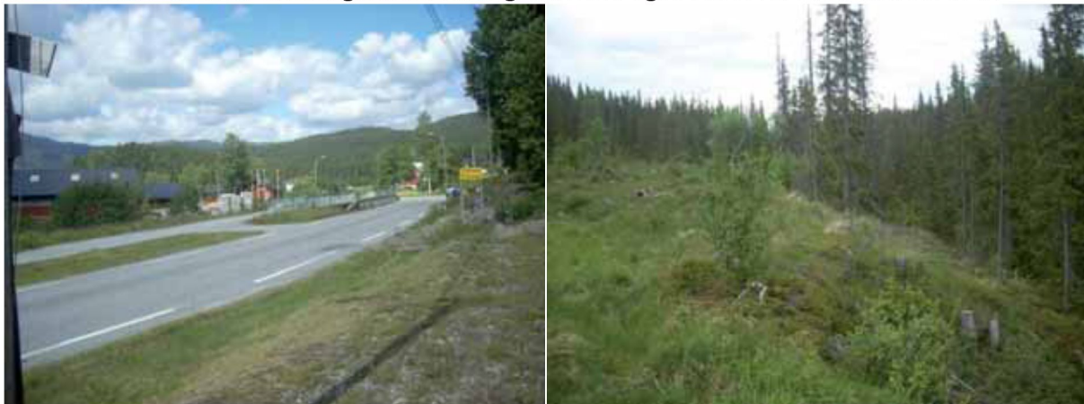
Figur 7: Fv 651, Tuddalsvegen krysser Gjuvåa ved kote 475 (venstre). Til høyre del av ny hogstflate vest for elva mellom kote 700-720. Fotos: Ole Roer.
