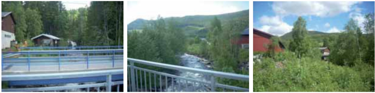
Bildene over viser lokalitet for planlagt kraftstasjon oppstrøms fylkesveien (venstre), samt alternativ plassering nedstrøms fylkesveien (midt + høyre).
