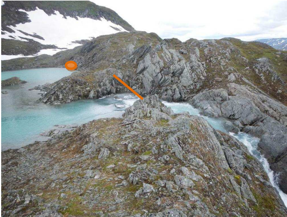
Bilde 1: Dam og inntak indikert ved utløpet av Otervatn
