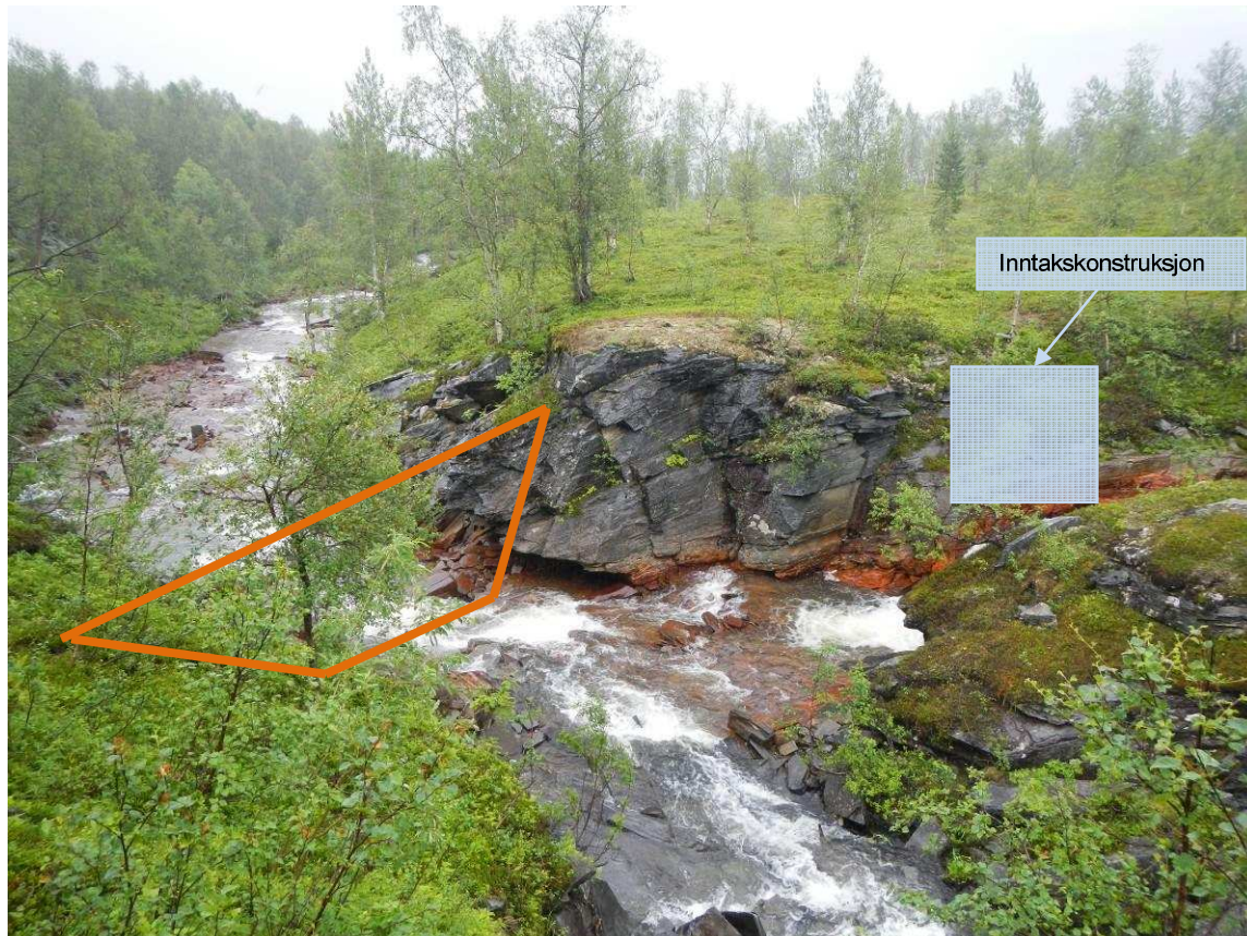
Fotografi 1: Dam og inntaksplassering angitt.
