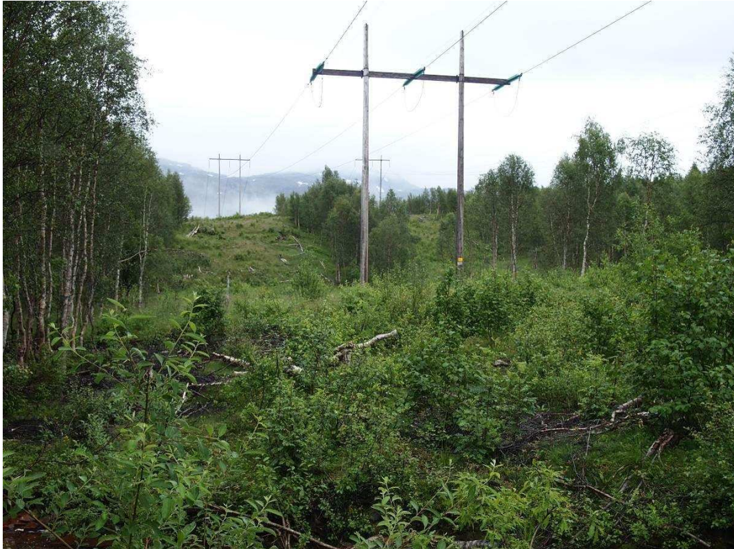
Fotografi 3: Rørgate kryssing under høyspentmaster
