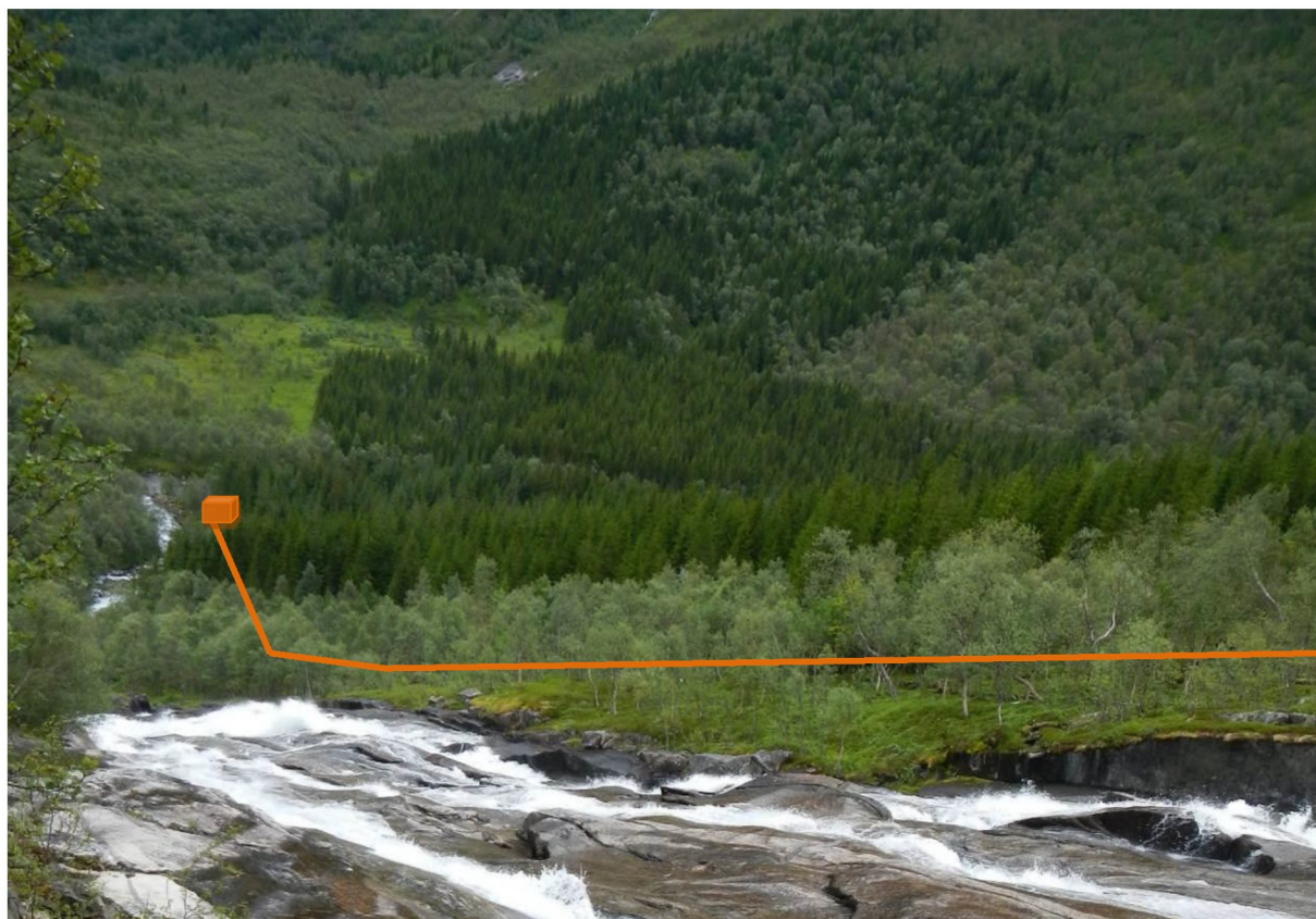
Fotografi 3: Rørgate og kraftstasjon indikert.
