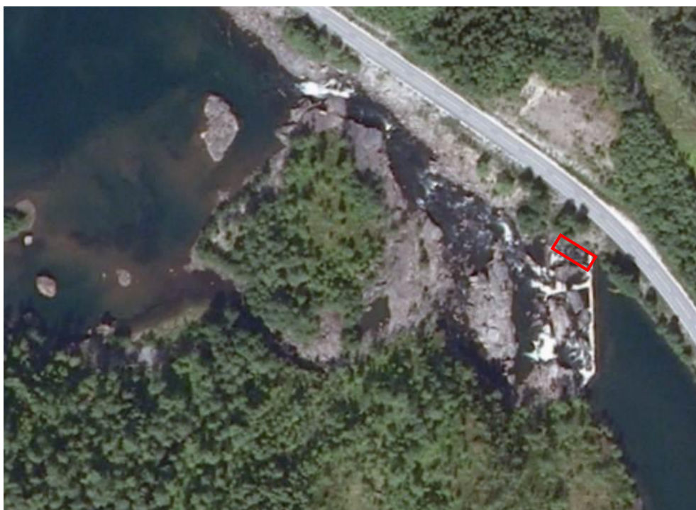
Figur 10: Flyfoto av eksisterende terskel (hentet fra www.norgebilder.no ). Planlagt inntakskonstruksjon er skissert.
