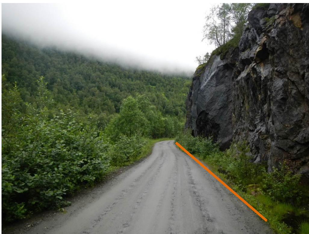
Fotografi 3: Rørgate trase` indikert. Trangt parti.
