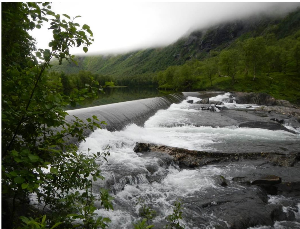
Fotografi 1: Damstedet sett fra nedstrøms side. Inntak plasseres til venstre for fotografiet.
