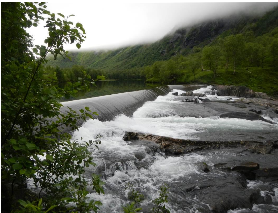
Figur 15. Terskel oppstrøms Sjønståfjelltunnelen. Damstedet planlegges til venstre for bildet.
