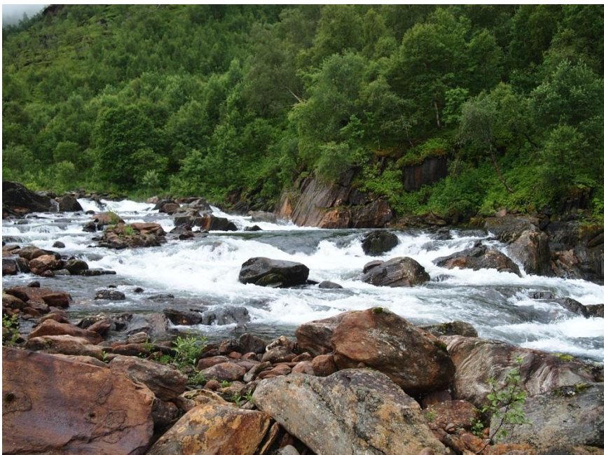
Figur 7. Typisk del av elveløpet i juvet nedstrøms Sjønståfjelltunnelen.
