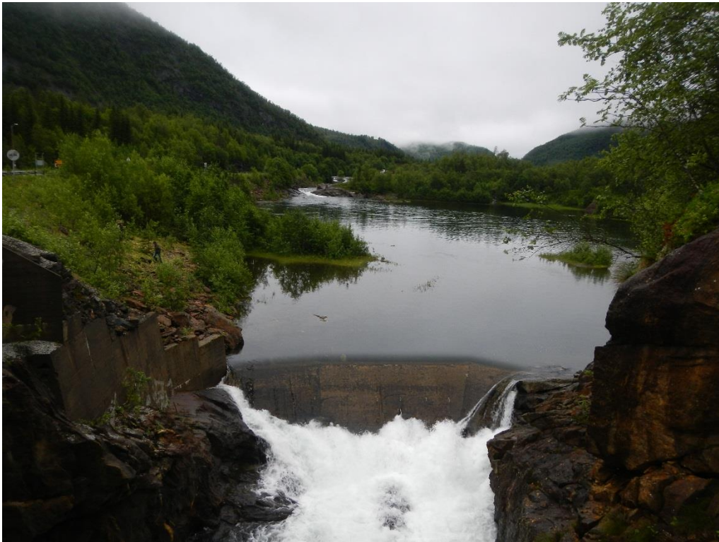
Figur 20. Nedre terskelbasseng. Bildet er tatt fra brua som leder fv. 830 inn i Sjønståfjelltunnelen. Dette er starten på Sjønståfossen.
