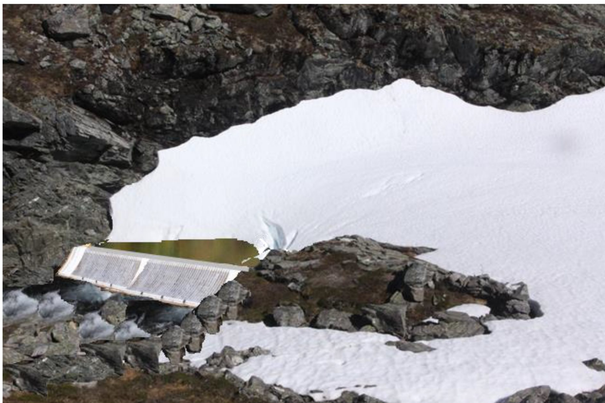
Figur 3.9.2.4 Fotovisualisering av coandainntak ved Glutervatnet (samlekum bak / midt i steinhaugen)
