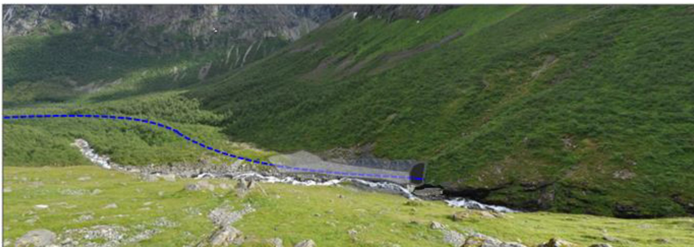
Figur 3.9.2.2 Bilde som viser området hvor overgangen fra nedgravd rørgaten til tunnel samt massedeponi ved Saufonnfossen er tenkt lokalisert.
