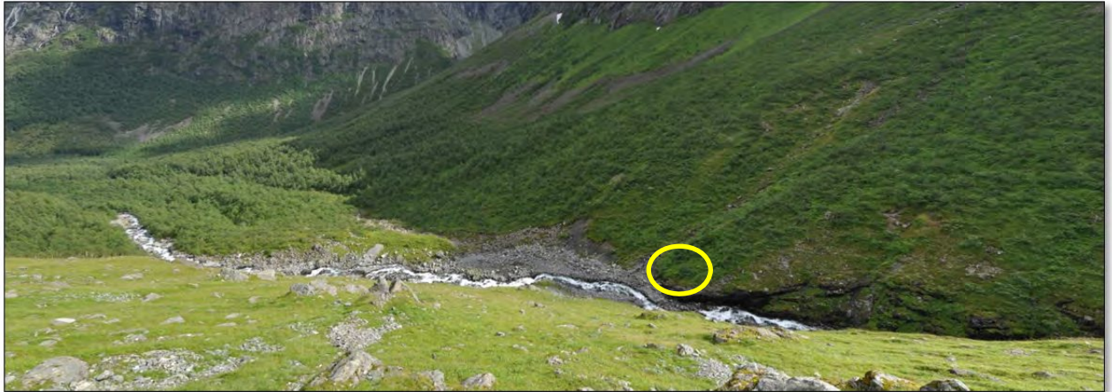
Figur 40. Bilde som viser området hvor overgangen fra nedgravd rørgaten til tunnel samt massedeponi ved Saufonnfossen er tenkt lokalisert.
