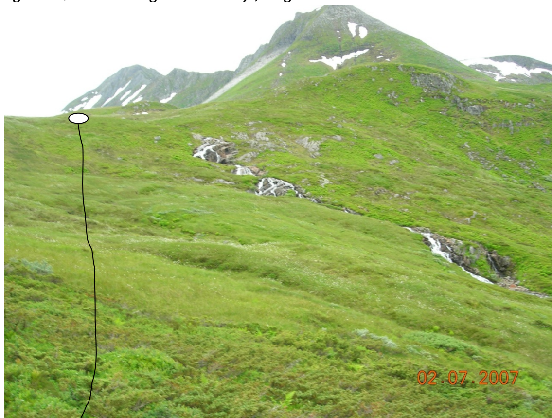
Figur 7: Inntaksdam på ca kote 600 og rørtrasé inntegnet i svart linje.
