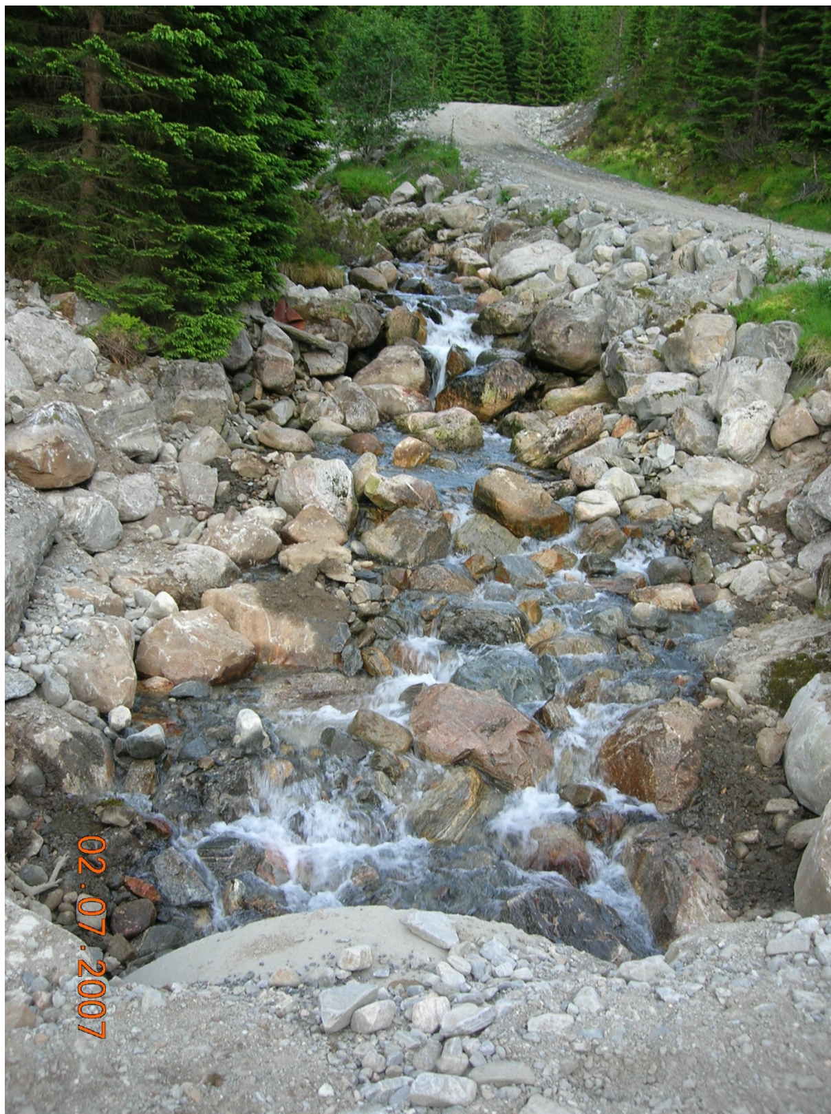
Figur 12: Helgåa 50 meters oppstrøms utløpet i Helgåa – kulvert gjennom vei.
