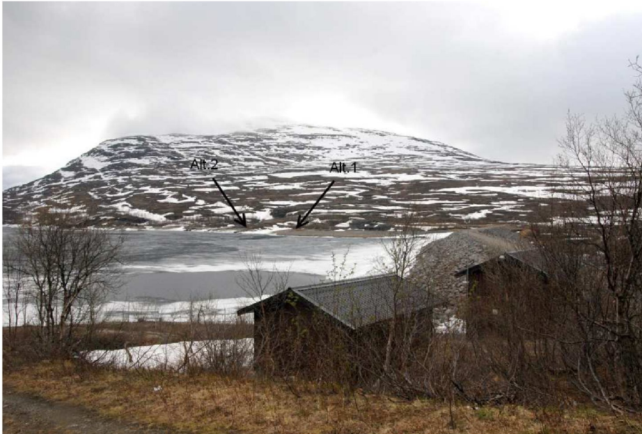
Bilde 1 – Utsikt fra nordsiden av Altevatt demning mot stasjonsområde.
