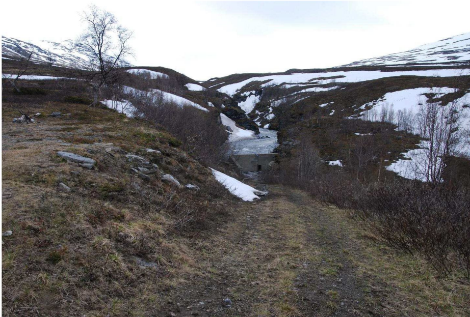
Bilde 3 – Vei ned til eksisterende overføringsinntak.
