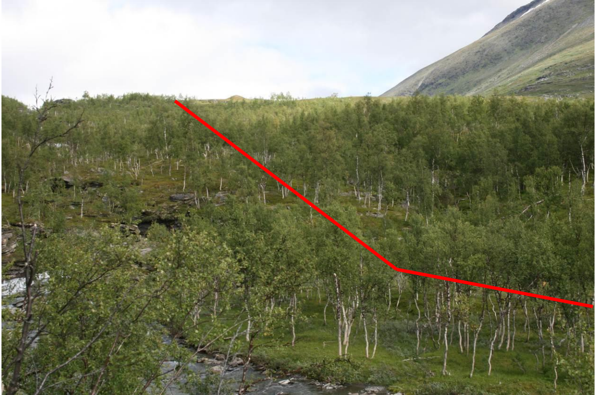
Vedlegg 5 - 4 Midtre del av rørgata går gjennom bjørkeskog med et tynt løsmasselag.
