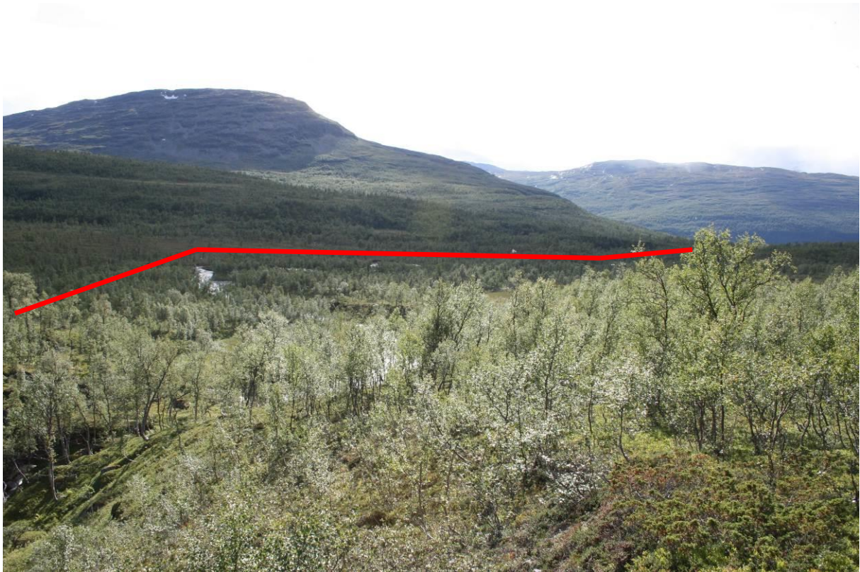
Figur 9 Midtre og nedre del av rørgata er relativt flat.
