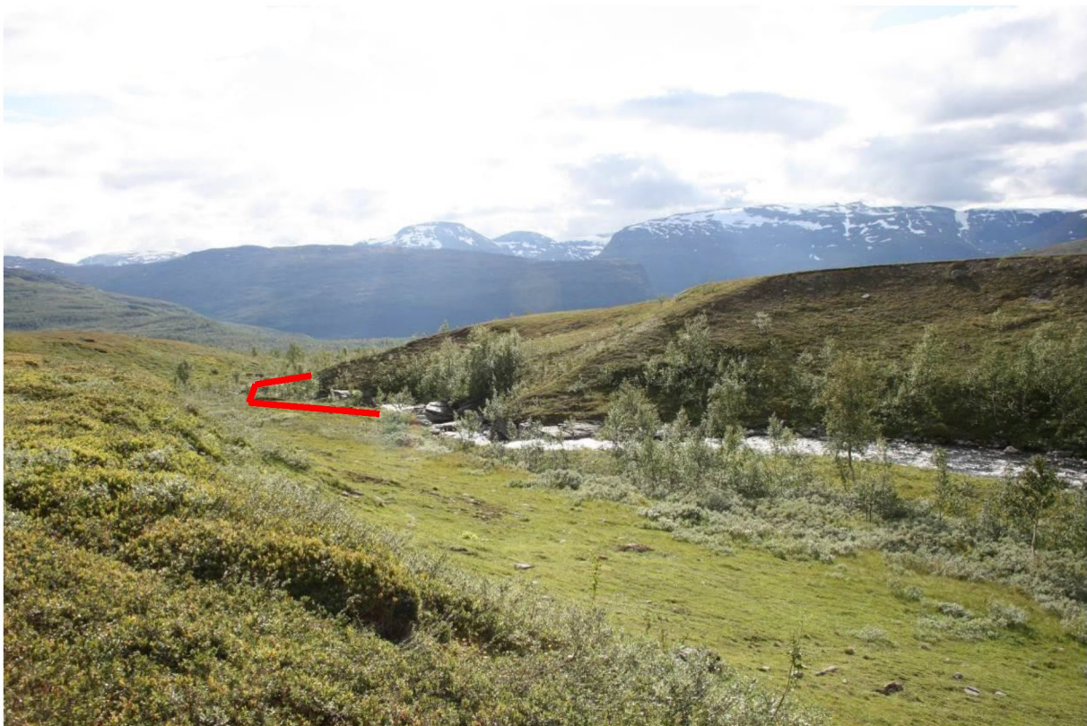
Vedlegg 5 - 3 Øvre del av rørgata
