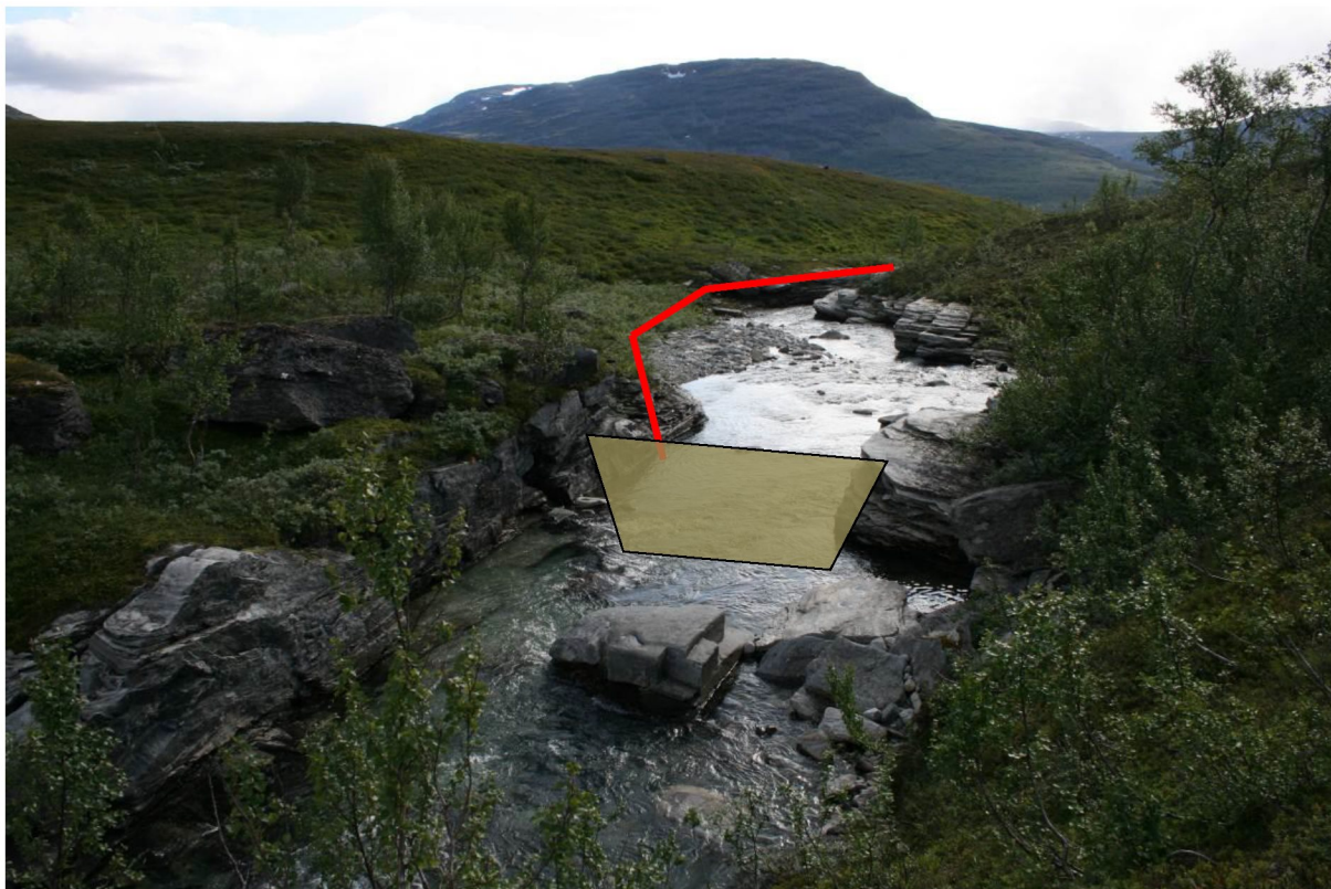
Figur 6 Dam, inntak og start på rørgate sett fra oppstrøms side
