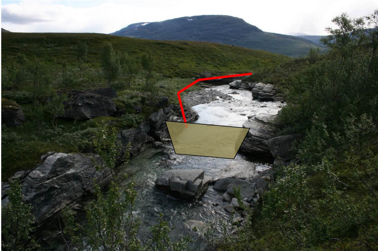
Vedlegg 5 - 2 Dam, inntak og start på rørgate sett fra oppstrøms side
