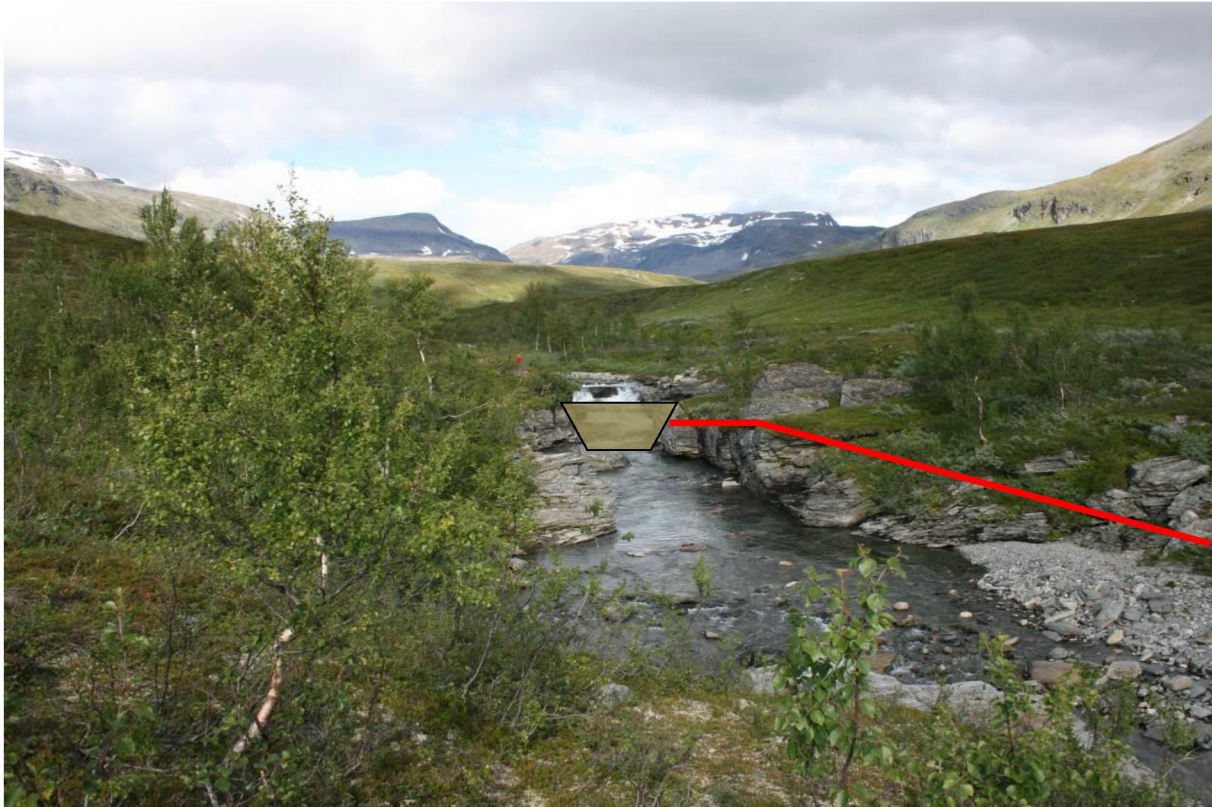
Figur 5 Dam, inntak og start på rørgate
