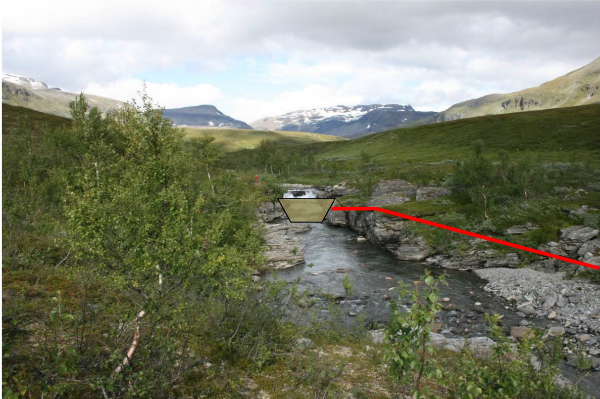
Vedlegg 5 - 1 Dam, inntak og start på rørgate
