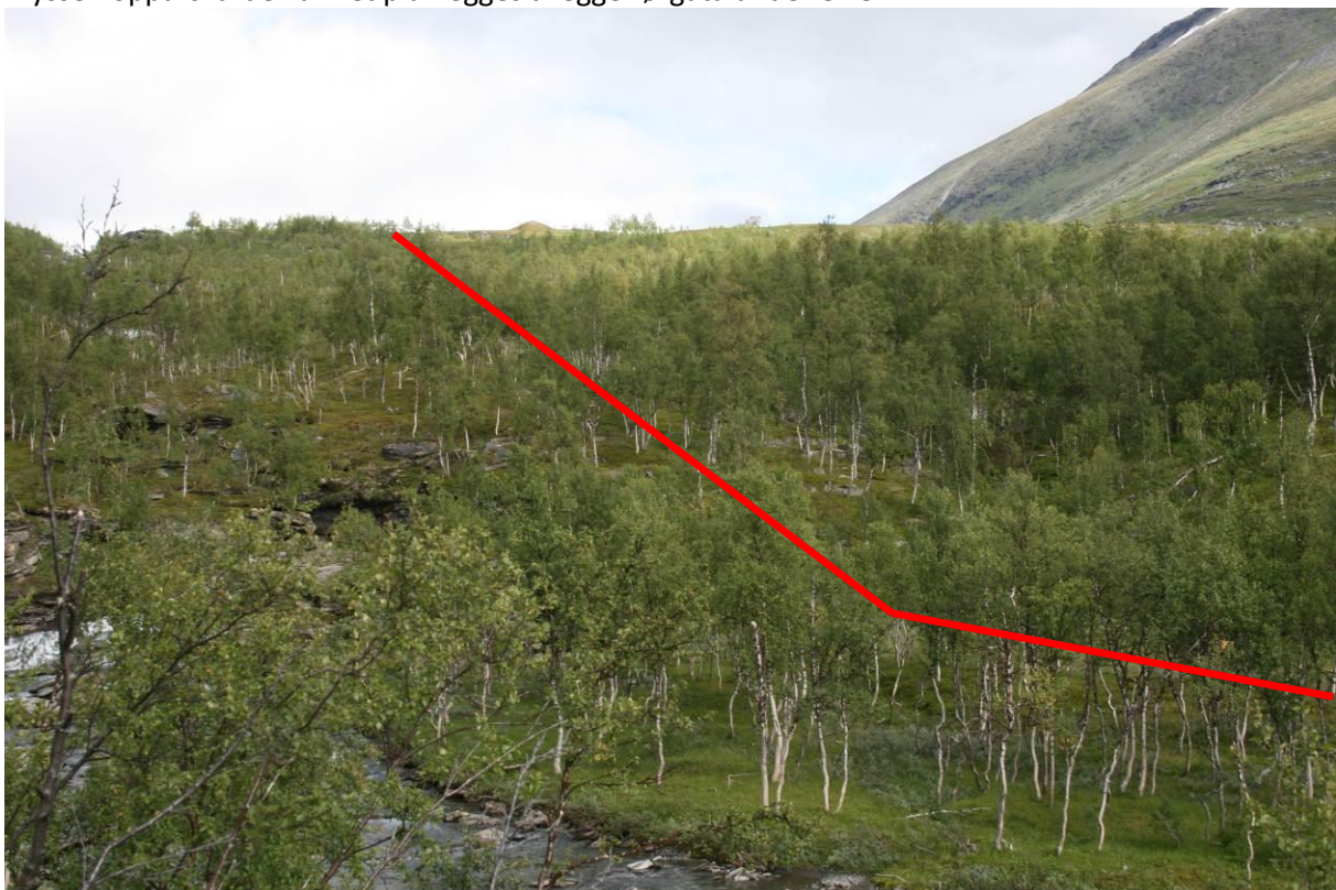
Figur 8 Midtre del av rørgata går gjennom bjørkeskog med et tynt løsmasselag.
