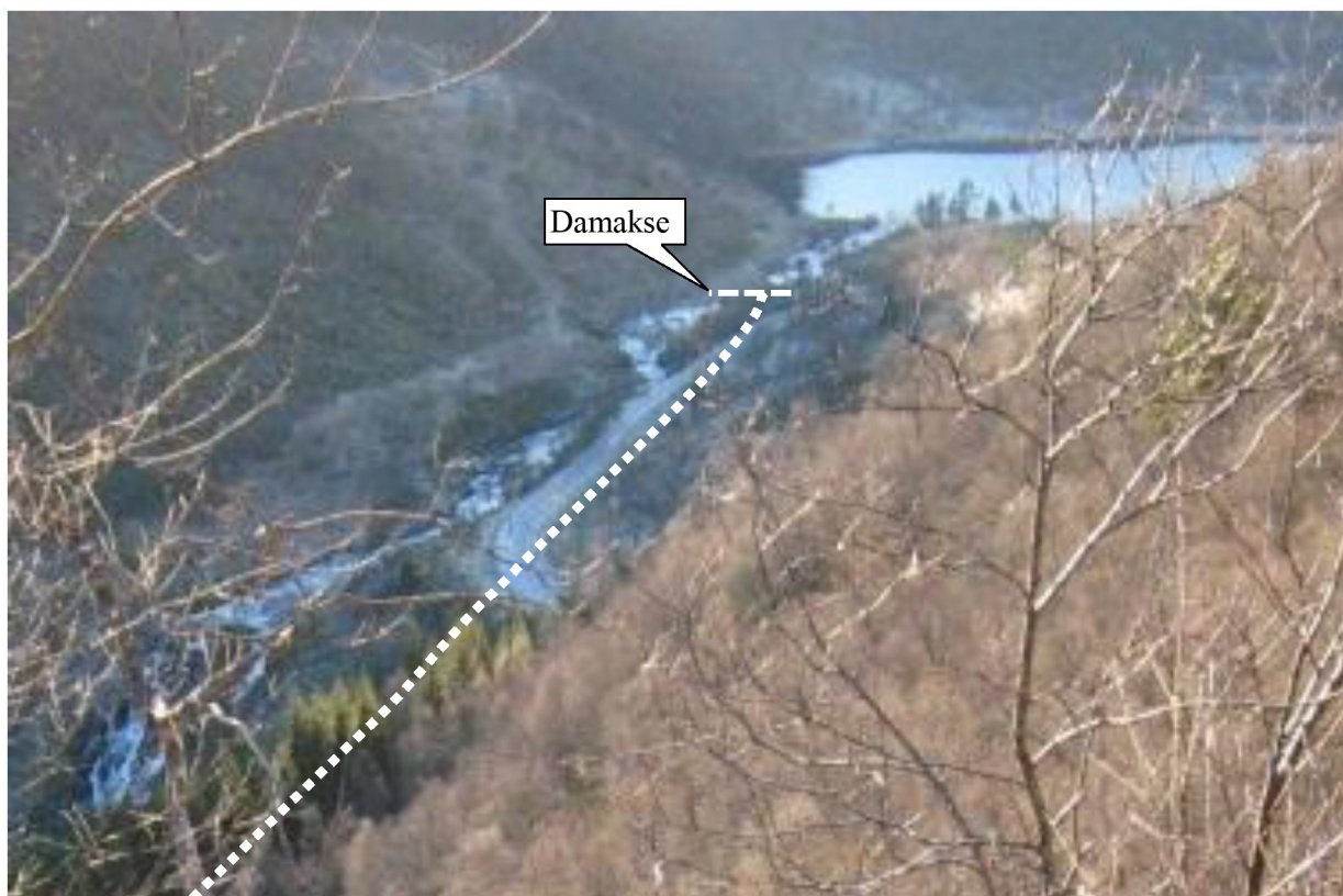
Figur 12 Damakse og rørtrase sett fra lia opp langs Tverrelva som har utløp i Osdalselva. I bakgrunnen ses Osdalssætrevatnet.
