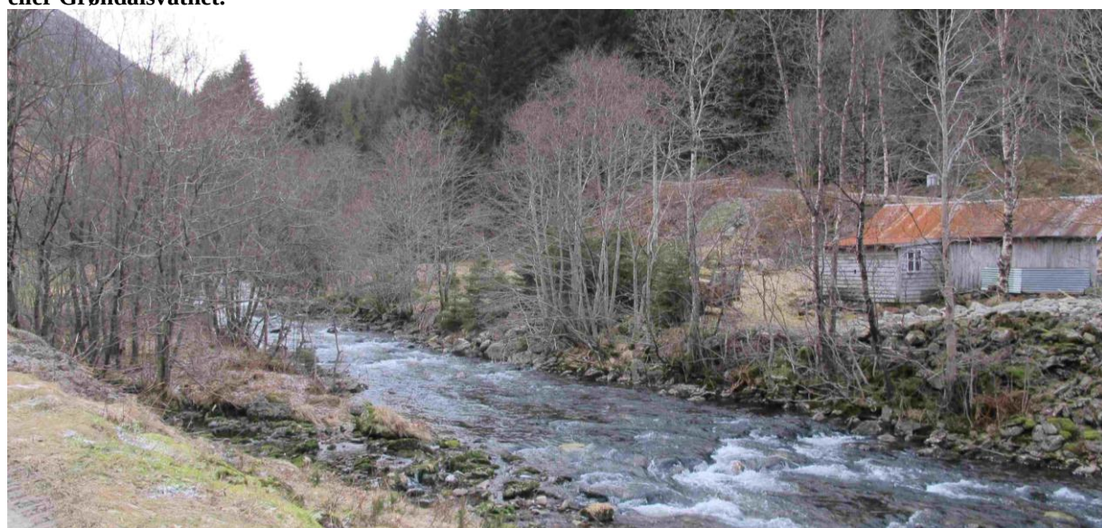
Figur 15. Biletet viser området for kraftstasjonen. Den skal plasserast om lag der smågranene veks ved elva. Som vi ser, så står granskogen tett langs vegen oppover dalen. (Foto; Oddvar Olsen © 01.12.2012).
