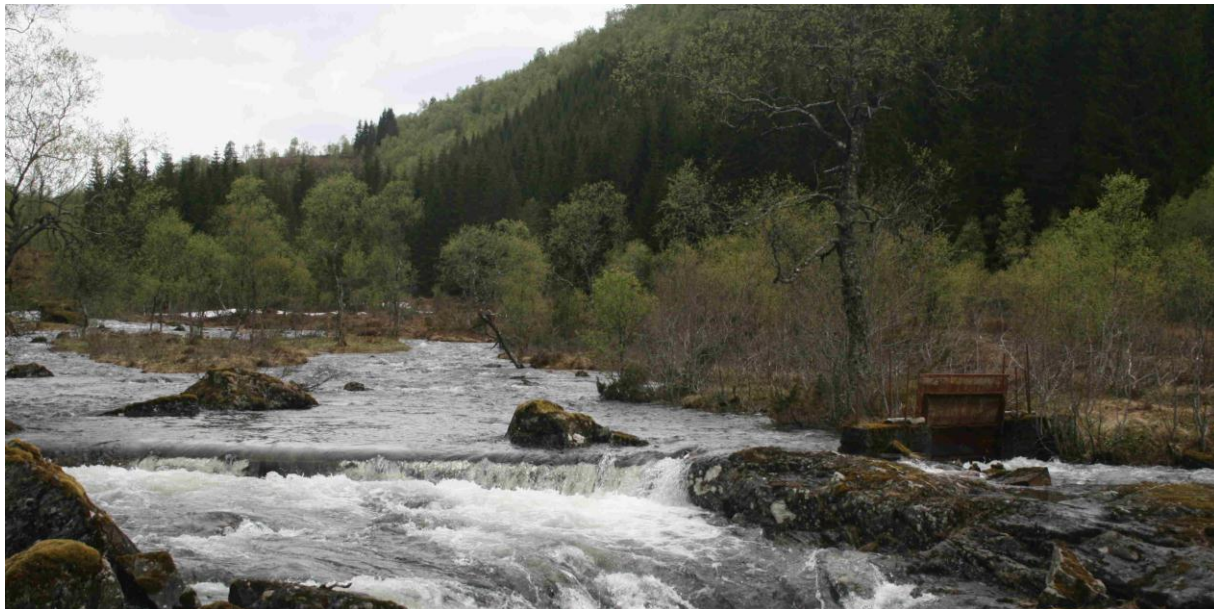
Figur 6. Dette biletet viser staden der deler av elva vert leia mot inntaket til det gamle Osdalen Kraftverk. Som ein ser er det ein leidemur til venstre på bilete, medan det er ein mur med ei jarnluke i framføre sjølv leidekanalen. (Foto; Karl Johan Grimstad ©).
