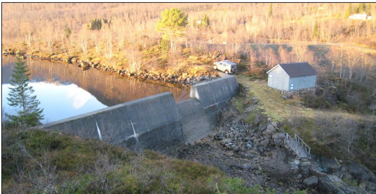
Figur 3 Sperredammen med flomløpsterskel ved Grøndalsvatnet. Fyllingsdammen ses i bakgrunnen.
