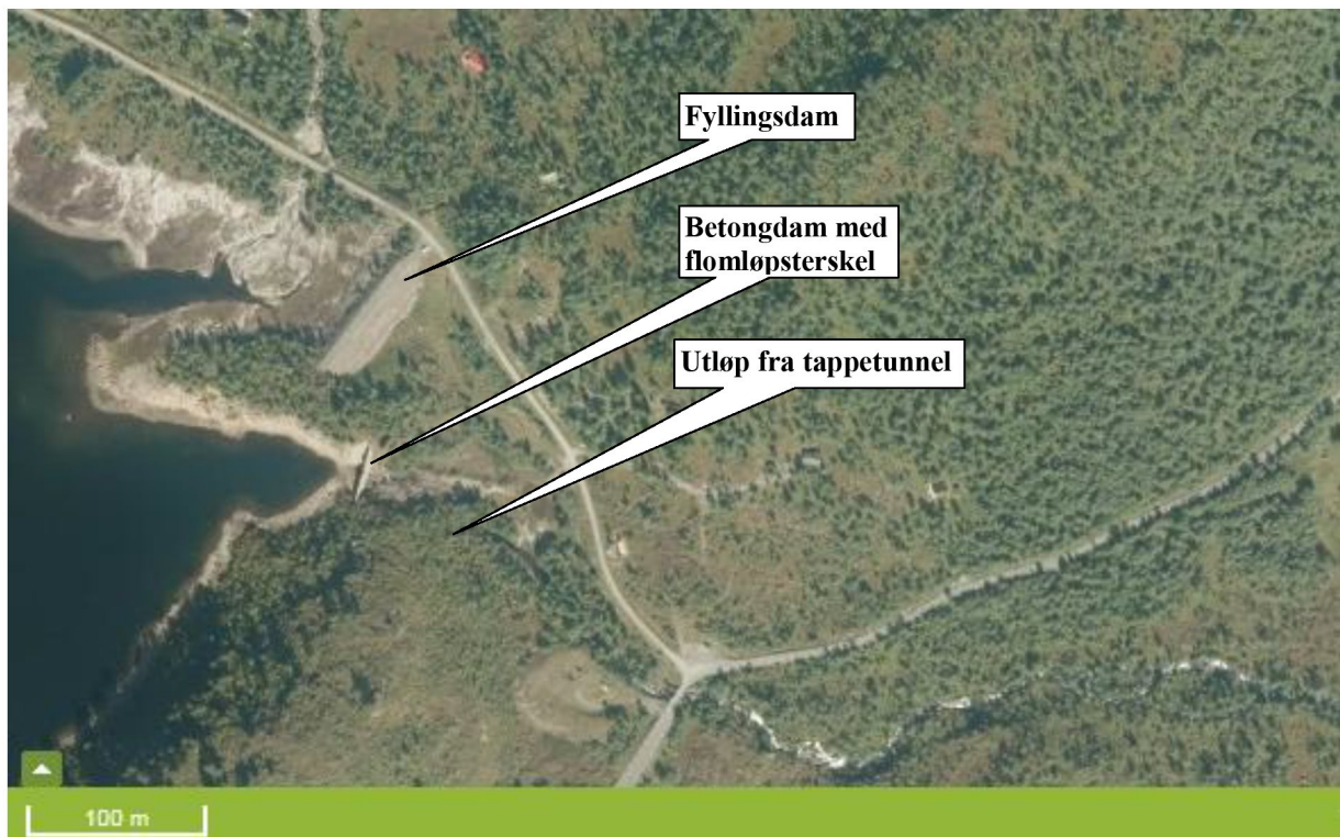
Figur 2 Dam Grøndalsvatn med fyllingsdam, flomløpsterskel og tappetunnel ( www.norgebilder.no )
