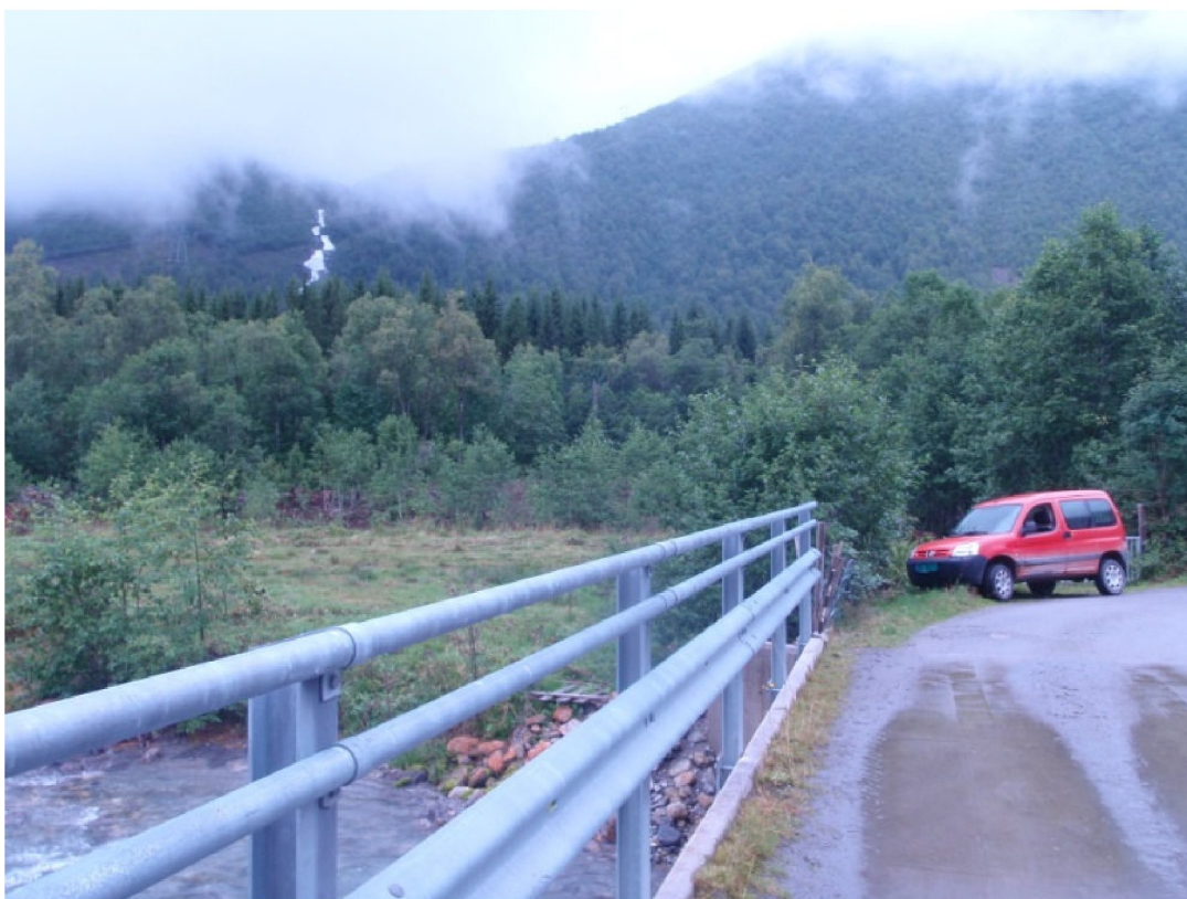
Bilde 14 Grøvdalen. Bru over Isa. Avkjørsel mot kraftstasjon bak bilen
