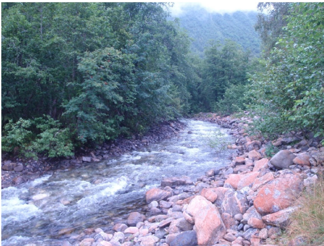
Bilde 15 Høgseterelva. Nedre partier. Kraftstasjon vil komme i bakkant til høyre med utløp til elva.
