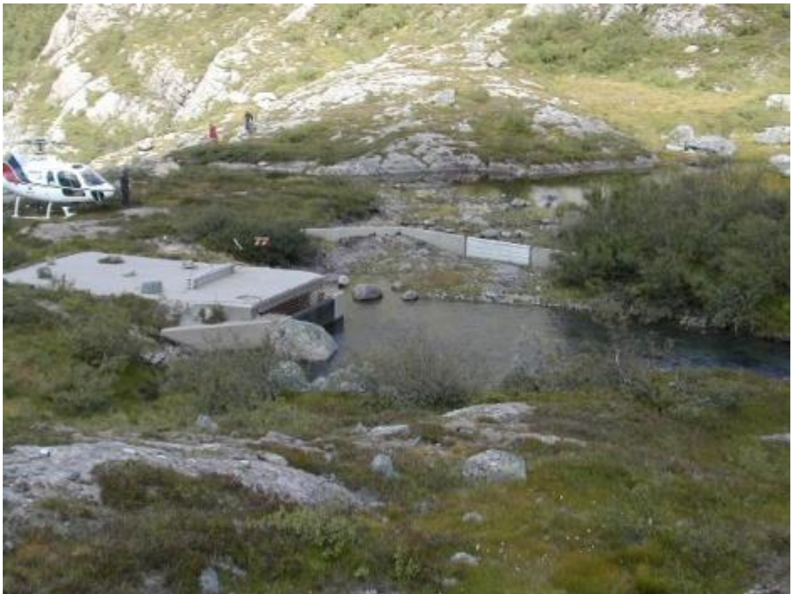
Dagens inntak Insteelva.
