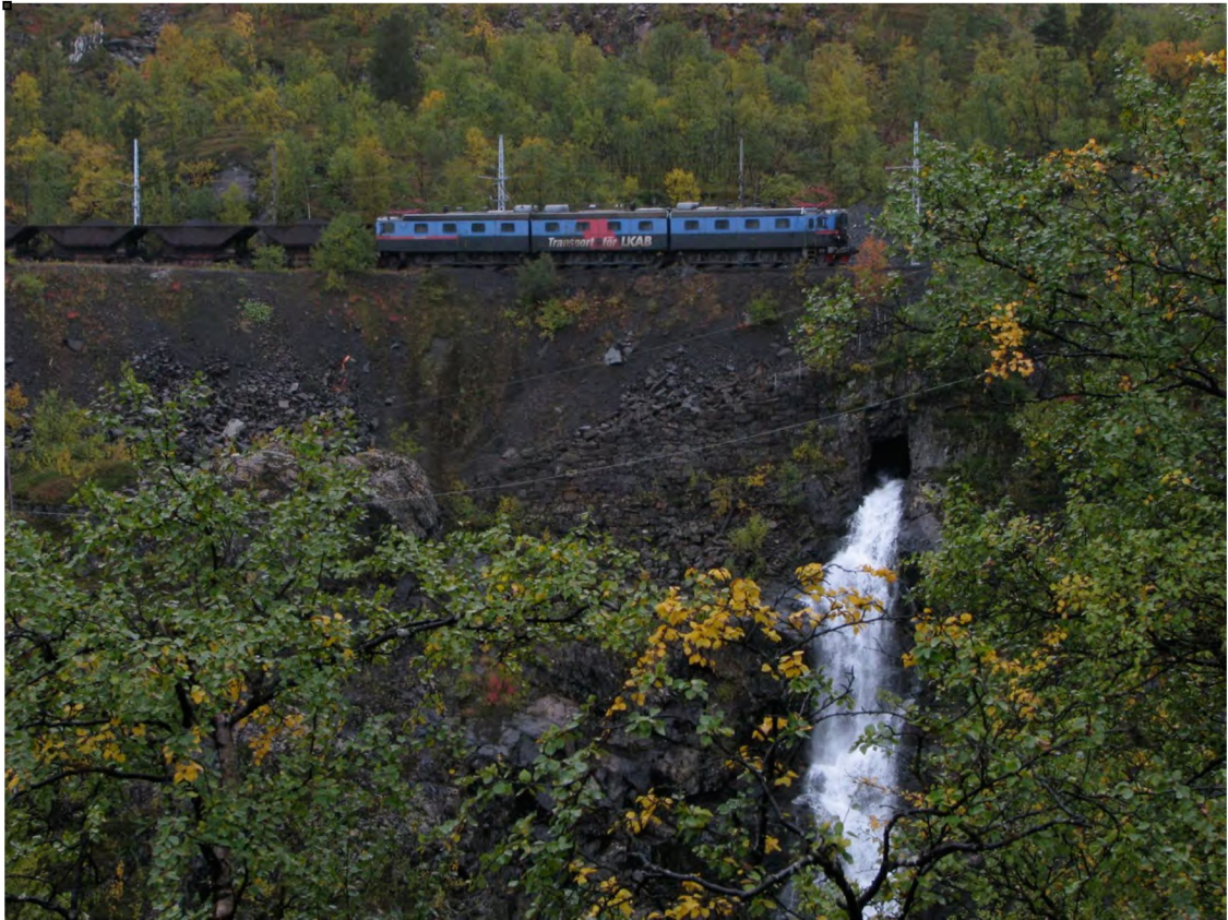
Figur 8. Ofotbanen krysser Raselva ved ca kote 260, og elva er ledet igjennom en sprengt tunnel ved krysningspunktet. Foto: Geir Arnesen.
