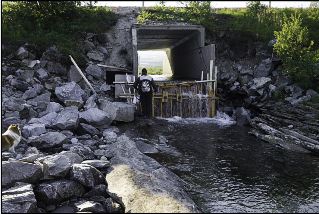
Figur 4-6. Ca 130 m oppstrøms det planlagte inntaket for kraftverket krysser elva riksveien. Kulverten under veien er et godt eksempel på hvordan du kan bygge et vandringshinder for fisk. Foto 16.08.2012 av Finn Gravem, Sweco.
