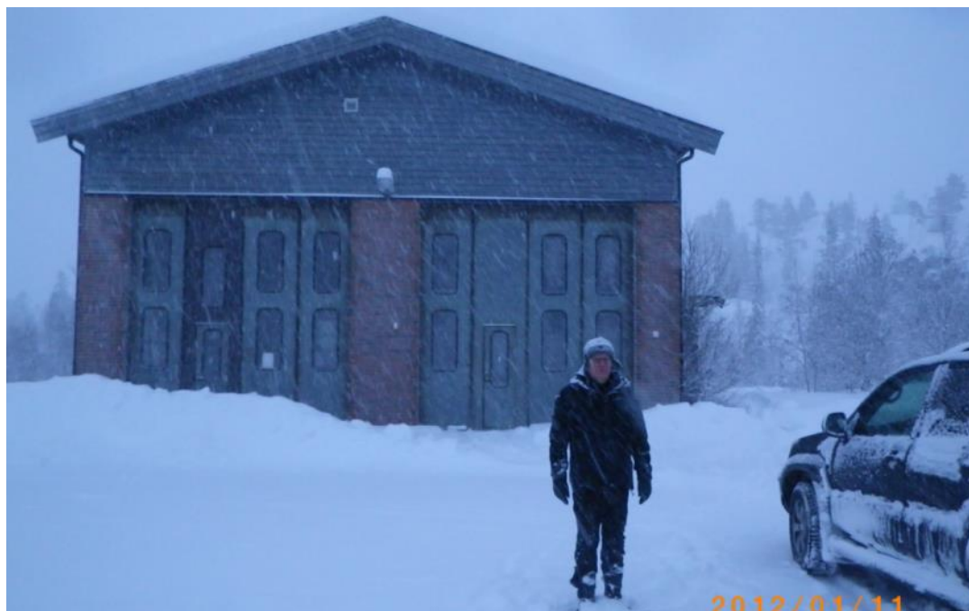
Figur 1-6. Brøytestasjon ved Fv 355 Melfjordveien.
