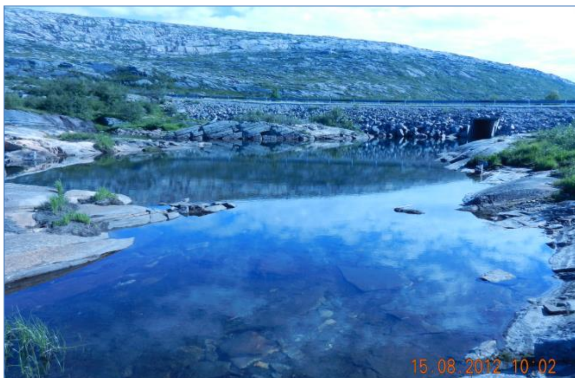
Figur 1-5. Tjern avgrenset av Fv 355 Melfjordveien. Kulvert i veifylling.
