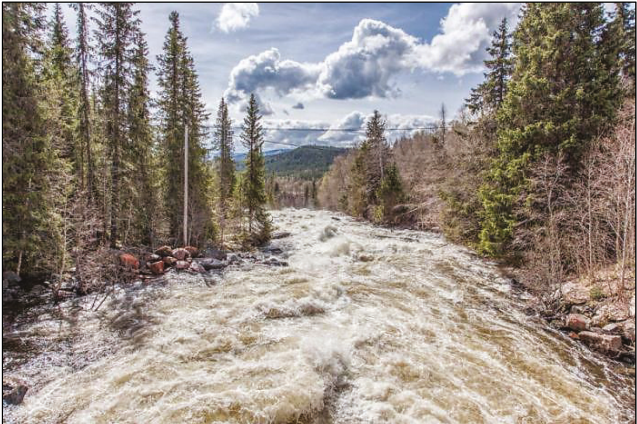
Figur 15-14 Langedalsbrue nedstrøms, høy vassføring i snøsmeltingsperioden. Vassføring 37 m 3 /s (foto: Skagerak Kraft)
