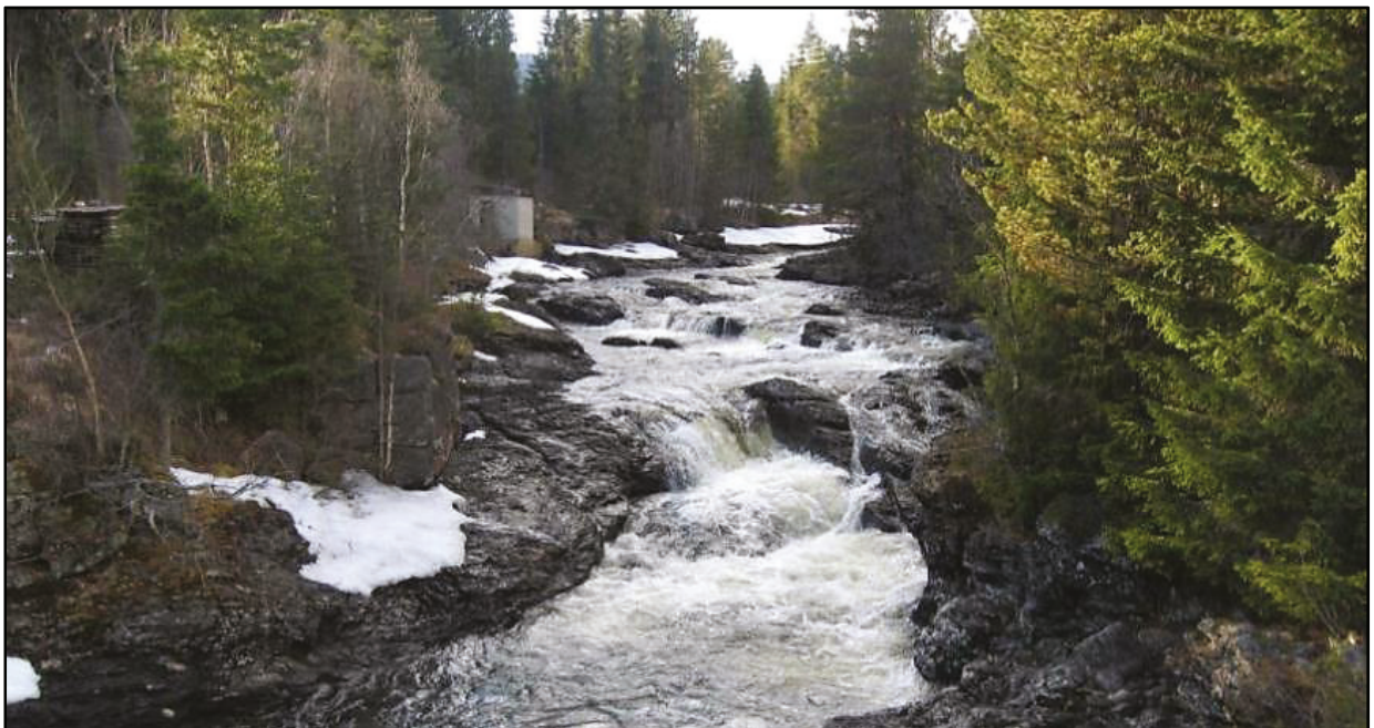
Figur 15-19 Oppstrøms Mossbrue. Vassføring 1,84 m 3 /s (foto: Skagerak Kraft)
