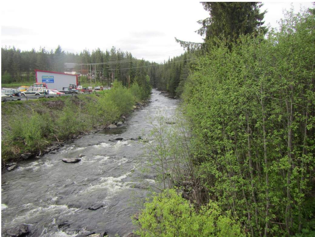
Figur 22 Vinda oppstrøms Vindefossen / Fv.51
