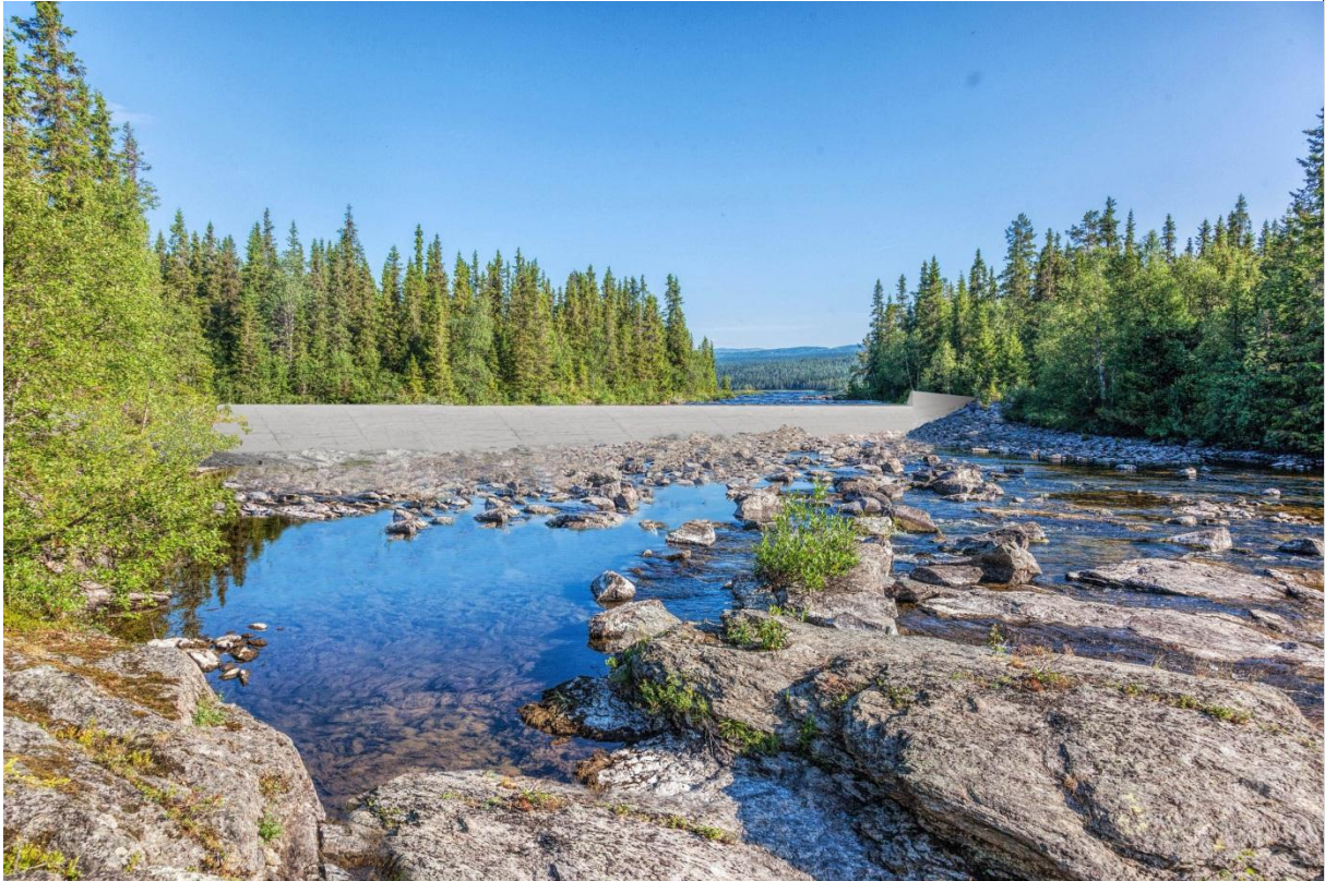
Figur 5-2. Enkel fotomanipulasjon av planlagt dam. Andre endringer som endret uttrykk som følge av arealbruk til anleggsområder m.m. er ikke tatt med. Lukehus ligger utenfor venstre billedkant.
