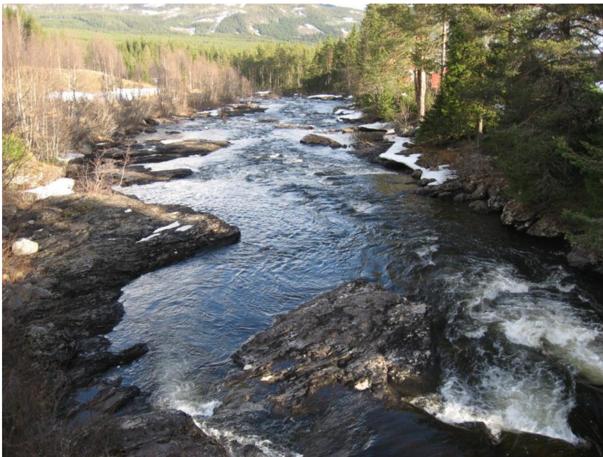
Figur 5-7. Nedstrøms Mossbrue. Vannføring 1,84 m 3 /s
