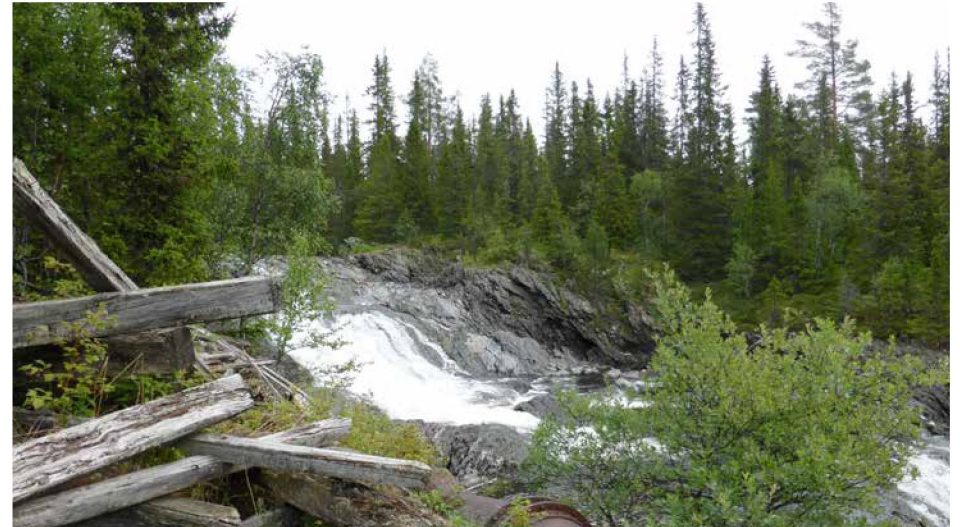
Vinda ved Møllefossen, lav vassføring ca. 0,8 m 3 /s.
