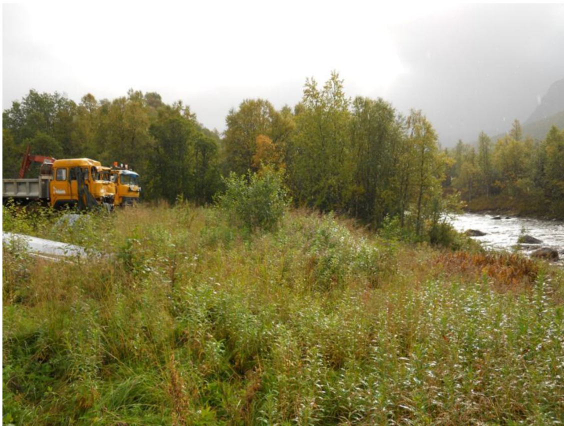
Bilde sett oppover langs Tømmerelva mot kraftstasjonsområde
