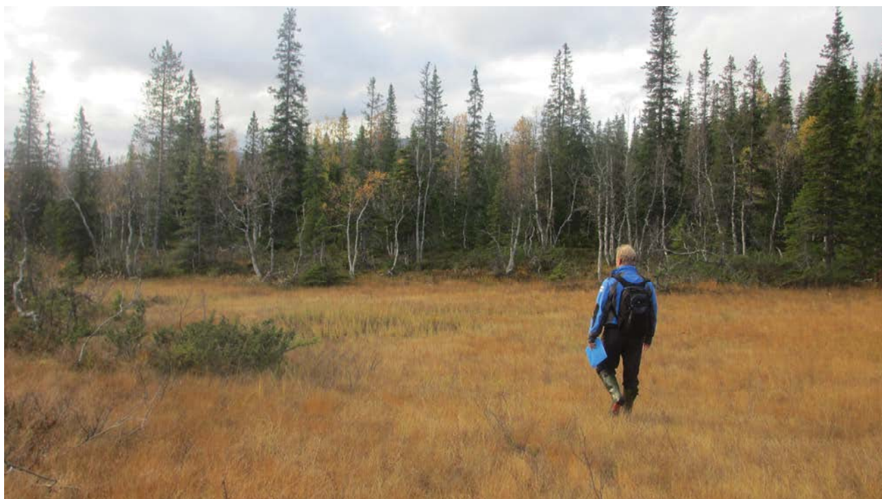
Figur 10 Rørtrasé frem mot kraftstasjon, Storsteinåa renner på baksiden av granrekken.
