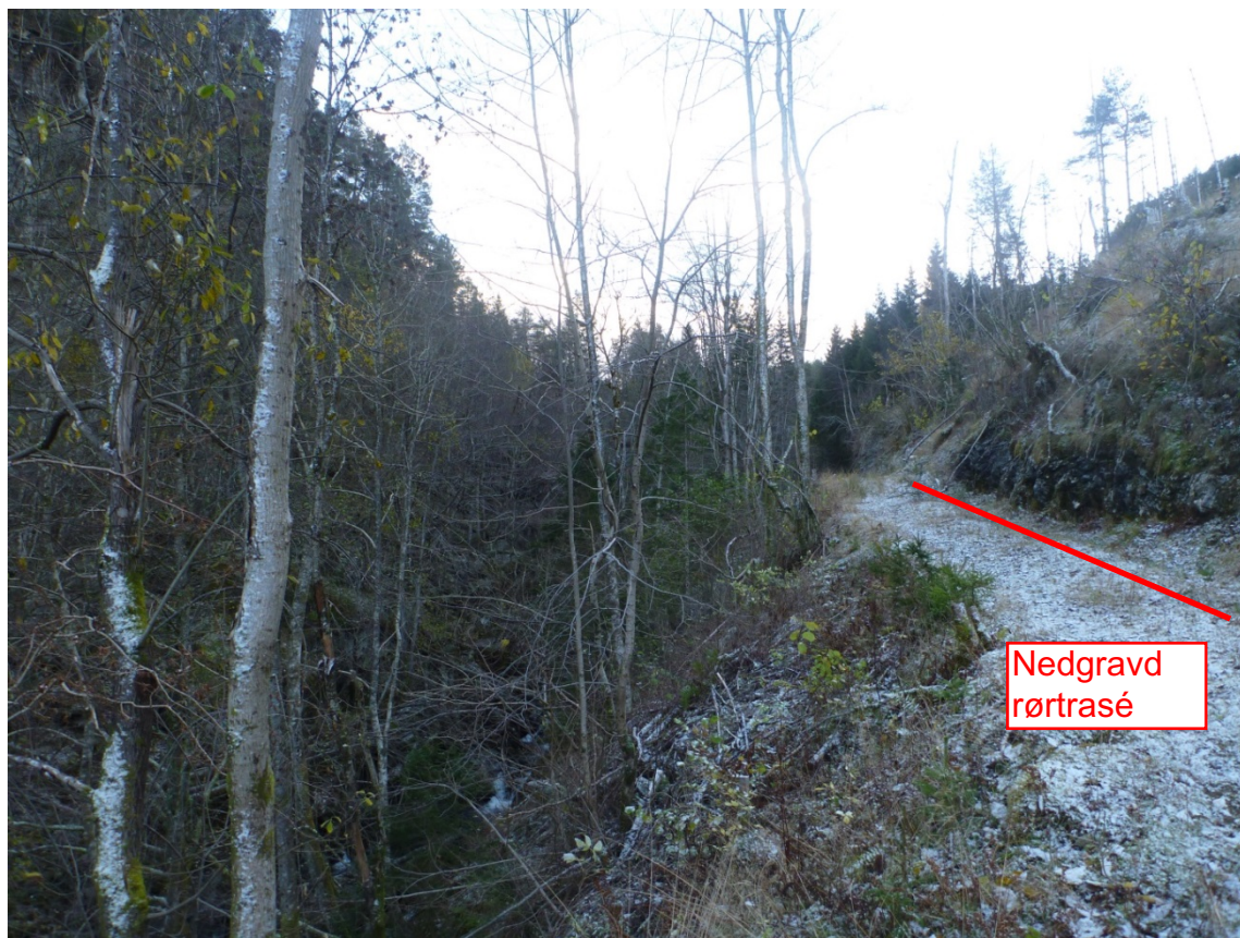
Figur 7: Rørtrasé i eksisterende traktorvei.
