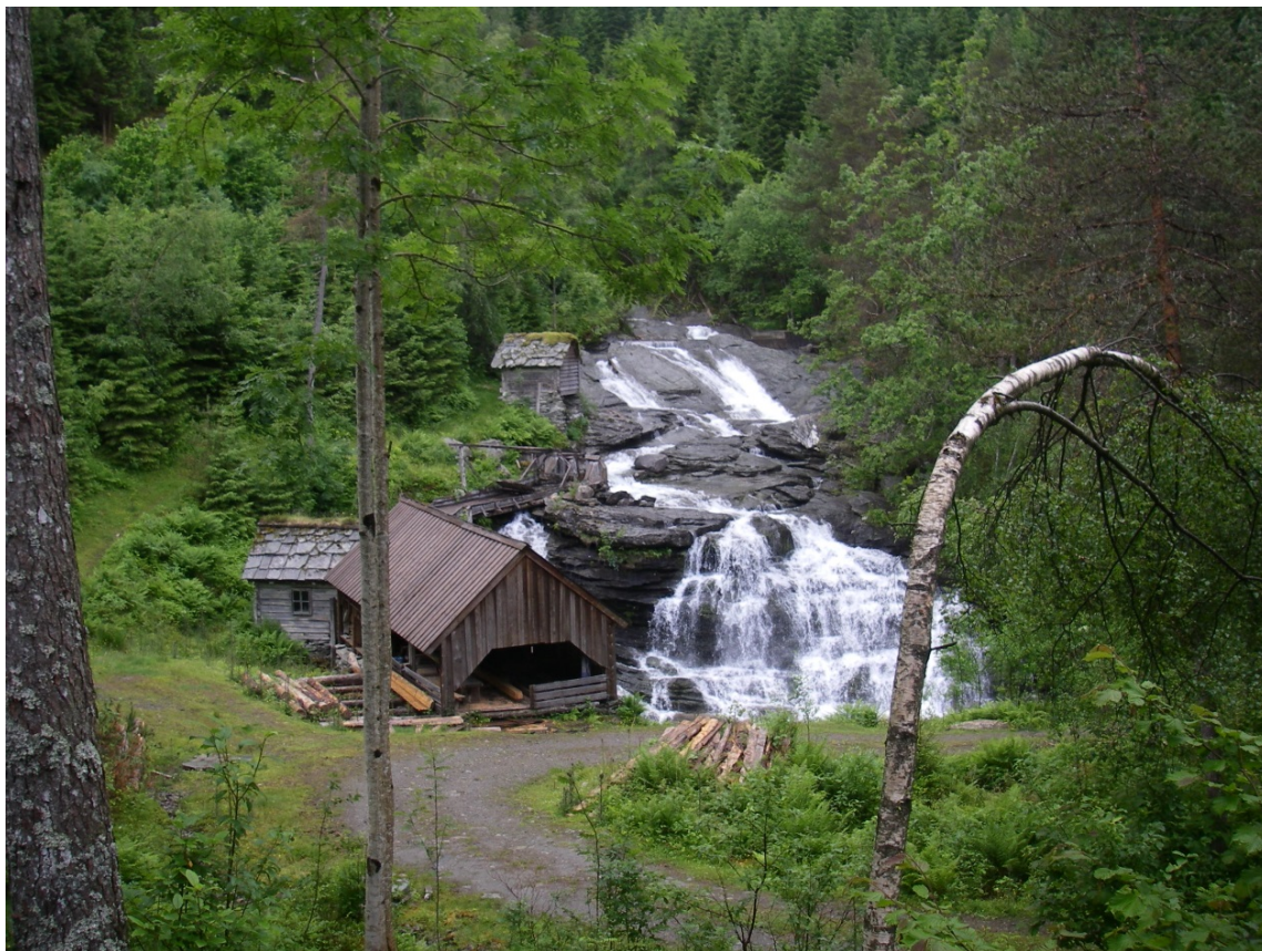
Figur 14: Vannmøllen nedstrøms inntaket. Vannføringen er anslått til å være 100–200 l/s. Dato: 29.06.2012
