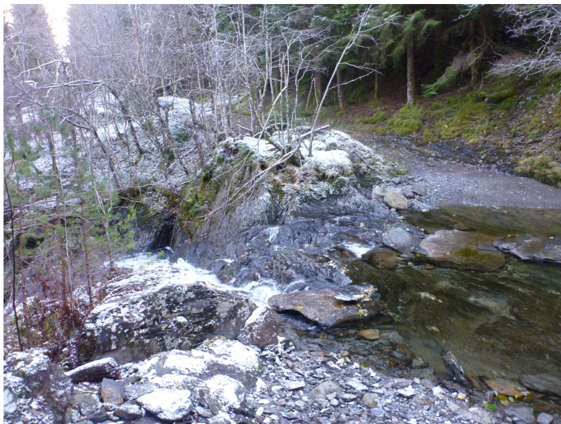
Figur 12: Inntaksområdet. Terskelen vil komme midt i bildet. Vannføringen er anslått til å være 100-200 l/s. Dato: 25.10.2012
