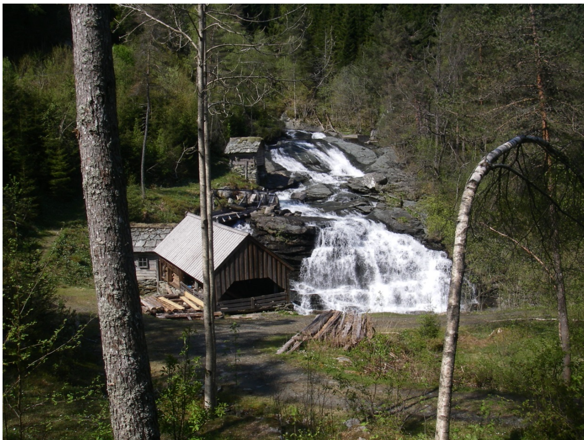
Figur 15: Vannmøllen nedstrøms inntaket. Vannføringen er anslått til å være 200–300 l/s. Dato: 21.05.2012
