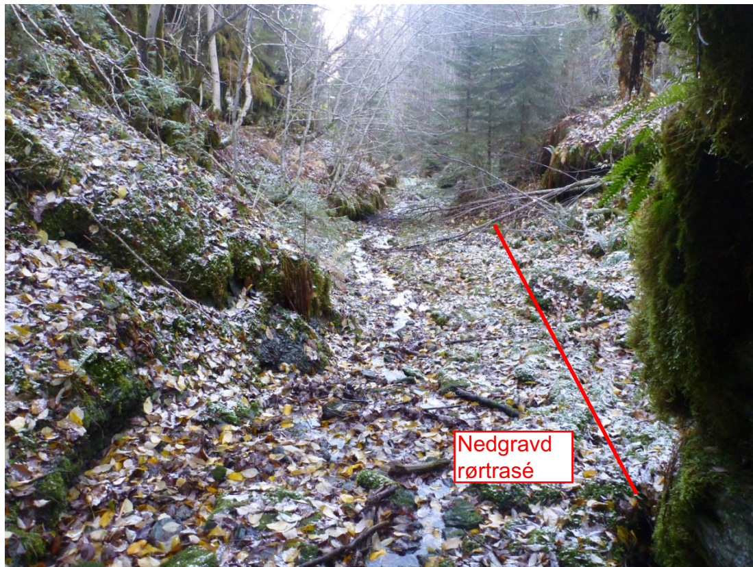
Figur 5: Rørtrasé øvre strekk. Legges til høyre i bildet, evt drenerende masser.
