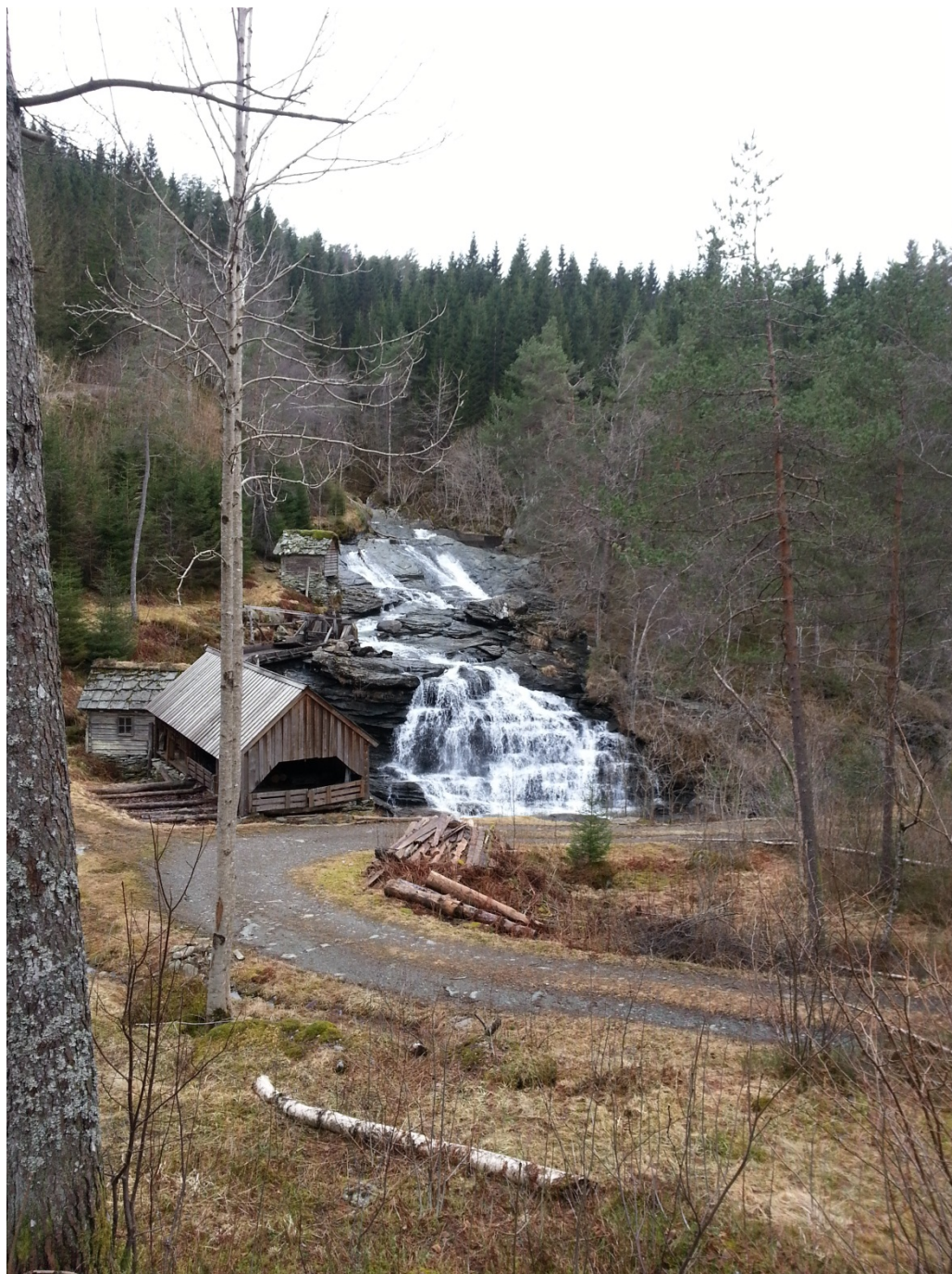
Figur 13: Vannmøllen nedstrøms inntaket. Vannføringen er anslått til å være < 150 l/s. Dato: 28.02.2014
