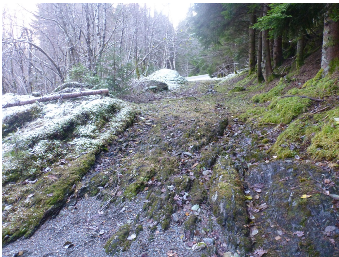
Figur 4: Adkomstvei for bygging av inntaksdam. Riggområde og vei bakerst i bildet.
