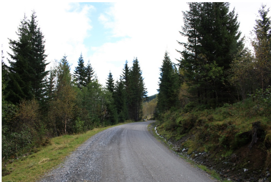
Figur 10 Rørtrase frå Steindalselva. Rørgate bygges i vegskulder.
