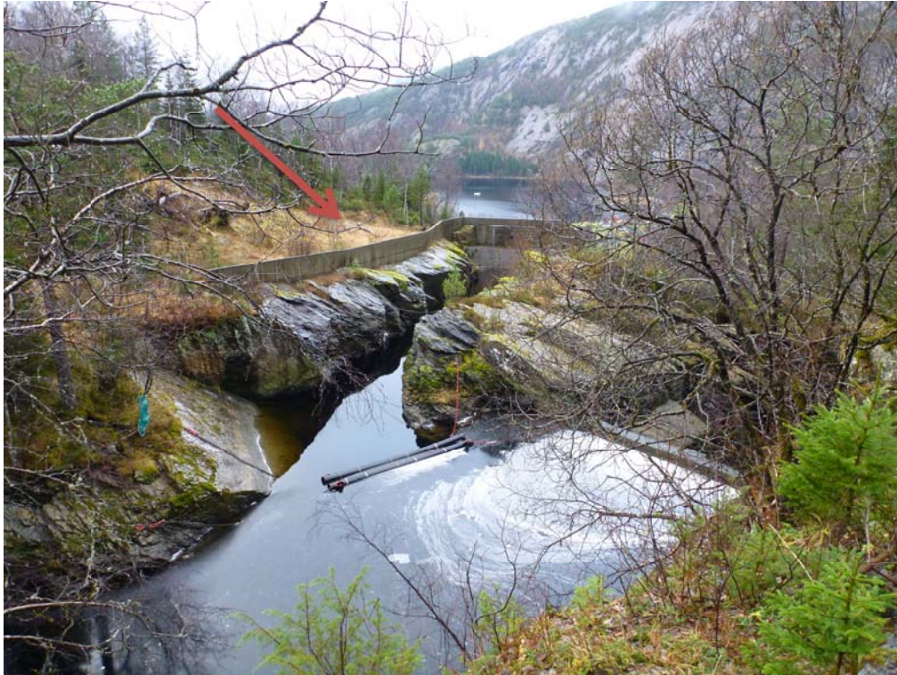
Figur 23 Kleivaelva, inntak Skolten kraftverk. Steindal kraftverk bygges med avløp ut i inntakskanalen. Pilen marker ca plassering av kraftverket
