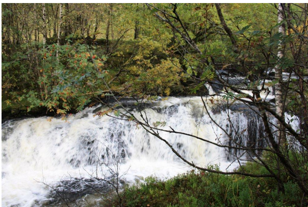
Figur 4 Steindalselva ved planlagt inntak , høy vannføring
