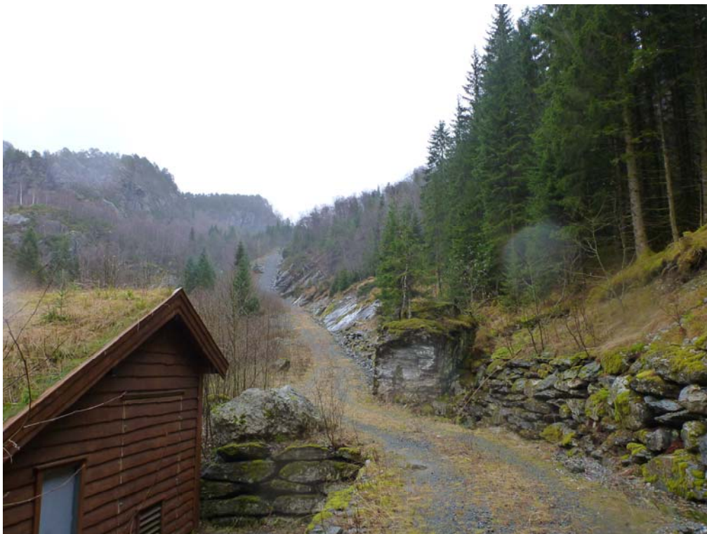
Figur 2 Rørtrase til Skolten kraftverk – Traseen nyttes som tilkomst til Steindal kraftverk
