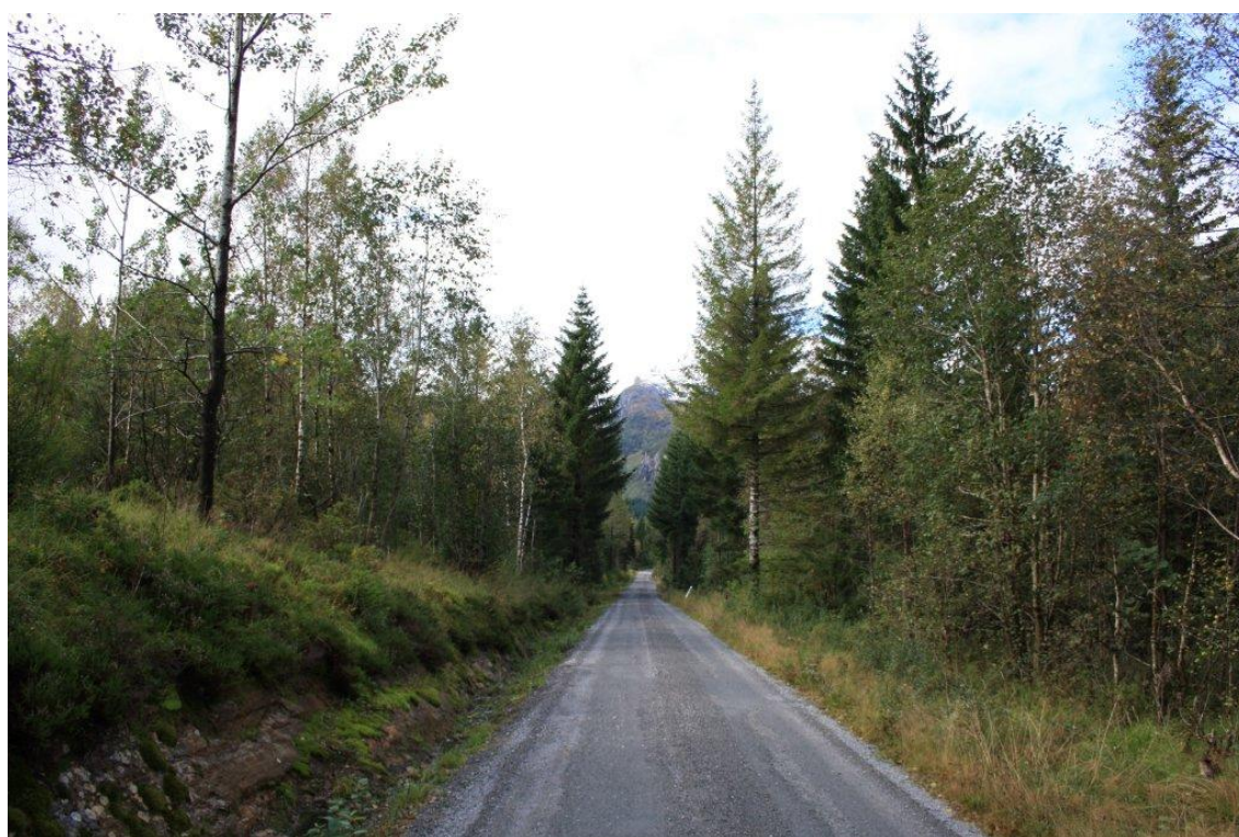
Figur 12 Rørtrase frå Steindalselva. Rørgate bygges i vegskulder. Sett nedover
