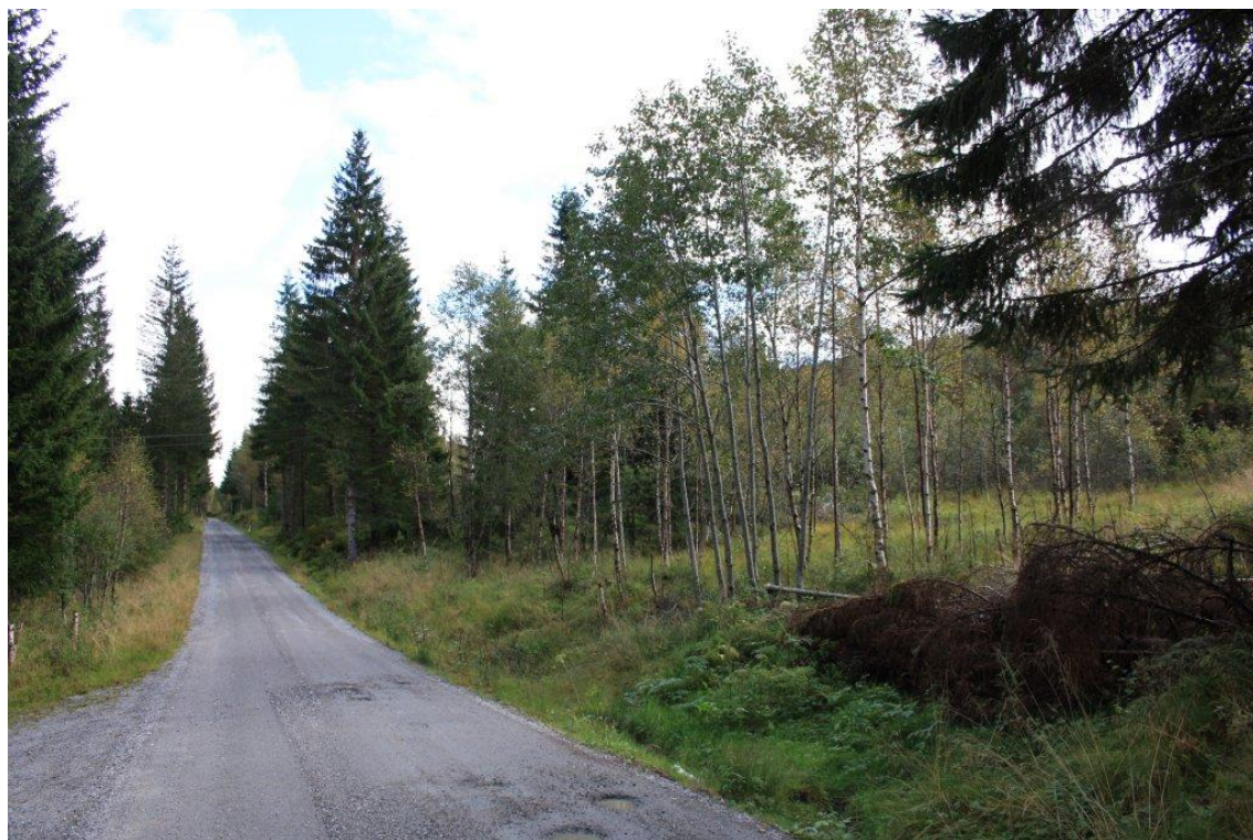
Figur 11 Rørtrase frå Steindalselva. Rørgate bygges i vegskulder.
