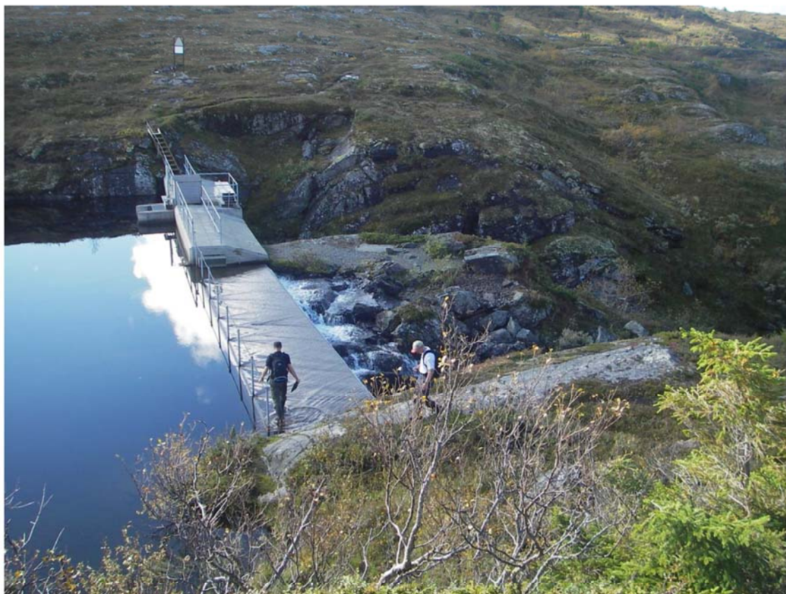
Bilde 3 Eksisterende dam, sett mot sør.
