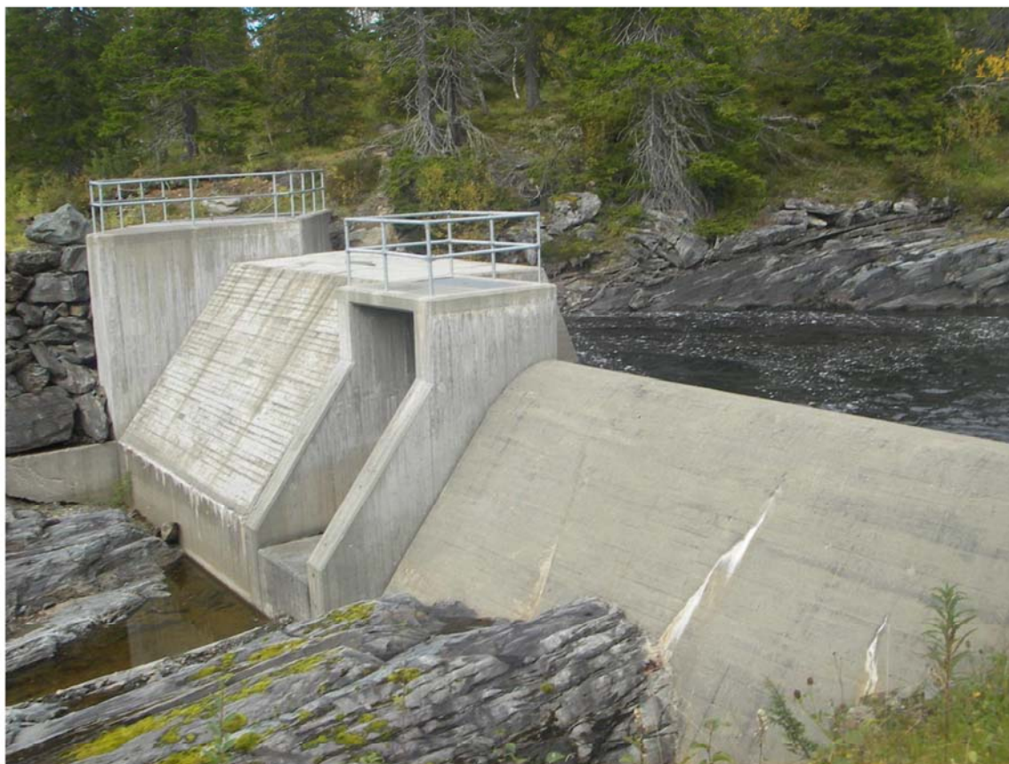
Bilde 15 Eksisterende bekkeinntak
