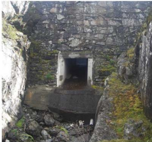
Figur 5 Inntaksløsning. Viser prinsipiell tenkt løsning for inntak, hvor et kammer etableres på nedstrøms side av dam, som vist til høyre (eksisterende strukturer i gråtoner, nye komponenter i sort). Til venstre ses eksisterende tappeløp sett nedstrøms dam, hvor kammeret er tenkt etablert.
