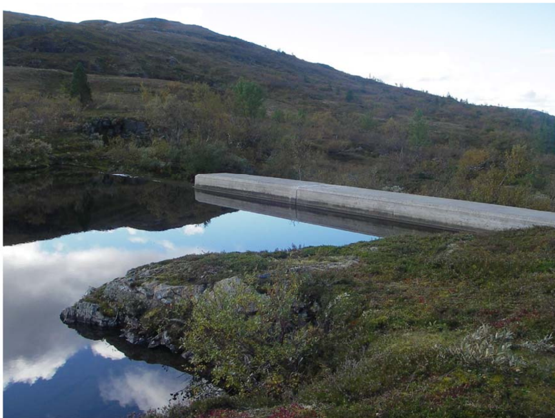
Bilde 5 Eksisterende sperredam. Sperredammen ligger ca 325 m sørvest for reguleringsdammen.
