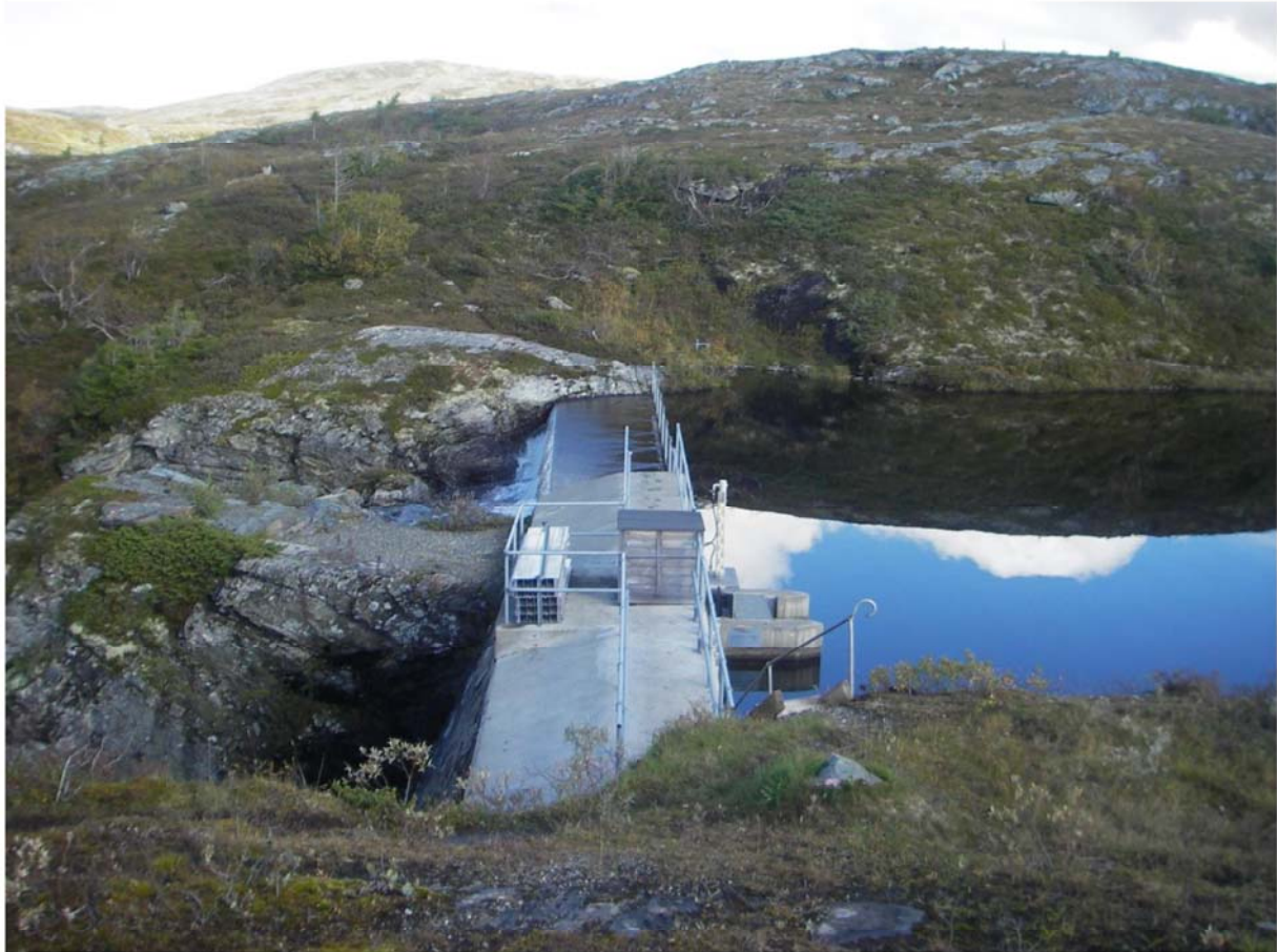
Figur 10 Reguleringsdammen ved Skurdalssjøen. En merket tursti går over dammen.
