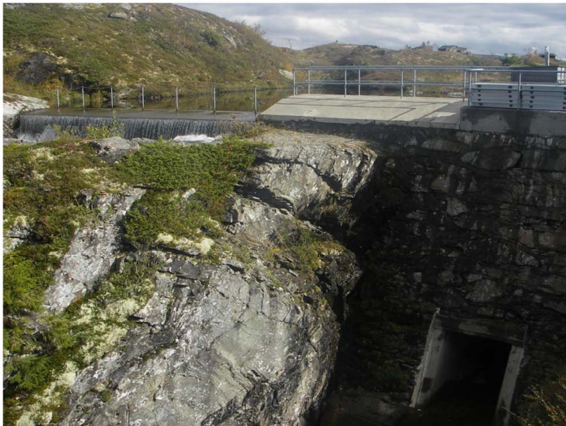
Bilde 6 Reguleringsdam sett fra nedstrøms side.
