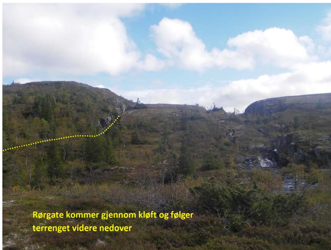
Bilde 13 Skurdalsåa krysser fra høyre (sør) over mot venstre (nord). Tenkt rørtrase i kløft til venstre i bildet.
