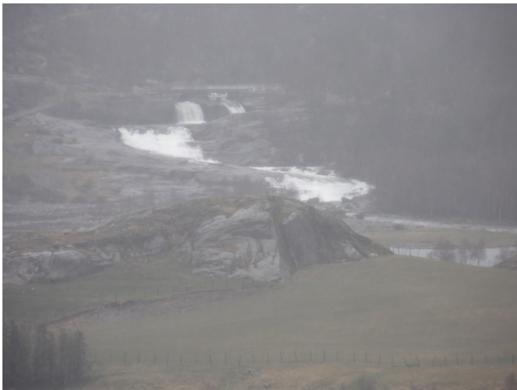
Foto 9 Nedre fossefall Traktorvei ses i venstre del av bildet Foto er tatt 02.05.16 14:30 Vannføringen er vurdert til å være omtrent 6-6,5m 3 /s
