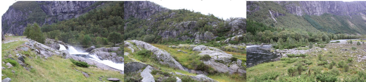
Nedre del av tiltaksområdet, med nedre fossefall, nedre del av rørtrasé og ca kraftstasjonstomt.
