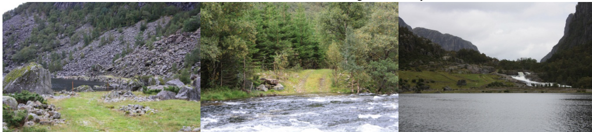
Veien langs Roaldsvatnet oppgraderes. Veien krysser elva nedenfor tiltaksområdet. Oversikt over nedre del av området.
