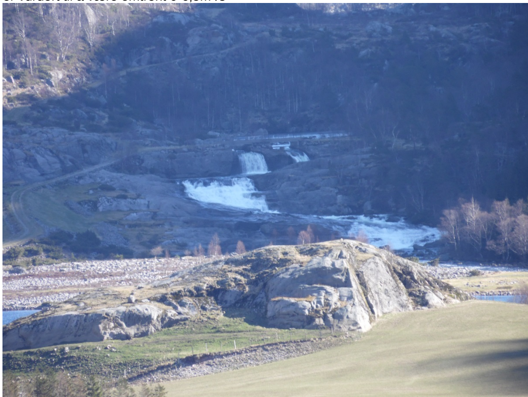
Foto 10 Nedre fossefall Traktorvei ses i venstre del av bildet Foto er tatt 17.04.16 11:00 Vannføringen er vurdert til å være omtrent 6,5 m 3 /s
