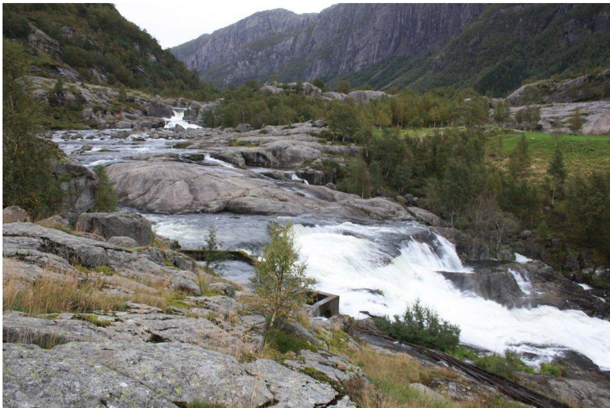
Foto 3 Inntak til gammelt kraftverk ved fossen sett mot planlagt inntak Foto tatt 13 september 2012. Vannføring er vurdert til å være omtrent 8 -9 m 3 /s
