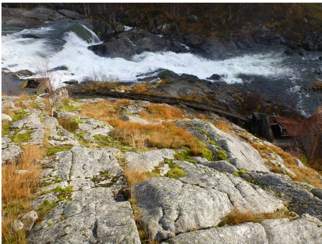
Foto 4 Inntak til gammelt kraftverk ved fossen. Foto tatt 23 oktober 2012. Vannføring er vurdert til å være omtrent 8 m 3 /s
