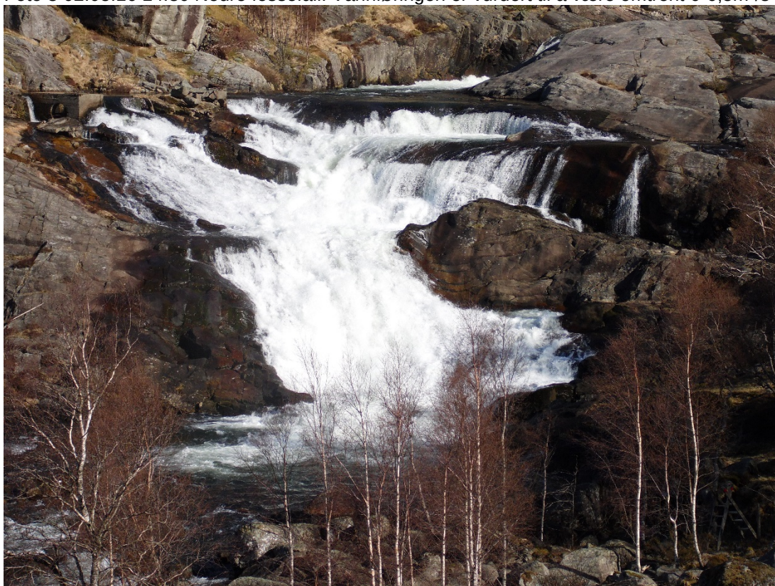
Foto 9 17.04.16 11:00 Nedre fossefall. Vannføringen er vurdert til å være omtrent 6,5 m 3 /s
