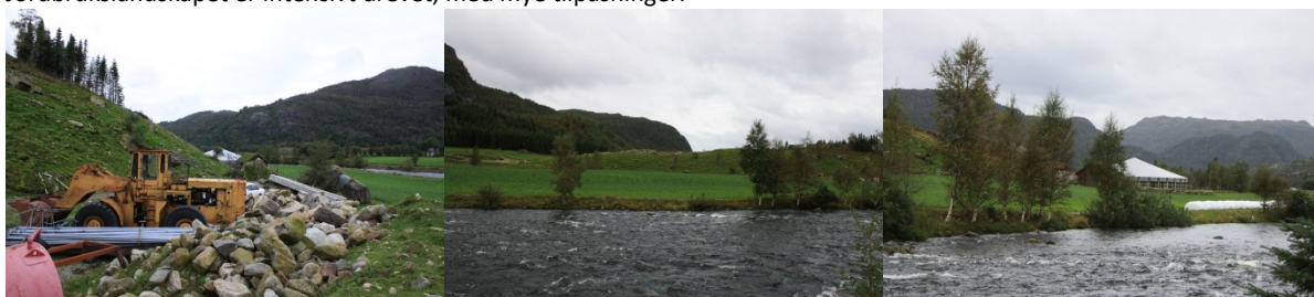
Ved plassering av kraftstasjonen med utløpskanal er elva nokså bred med få store blokker og har god fart mot Espelandsflæet.
