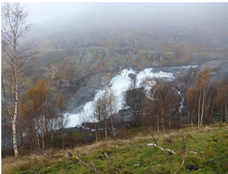
Figur 3: Fossen som utgjør hovedfallet på strekningen. Man ser også blankskurt fjell. Restene av nedlagt kraftverk kan skimtes
