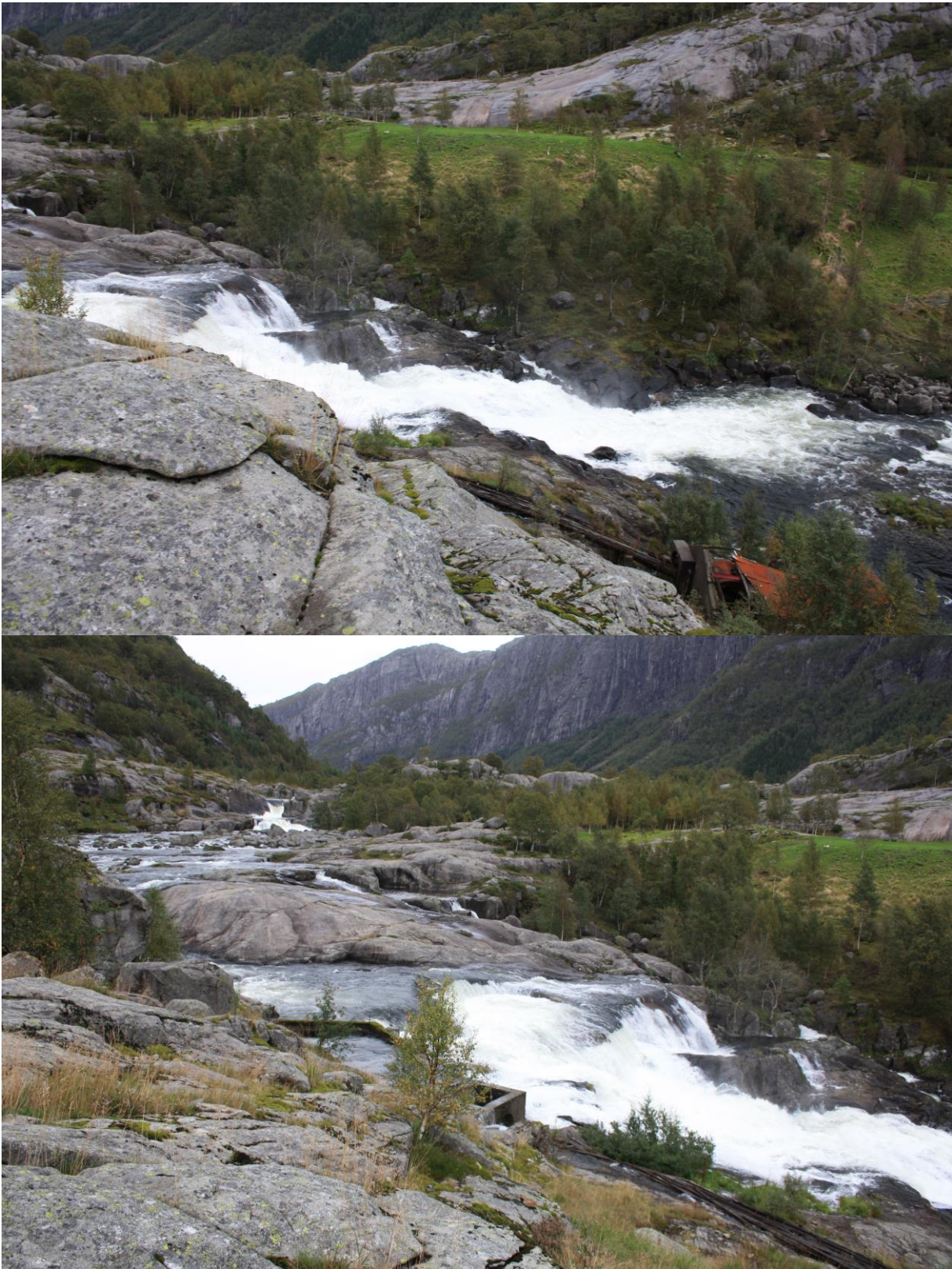
Figur 4. Bilete frå fossen. I forgrunnen ser ein restar etter eit tidlegare kraftverk. Foto Anne Nylend.
