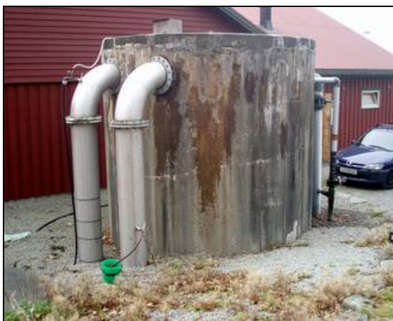
Figur 3. Anlegget har fire vanninntak i Krossvatn ( øverst til venstre ). Vannet ledes inn i et inntakshus ( øverst til høyre ) og videre ned til anlegget via to ledninger til en nivåtank ( nede til venstre ) hvor vannet tilsettes oksygen ( nede til høyre ) før vannet fordeles rundt til de ulike avdelingene til anlegget.
