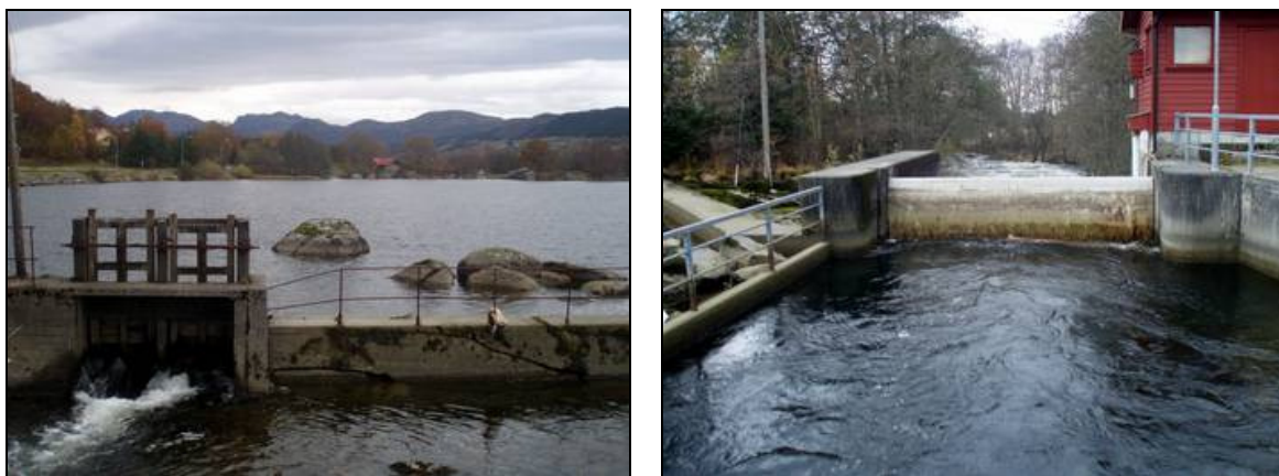
Figur 5. Ved det nordligste utløpet av Bjørheimsvatnet er det en dam med manuell tappeluken for settefiskanlegget ( til venstre ), mens det sørligste utløpet er regulert med en dam for kraftverket som styres maskinelt ( til høyre ).
