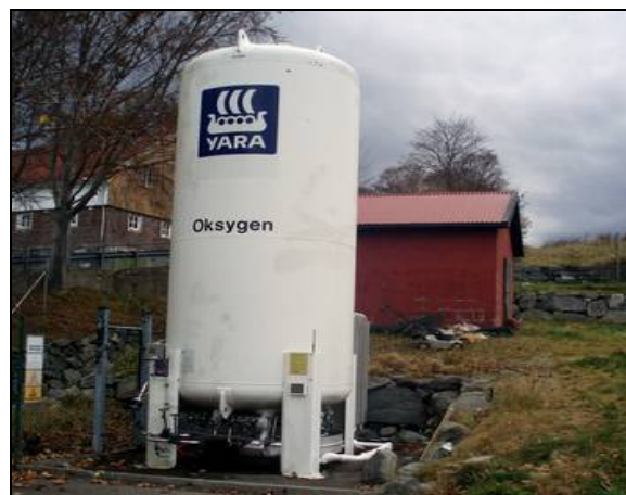
Figur 3. Anlegget har fire vanninntak i Krossvatn ( øverst til venstre ). Vannet ledes inn i et inntakshus ( øverst til høyre ) og videre ned til anlegget via to ledninger til en nivåtank ( nede til venstre ) hvor vannet tilsettes oksygen ( nede til høyre ) før vannet fordeles rundt til de ulike avdelingene til anlegget.
