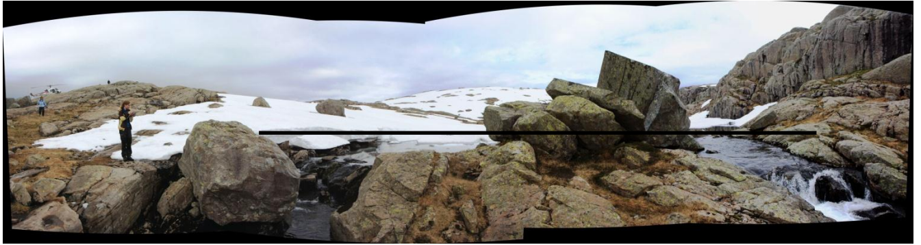
Bilete 7 Utløpet av Vatn 731/ Ludvikbotnevatnet sett frå bakkenivå. Plasseringa av dammen er markert med den svarte lina.
