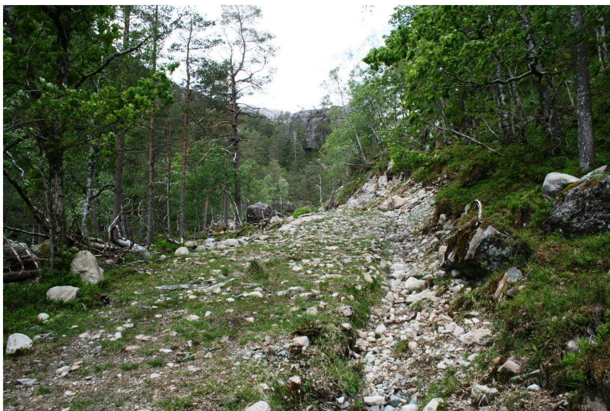
Bilete 16 Eksisterande drifteveg/planering ved massedeponi. Vegen er planlagd opprusting i samband med veg til kraftstasjonen. Biletet er tatt i nordaustleg retning.
