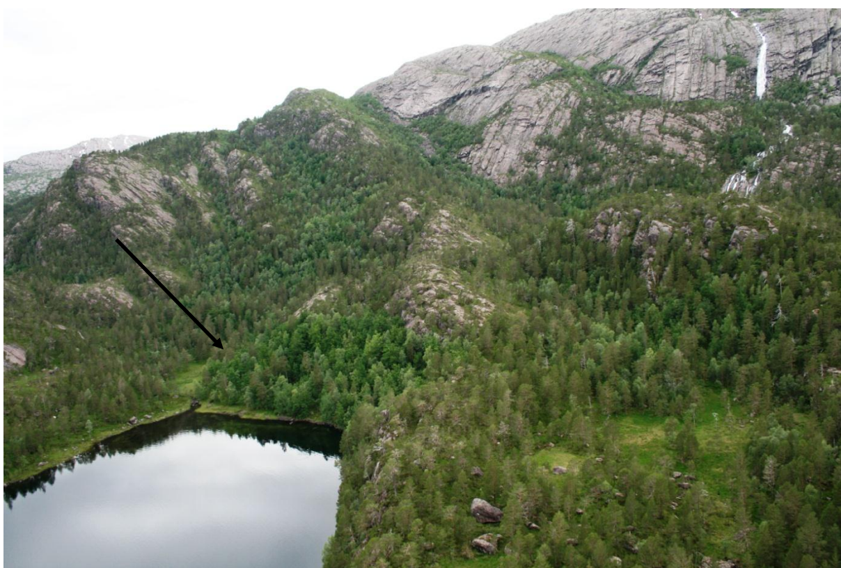
Bilete 12 Storevika til venstre og Grønskredfossen til oppe til høgre. Kraftstasjonsplasseringa er markert med den svarte pila. Biletet er teke frå helikopter.
