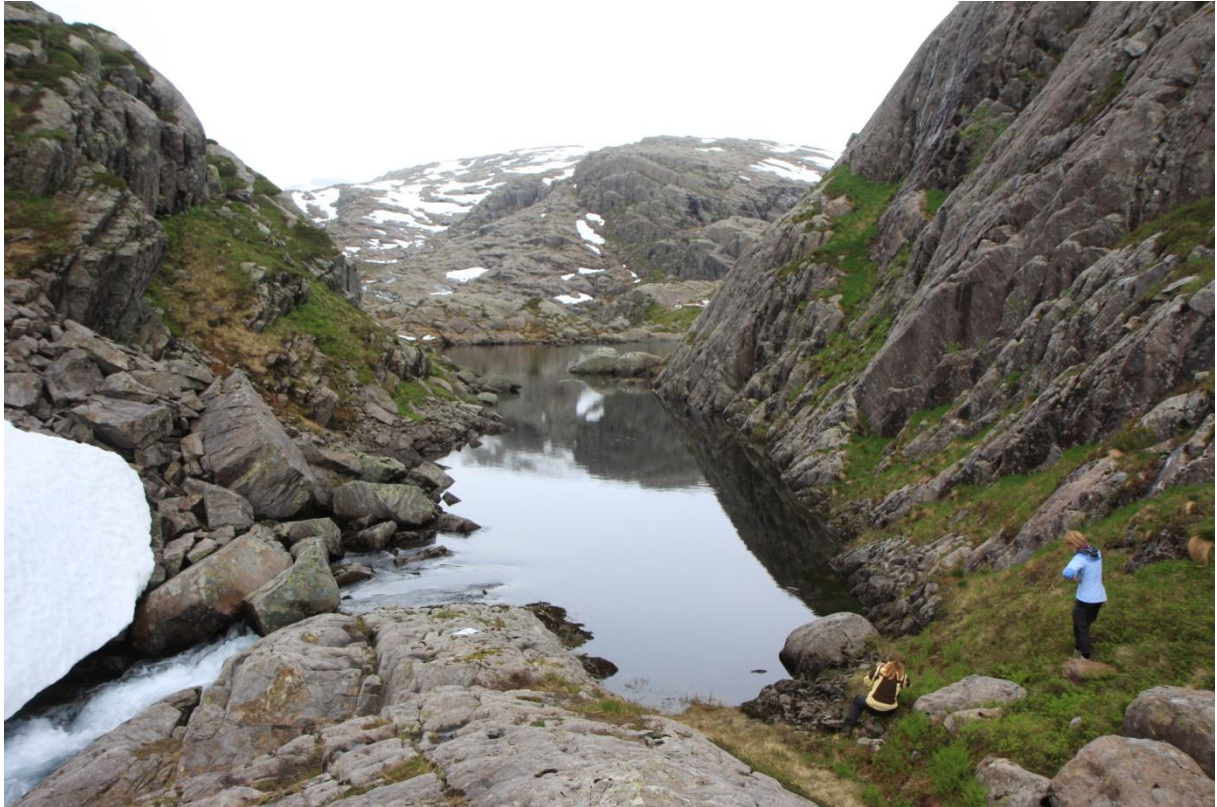
Bilete 3 Inntaksområdet sett oppstrøms frå bakkenivå.
