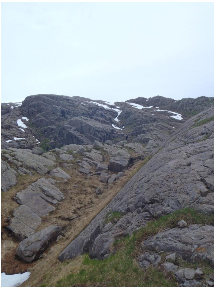
Bilete 8 Utløp overføringstunnel i naturleg søkk i terrenget. Søkket leiar vatnet til Grønskredvatnet.
