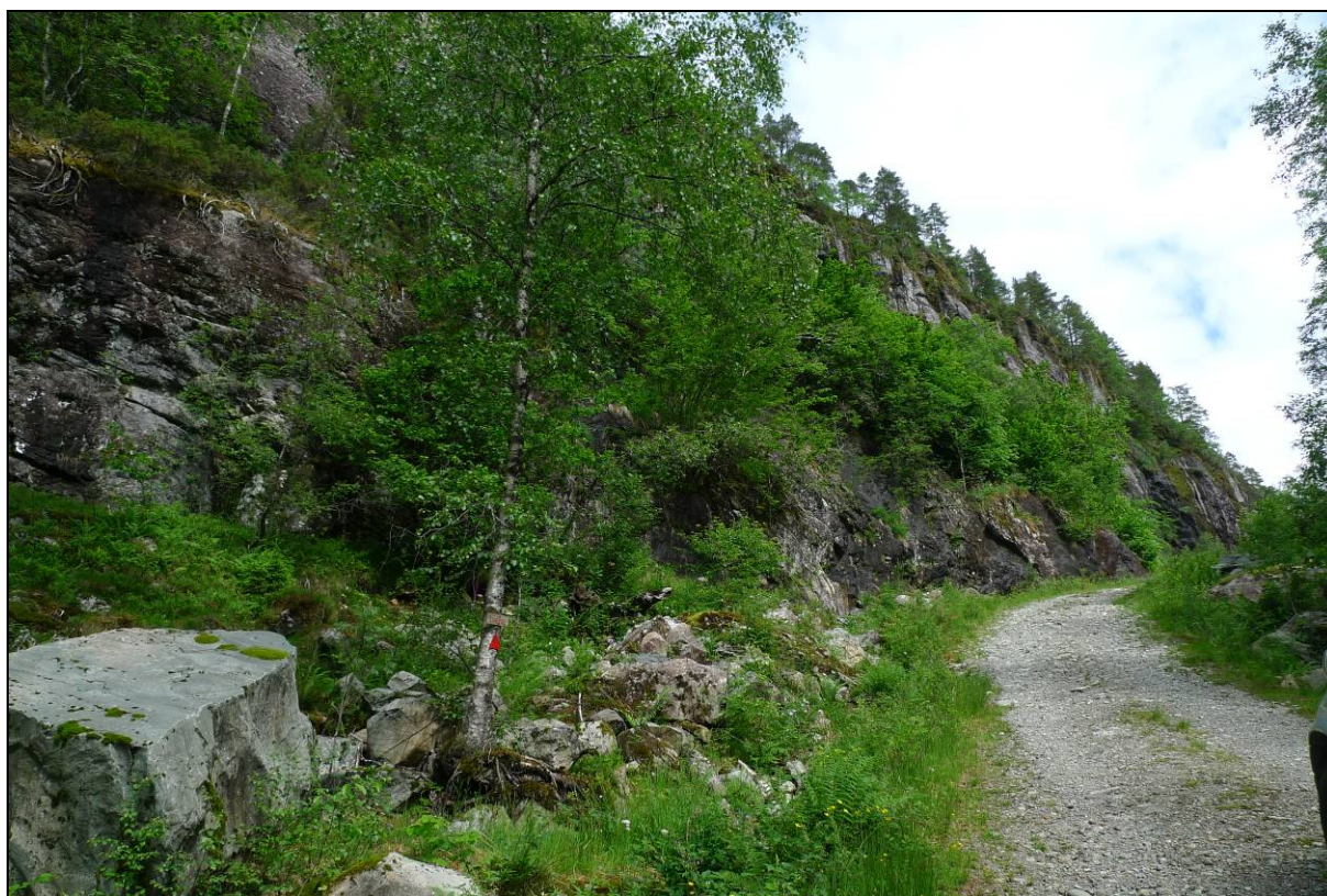
Bilete 4 Påhogg på utløpssida for tunnelalternativ A ligg omtrent der vegen svingar mot høgre på bilete.
