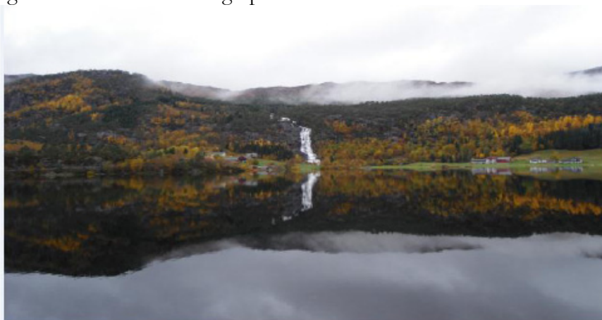
Løkkebø kraftverk sett fra motsatt side av Løkkjebøvatnet. Dato 18.10.2008 klokken 16.35. Anslått vannføring er 6000 l/s.
