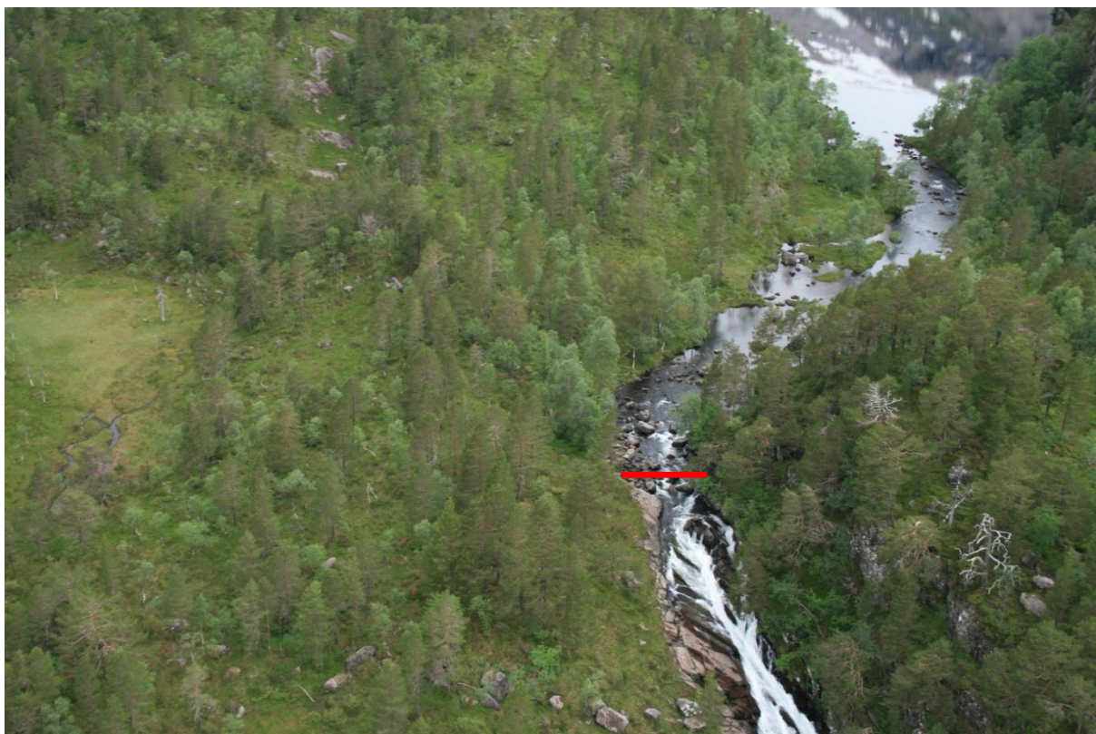
Bilete 6 Utløpet fra Hestedalsvatnet sett fra helikopter. Den raude lina viser plassering av dam. Inntaket vil bli etablert til venstre for dammen på bildet.
