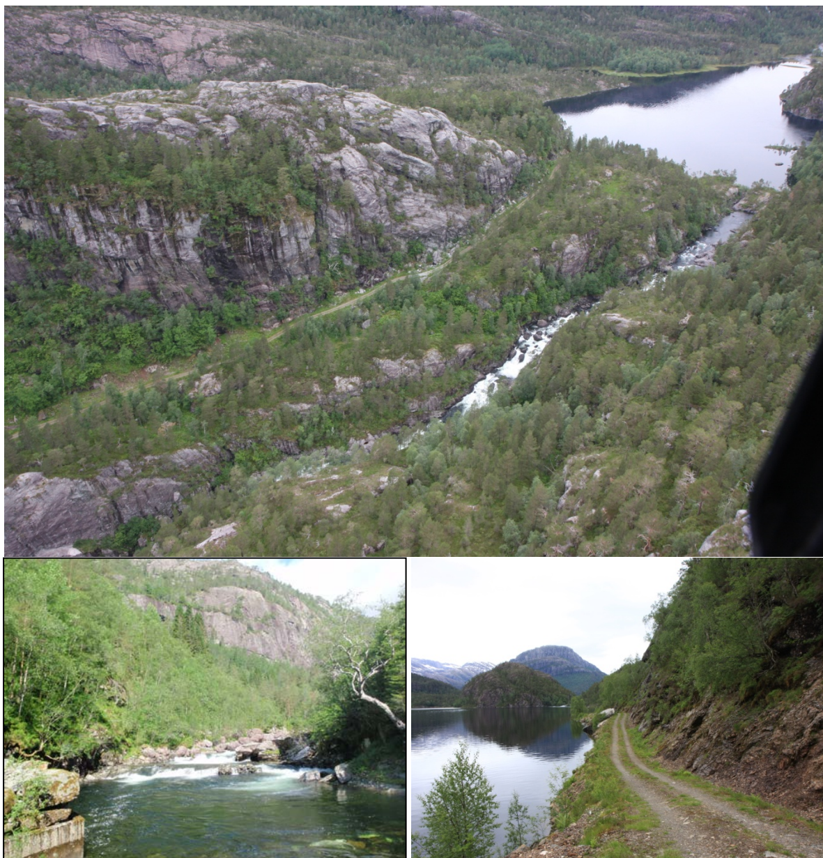
Figur 3-3 Bilete av Litlevatnet, Norddalselva og omkringliggende landskap på prosjektsrekninga. Øvst: Litlevatnet og øvre del av prosjektsrekninga av Norddalselva. Nedst til venstre: Område for planlagd kraftstasjon. Nedst til høyre: Område for planlagd inntak ved Litlevatnet.
