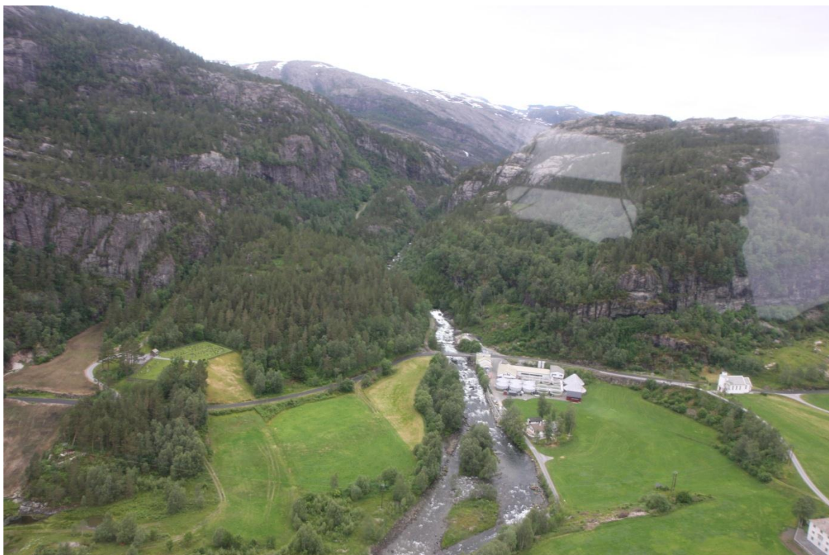
Bilete 10 Området nedstrøms utløpet fra kraftverket. Biletet viser bru over elva (fylkesveg 544) og Firda Settefisk sitt anlegget til høyre.
